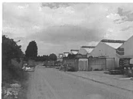
Foto 4. Opslag van afvalmaterialen en dergelijke aan de achterzijde van de bouwmarkt.
