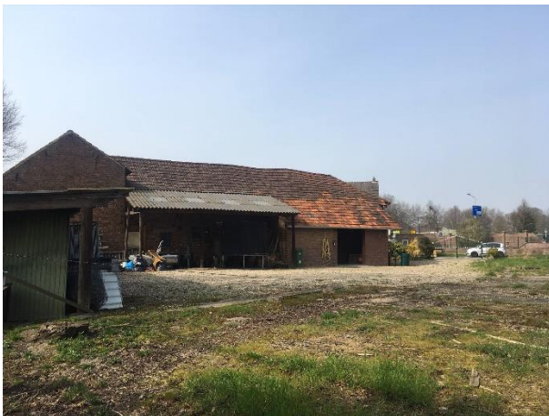
Foto 1 Gerestaureerde overkappingen met golfplaat dakbedekking
