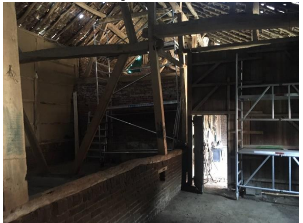
Foto 6 Schoor alwaar de restauratie werkzaamheden plaatsvonden
