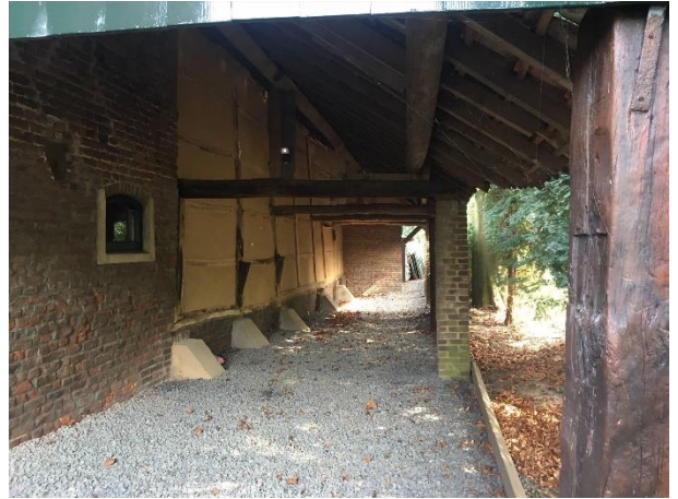
Foto 10 Afdak aan de schuur
