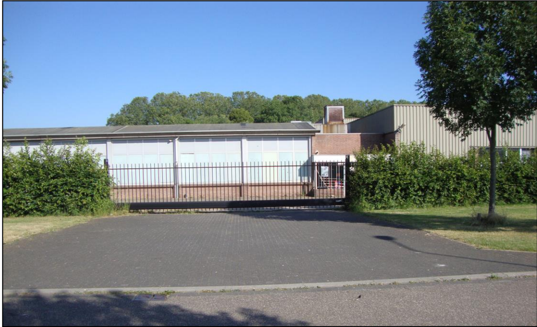
Perceel/pand met maatschappelijke bestemming, aan de Borrekuilstraat 50
