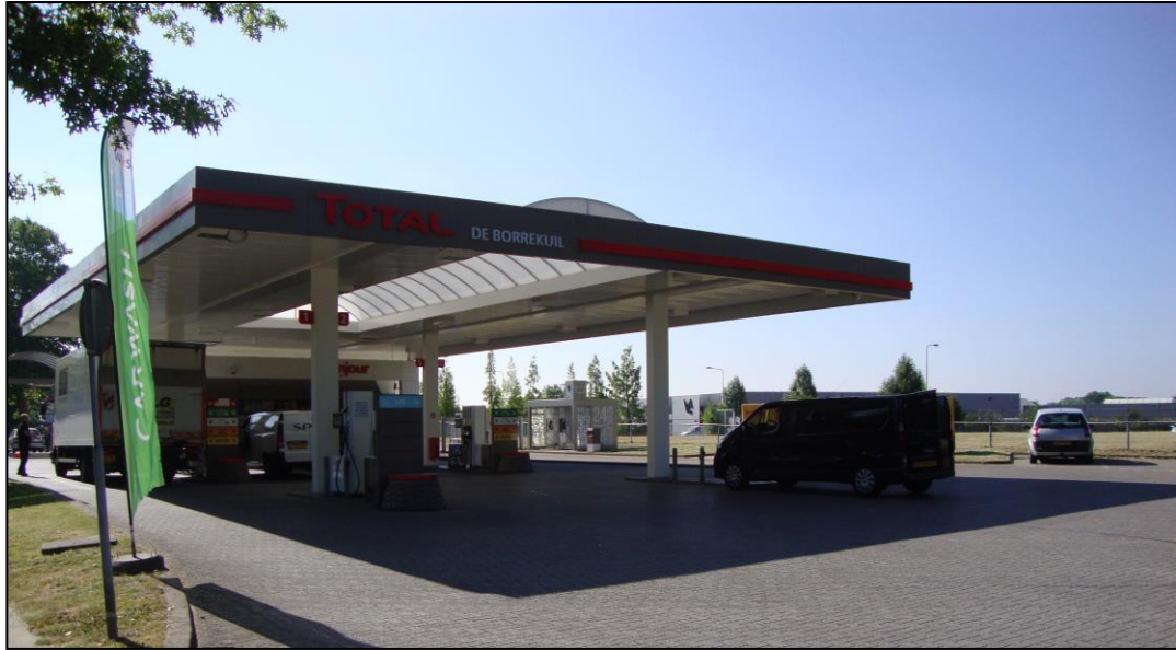
Het tankstation aan de noordrand van het plangebied, aan de Elsenburglaan 2
