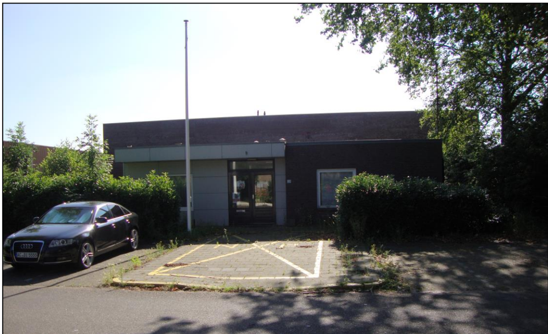
Perceel/pand met maatschappelijke bestemming, aan de Borrekuilstraat 124
