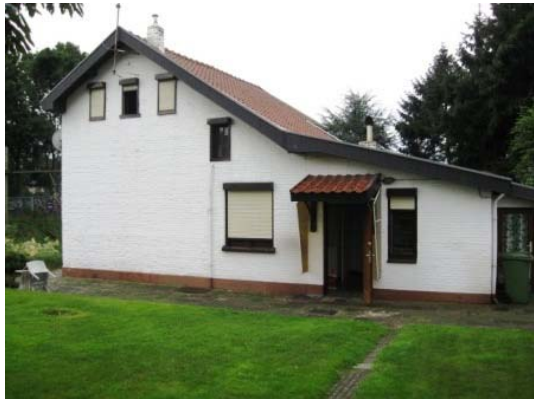
Figuur 3: Het huis gezien vanuit noordelijke richting.
