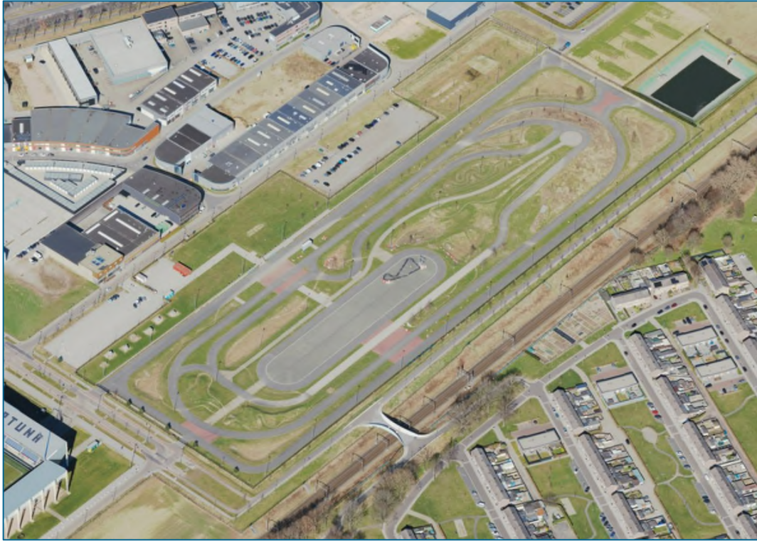
Figuur 4.3: Huidige situatie van het Bike Park. LuchtfotoNL 2021 © CycloMedia Technology B.V. (de luchtfoto is vanuit het zuiden genomen).
