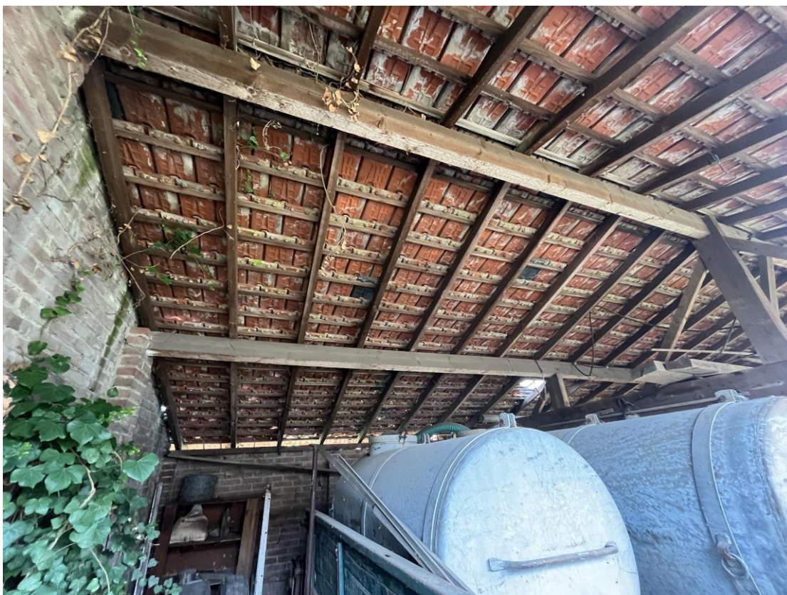
Foto 5: Dakconstructie "opslag" stal
