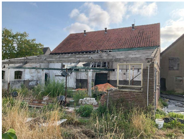
Foto 2 Bebouwing alwaar het asbestdak is verwijderd
