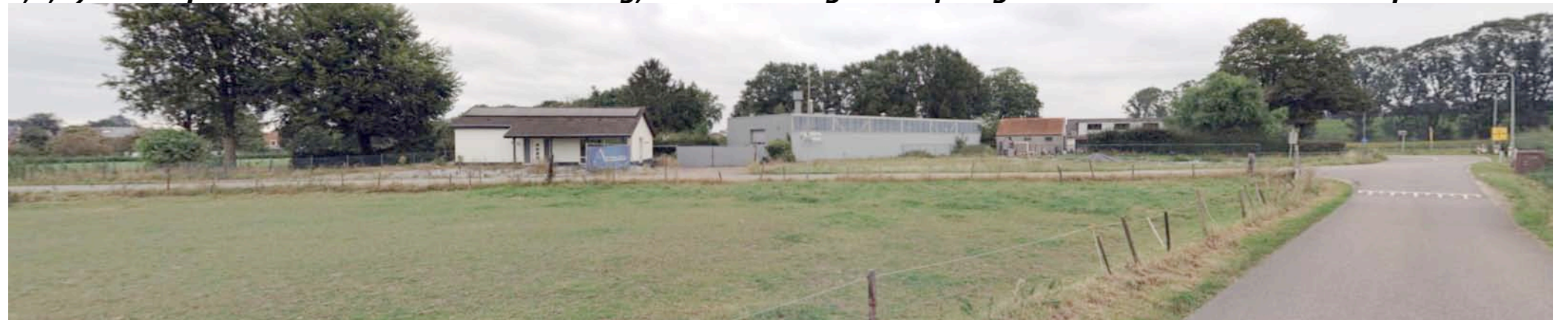
De loods vormt door het samenspel van omvang, dakvorm, maat en schaal in stedenbouwkundige zin een ..
