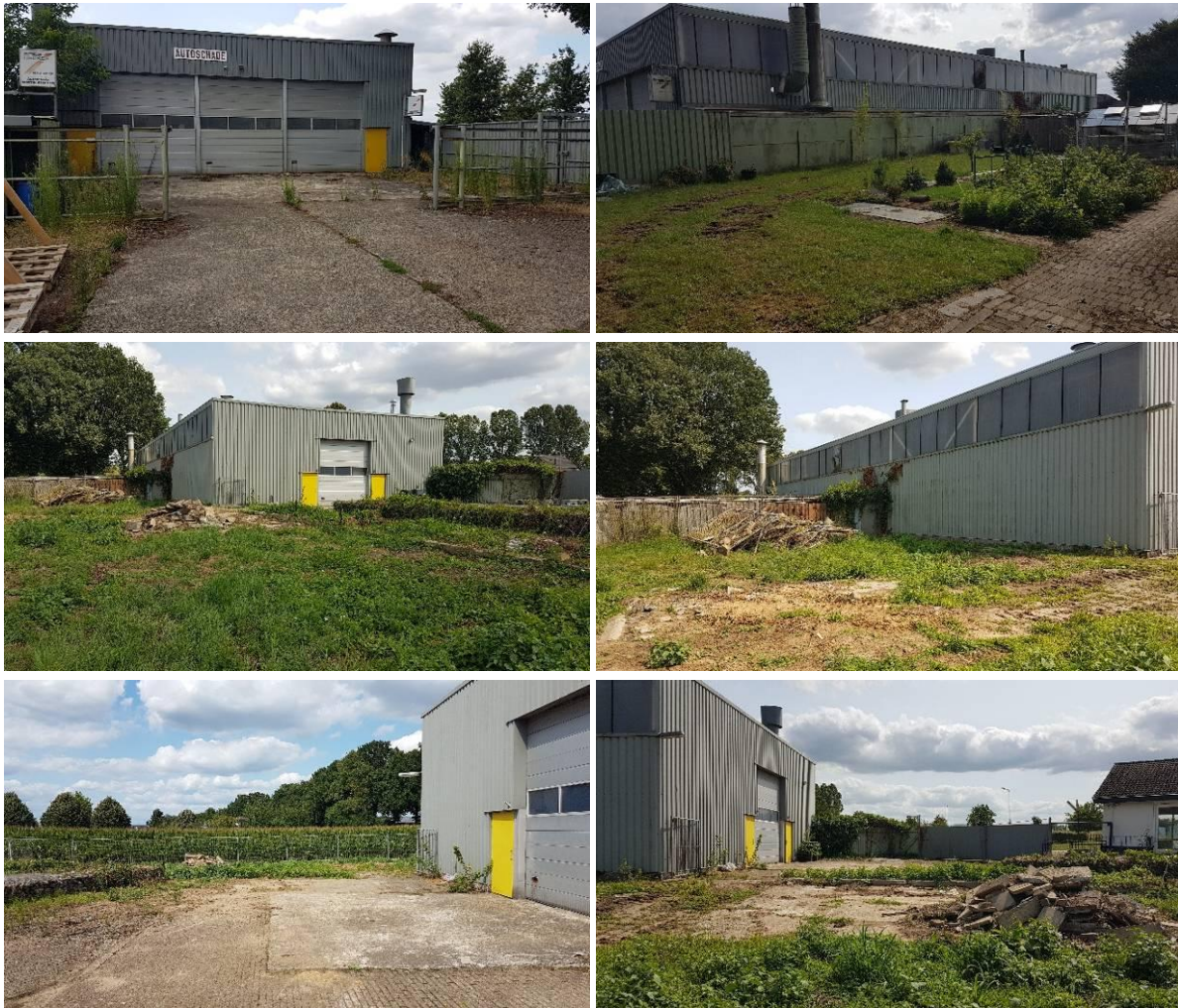
Figuur 3: Foto's van het plangebied en de daarbinnen aanwezige bebouwing. 4
