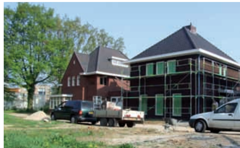
Nieuwbouw in Molenbeek
