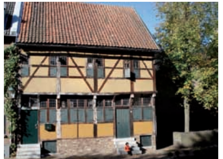
Vakwerk woonhuis in de Gruizenstaat Sittard.
