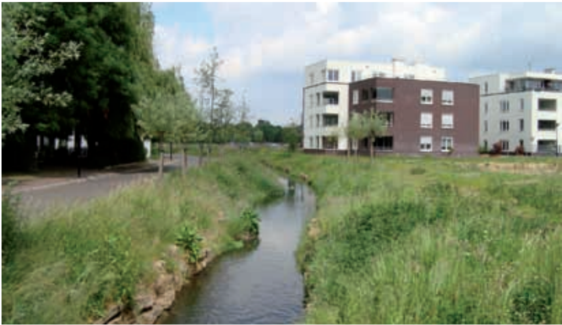
Nieuwbouw in Molenbeek
