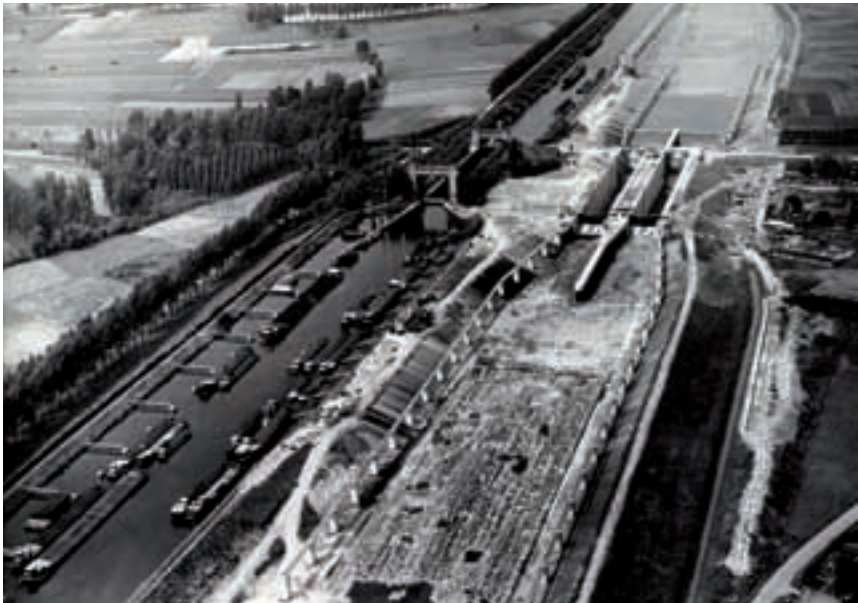
aanleg van de nieuwe (tweede) sluis bij Born begin jaren 60 vorige eeuw. De opening vond plaats op 17 mei 1962.
