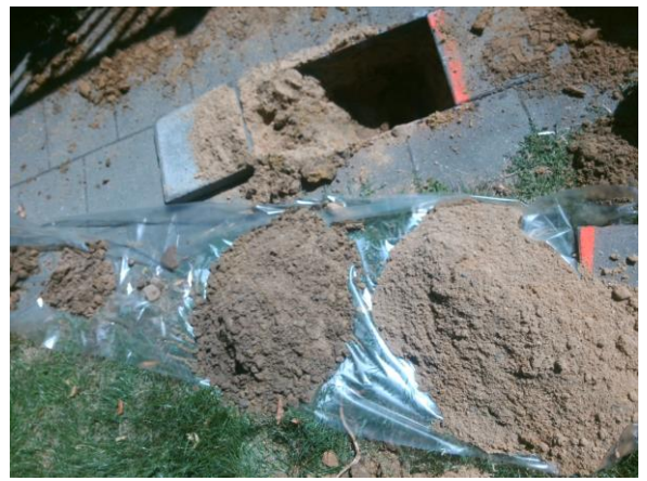
Foto 10. Asbestinspectiegat 2.12
