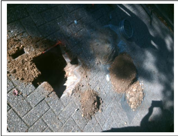
Foto 13. Asbestinspectiegat 1.18
