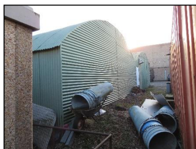
Figuur 7. Opslag materialen achter golfplaten loods.
