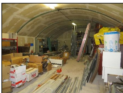
Figuur 6. Binnenzijde golfplaten loods.
