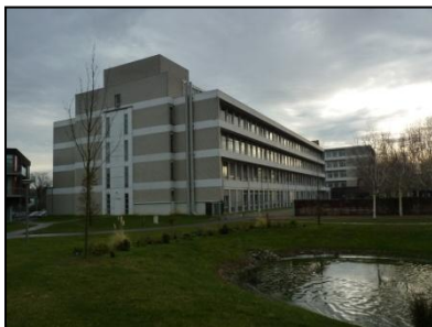
Figuur 3. Gebouw St. Odillia.
