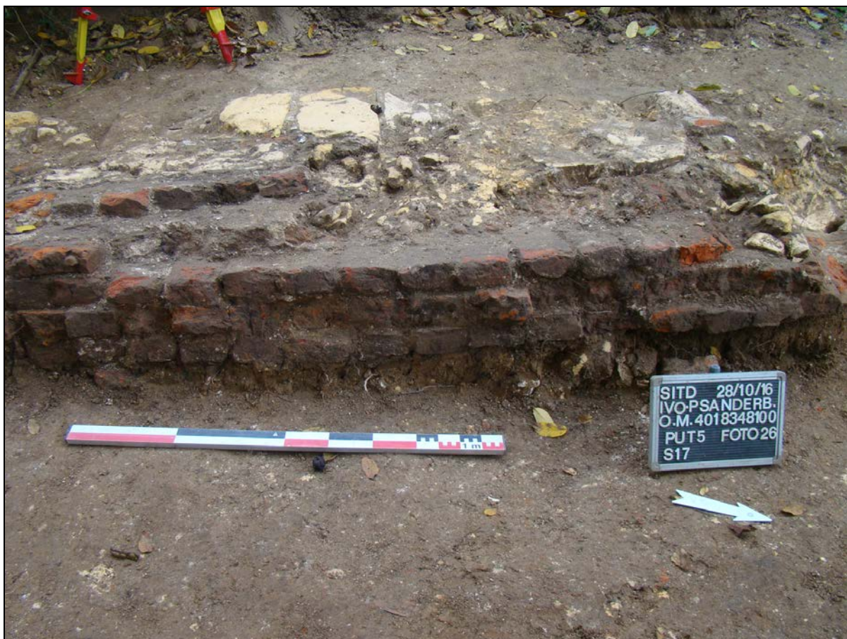
Afbeelding 30. Overzichtsfoto van de fundering, Spoor nr. 17, Proefsleuf nr. 5, waarop de bakstenen bekleding zichtbaar is. De foto (Foto nr. 26) is genomen vanuit oostelijke richting.
