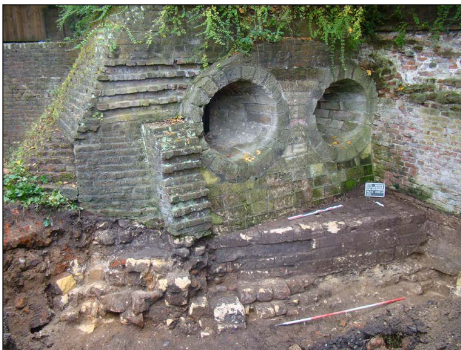
Afbeelding 30. Overzichtsfoto van de fundering (Spoor nr. 18), in Proefsleuf nr. 3, beneden het gereconstrueerde muurwerk met schietgaten van Fort Sanderbout. De foto (Foto nr. 27) is genomen vanuit noordoostelijke richting.
