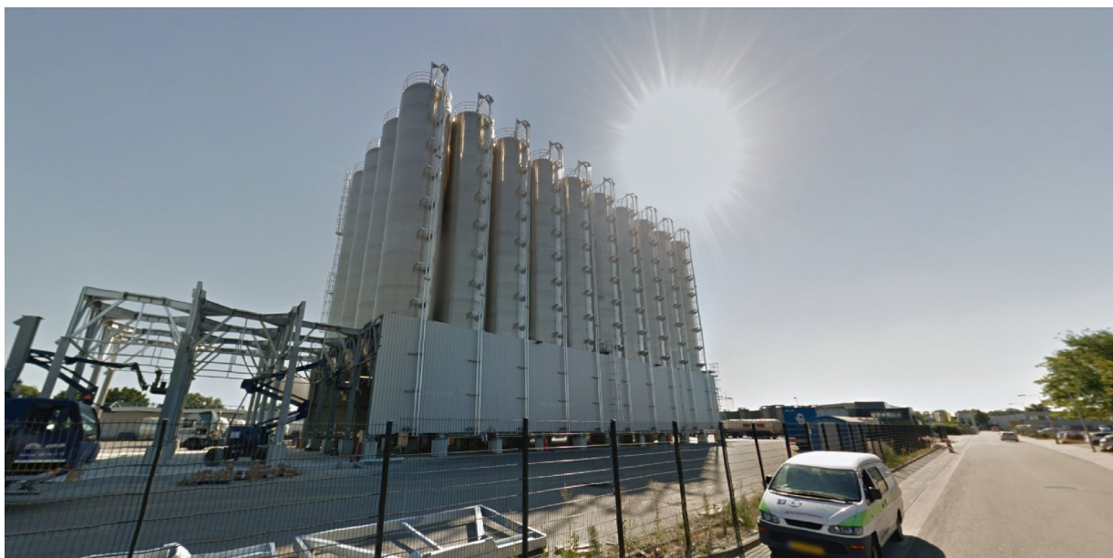
fig. 3 Aanzicht bestaande silo's Dalderhaag
