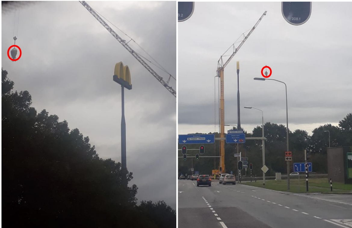
Afbeeldingen: onderlangs bij Rijksweg Zuid (links) en zicht vanuit zijde Neerbeek (rechts)
