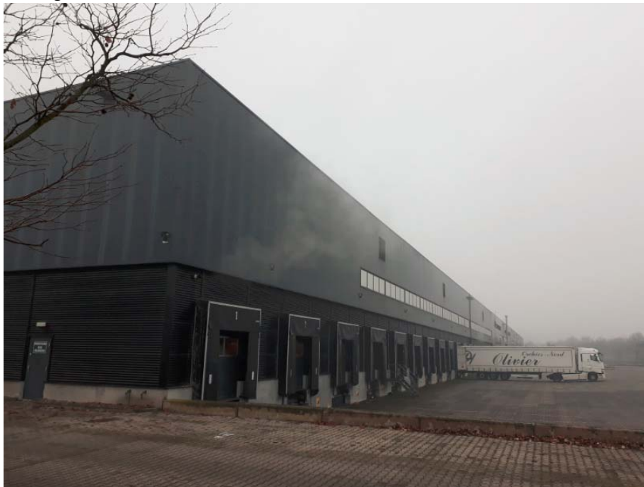
Detail van de bestaande hallen met docks.
