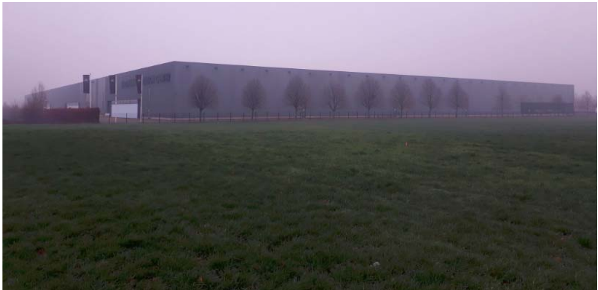
De bestaande hallen ten noordwesten van het plangebied, kijkende vanuit het plangebied in noordwestelijke richting.
