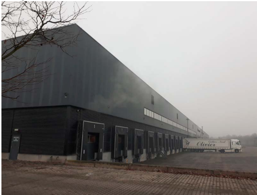
Detail van de bestaande hallen met docks.
