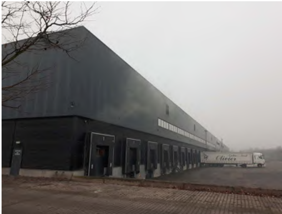
Detail van de bestaande hallen met docks.
