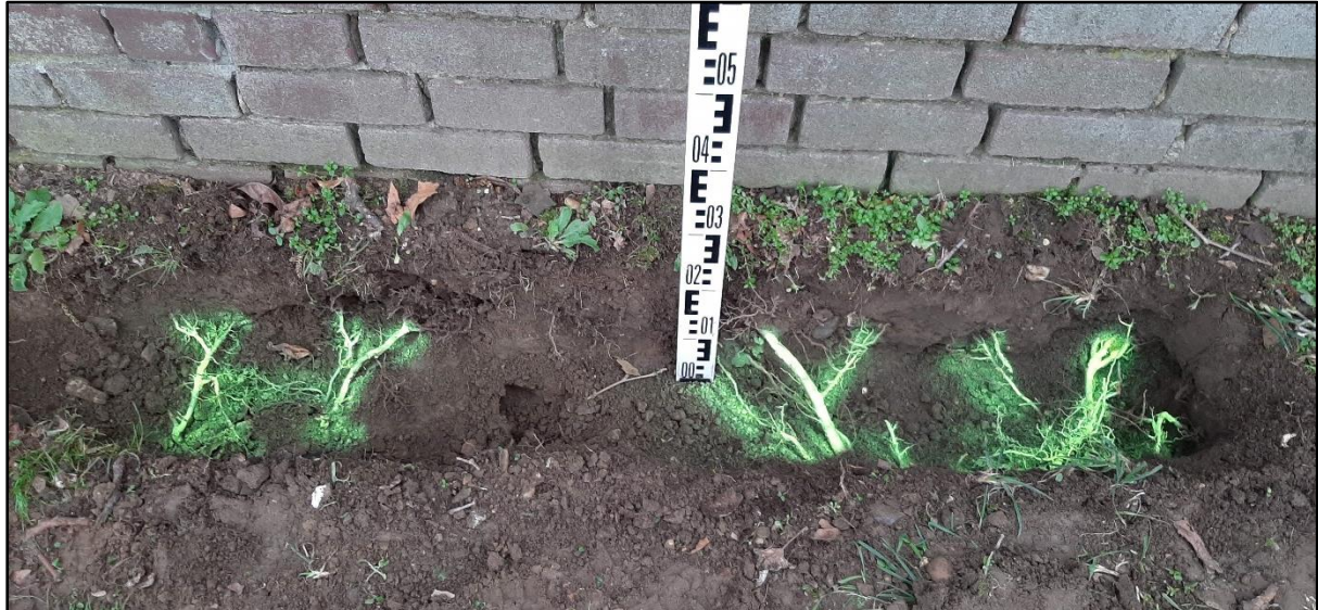
Figuur 15. Proefsleuf 2. Aangetroffen beworteling tot 25 centimeter -maaiveld.
