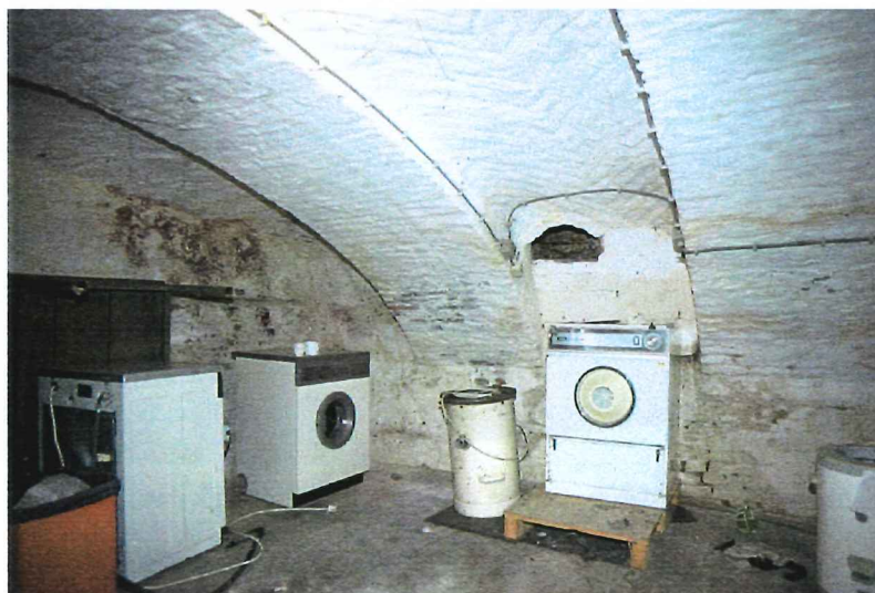
Afbeelding 81 Noordelijke kelder: kelderlicht (A) in troggewelf (B) aan noordzijde
