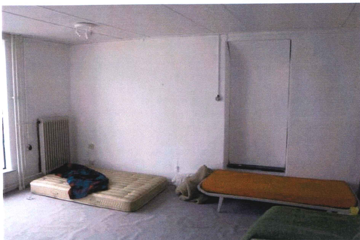
Afbeelding 117 Verdieping: dichtgezette doorgang naar Putstraat 22
