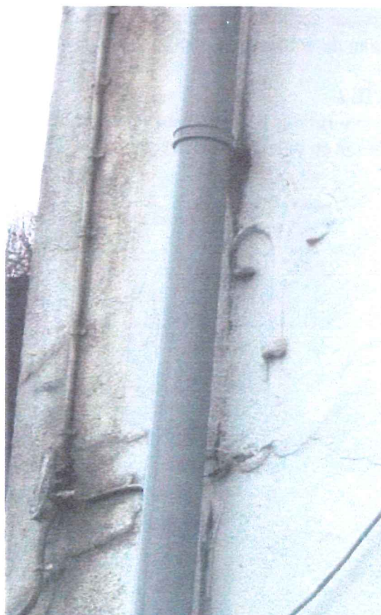
Afbeelding 98 Achtergevel: muuranker
