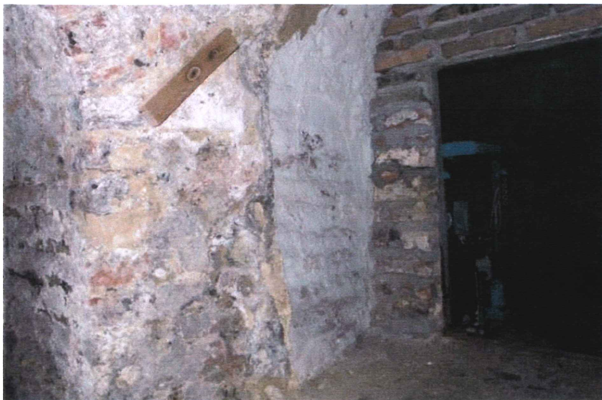
Afbeelding 20 Kelder: doorgang naar kelder Putstraat 16
