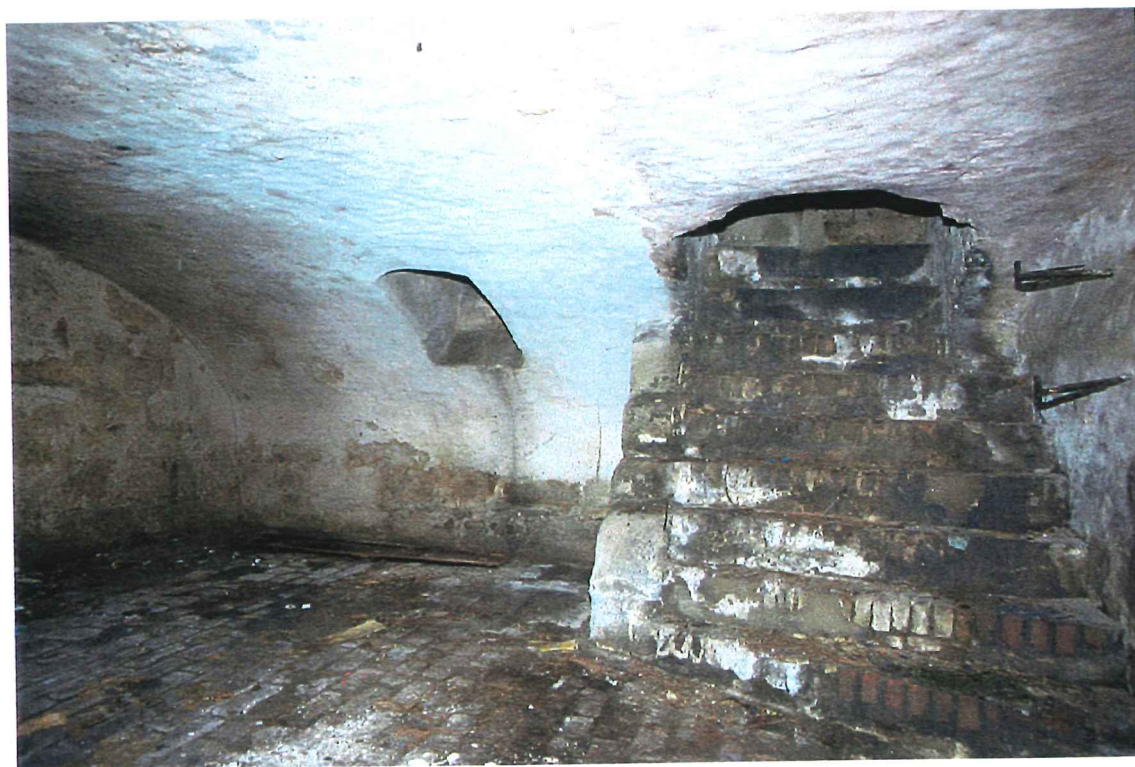
Afbeelding 111 Kelder onder winkel: trap van metselwerk en hardstenen blokken; links een stortkoker
