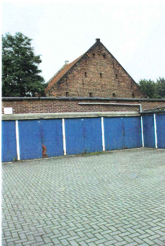
Afbeelding 152 Achtergevel Moutschuur met op de voorgrond de garageboxen aan de binnenplaats Pullestraat
