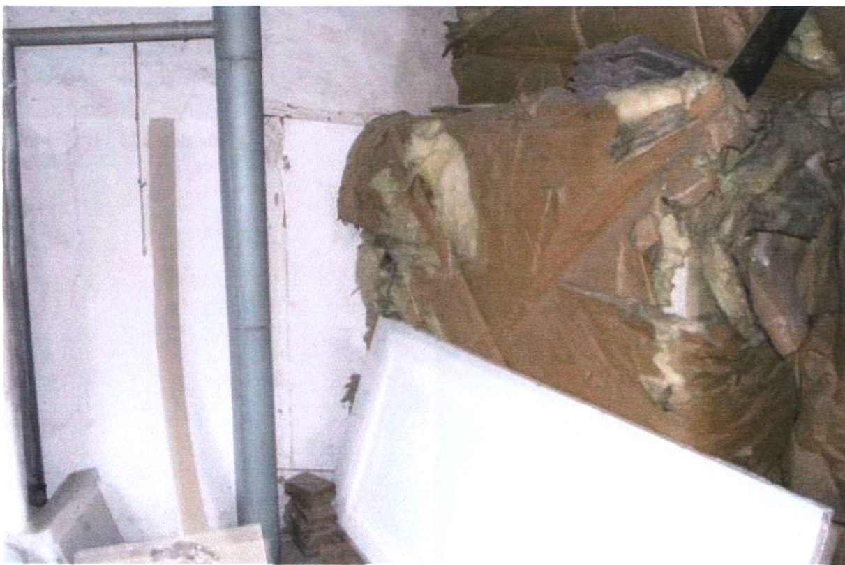
Afbeelding 25 Zolder: bouwspoor van dichtgezette doorgang naar Putstraat 16
