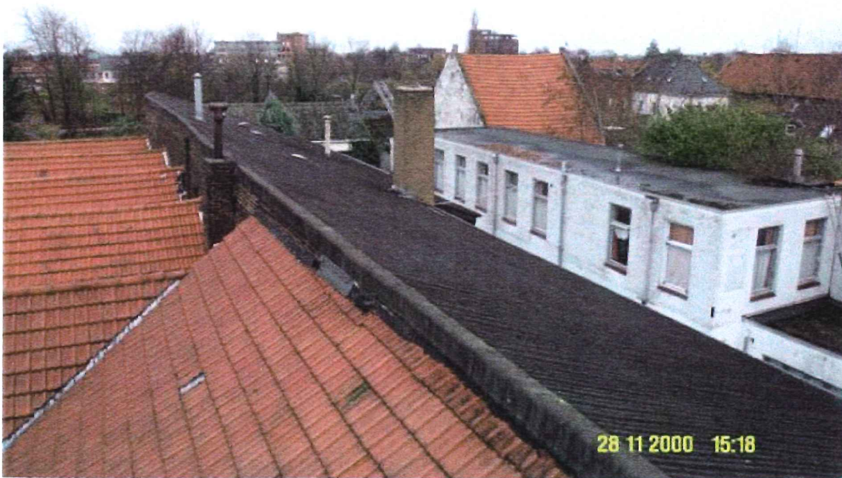
Afbeelding 146 SOHO hotel, vanaf het dak van het langgerekt pand
