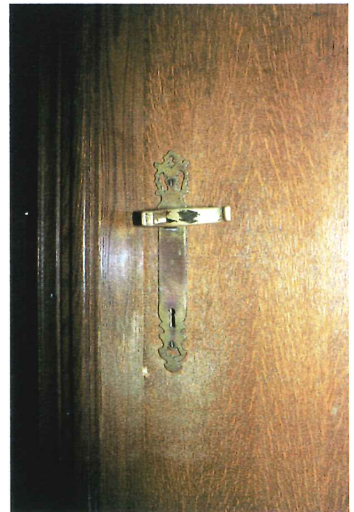
Afbeelding 42 Begane grond nr. 18: deur met origineel sluitwerk
