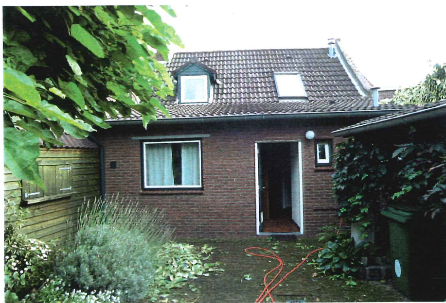
Afbeelding 172 Achtergevel: in het dak zijn een dakraam en houten dakkapel opgenomen
