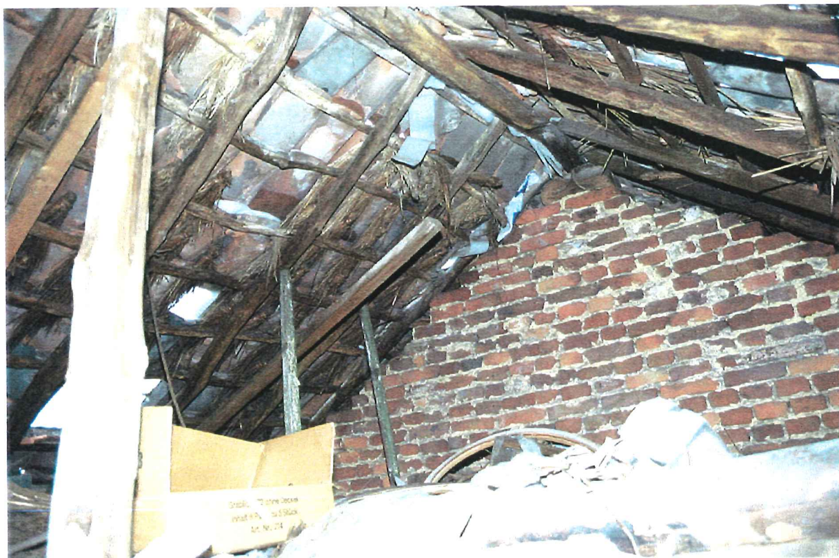
Afbeelding 192 19 e -Eeuwse kapconstructie boven het westelijk deel van het pand
