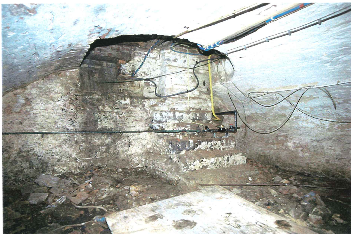
Afbeelding 99 Zuidelijke kelder: oorspronkelijke (dichtgezette) doorgang en trap aan straatzijde
