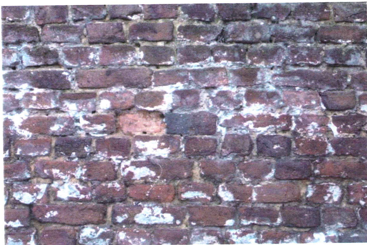
Afbeelding 168 Detail metselwerk opgangen
