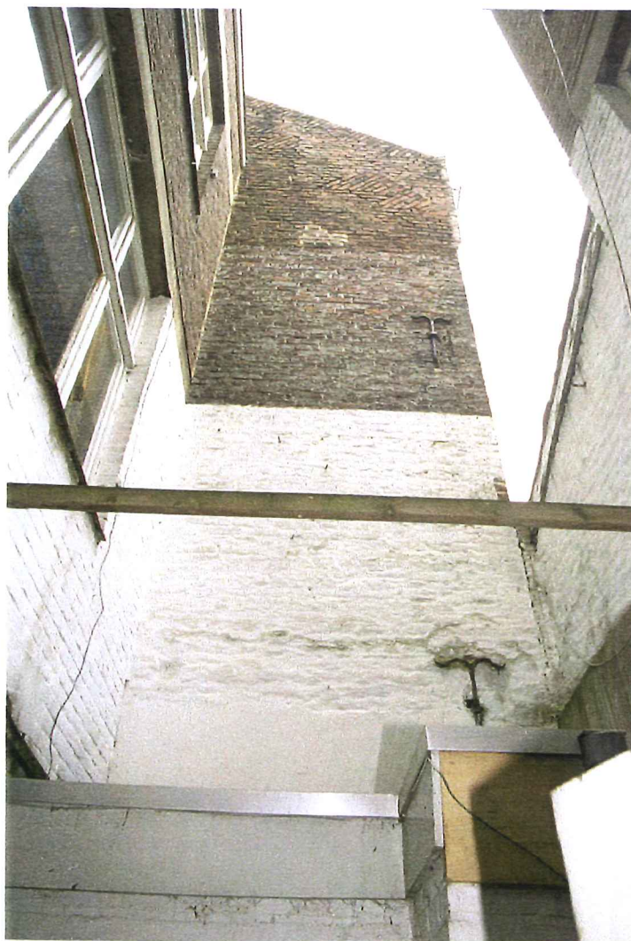
Afbeelding 34 Verhoogde zijgevel met zichtbare vlechtingen (A)
