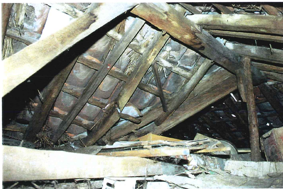
Afbeelding 190 Onbeschoten sporenkap boven het oostelijk deel van het pand: een deel van de sporen is in eiken uitgevoerd en zal nog uit de bouwtijd stammen; het dak is afgedekt met Oudhollandse pannen waartussen strodokken zijn aangebracht
