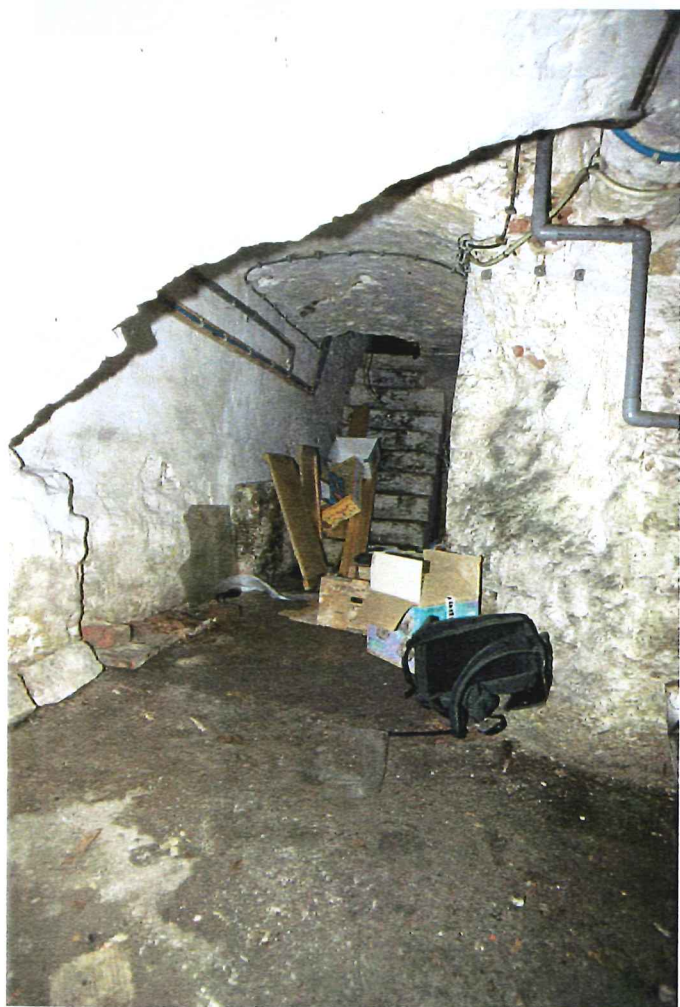
Afbeelding 102 Zuidelijke kelder: doorgang naar noordelijke kelder
