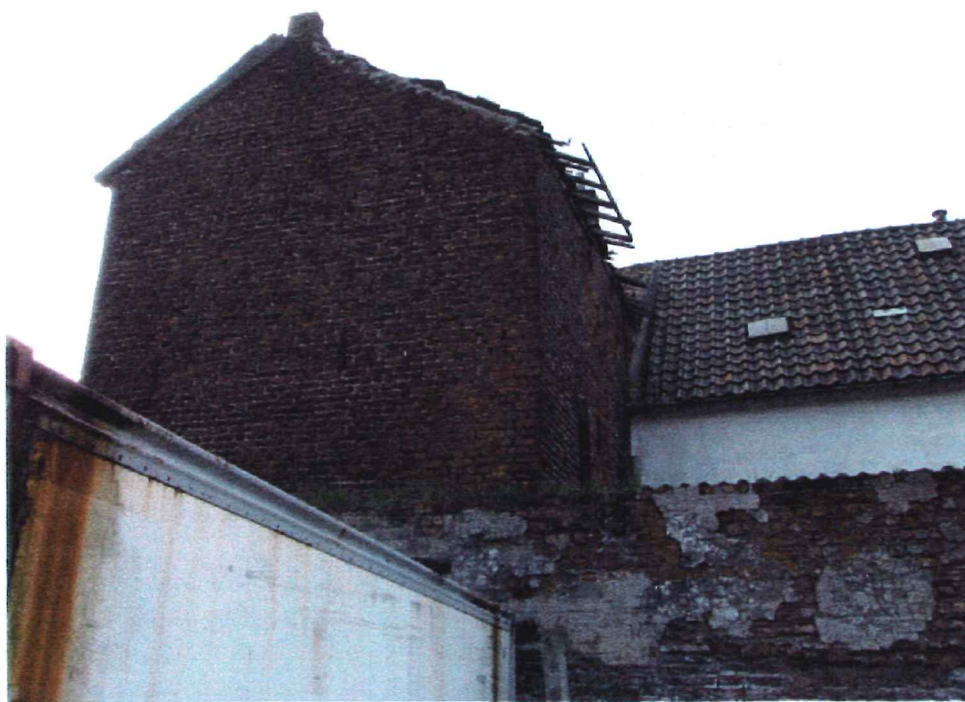
Afbeelding 182 Westelijke zijgevel met restant van oude (tuin)muur
