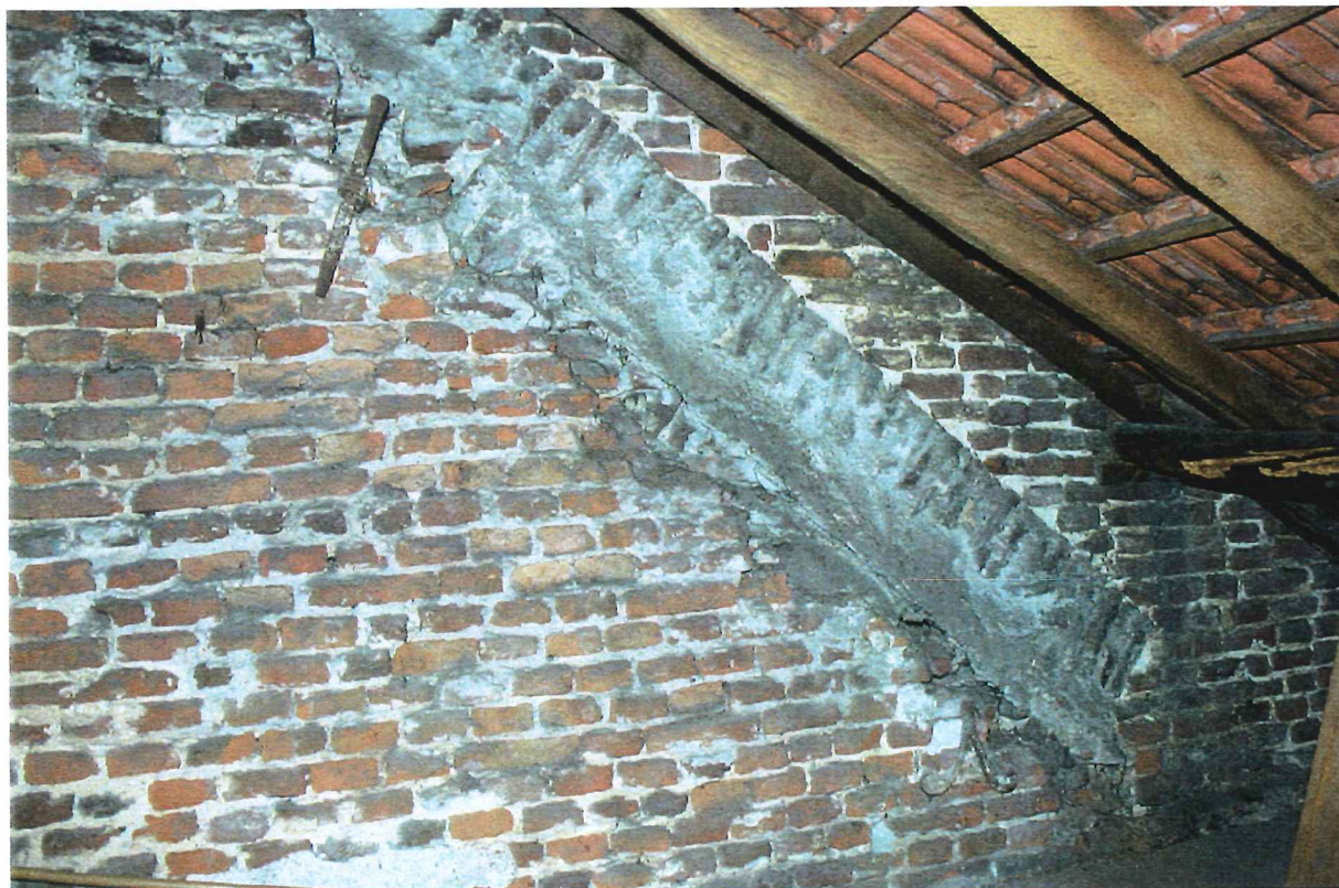
Afbeelding 89 Zolder: vlechtingen (A) en mortelresten uit de aansmering (B) van de in 1677 tot stand gekomen (voormalige) kap van het buurpand Putstraat 20, die vermoedelijk met leien gedekt is geweest
