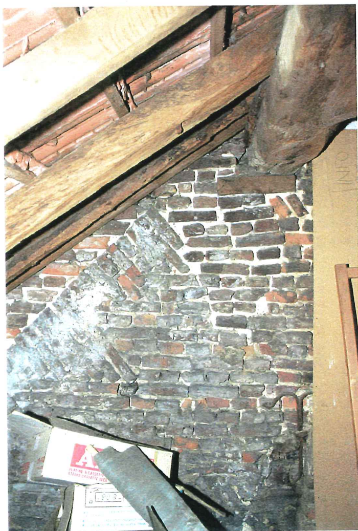
Afbeelding 91 Zolder: eiken fliering en sporen; bouwsporen van ophoging van het dak
