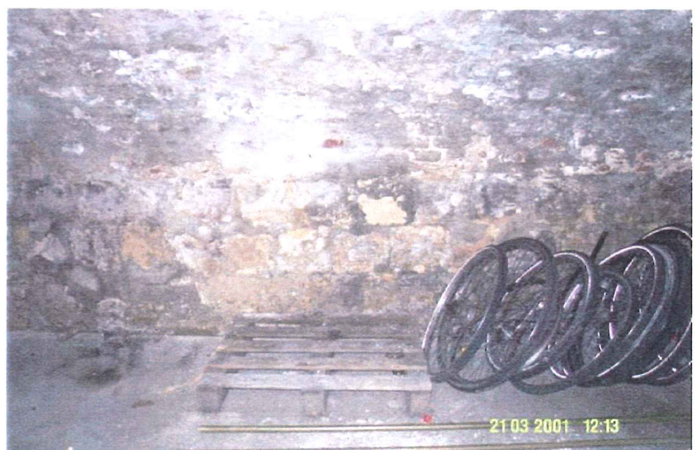
Afbeelding 155 Kelder: mergelaanzet
