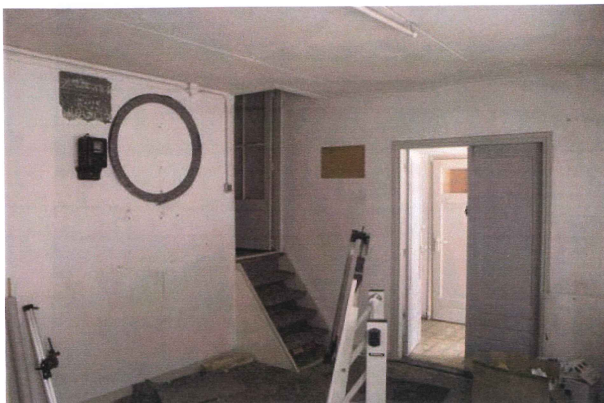
Afbeelding 116 Begane grond: voormalig kantoor van de firma BAT; houten trap naar verdieping
