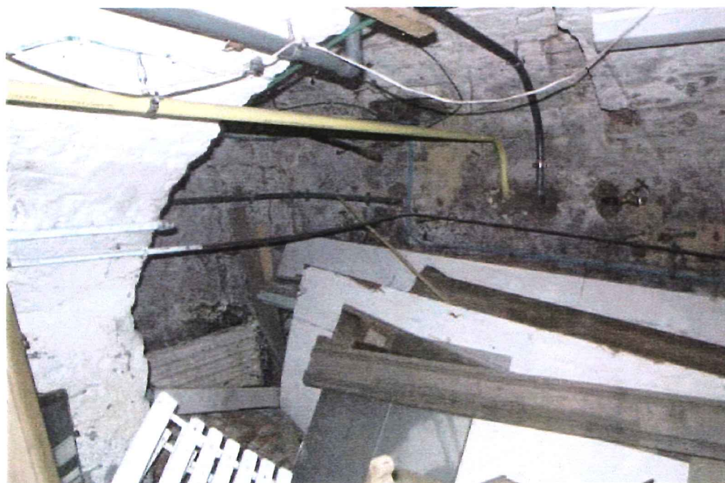
Afbeelding 60 Kelder: dichtgezette opening naar Putstraat 22
