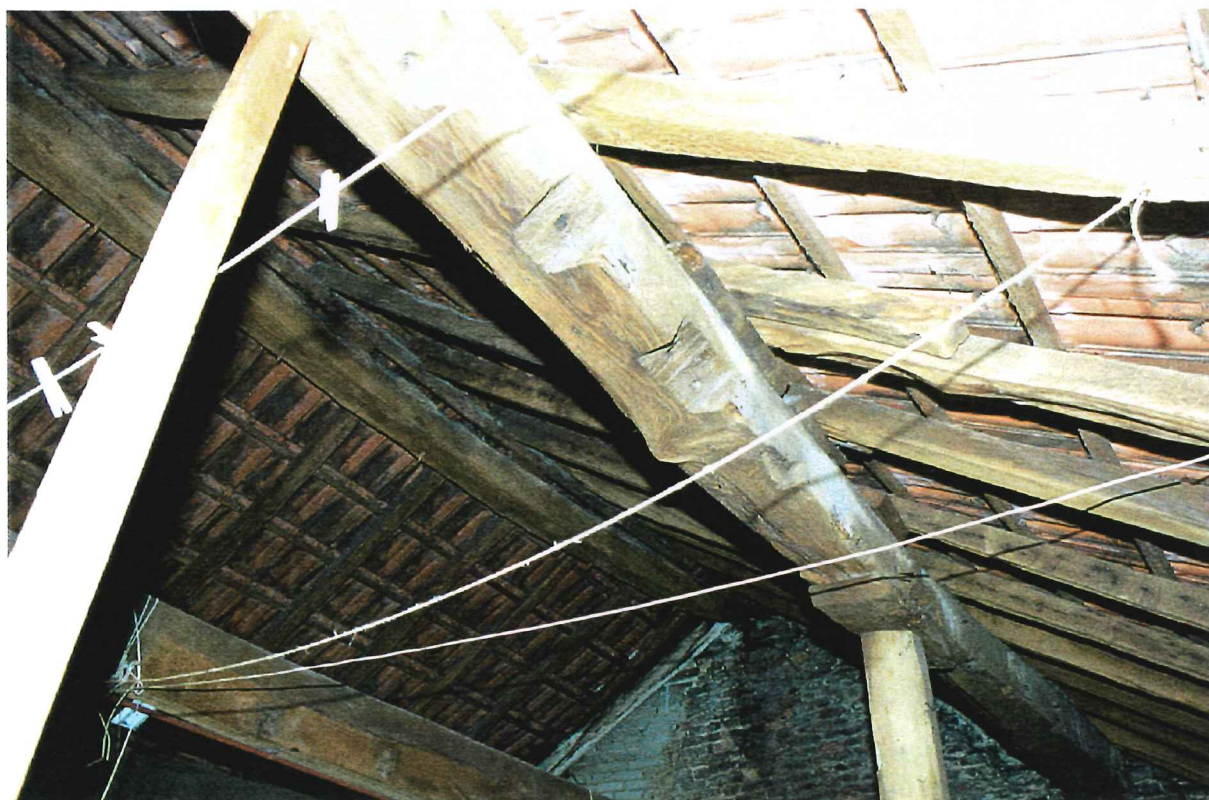
Afbeelding 92 Zolder: hergebruikte (gekantelde) fliering (A) en grenen stutconstructie (B)
