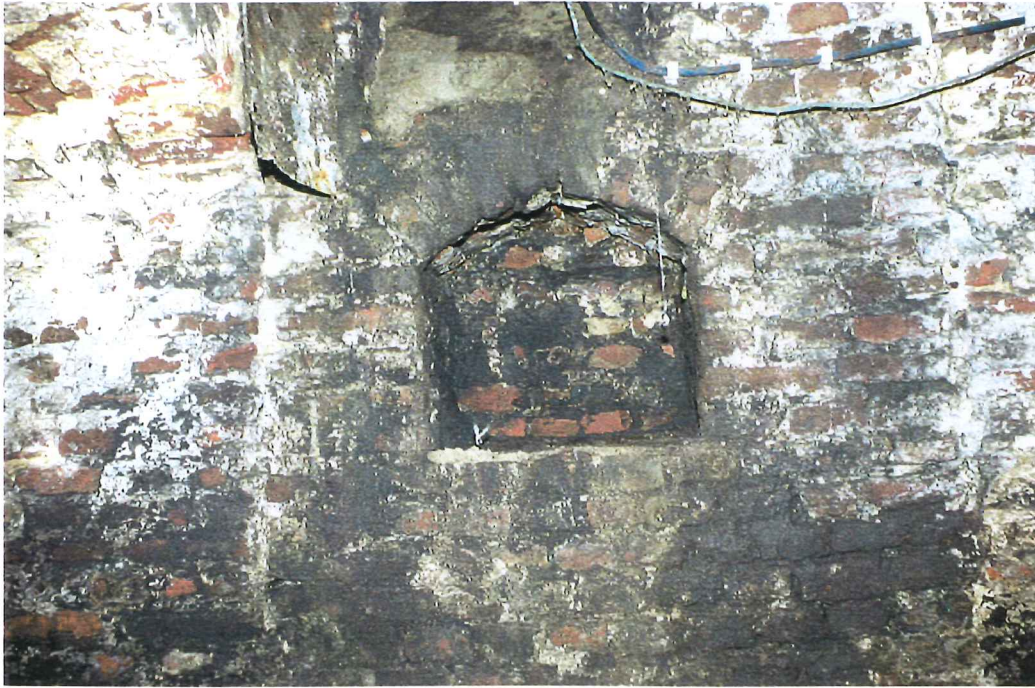
Afbeelding 15 Kelder: nis in dichtgezette doorgang aan straatzijde
