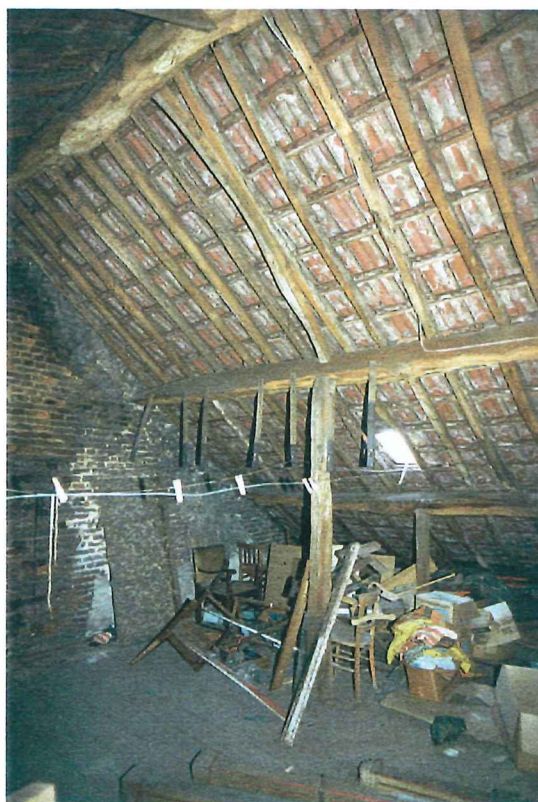
Afbeelding 51 Zolder nr. 18: flieringen (B) met stutten (A)
