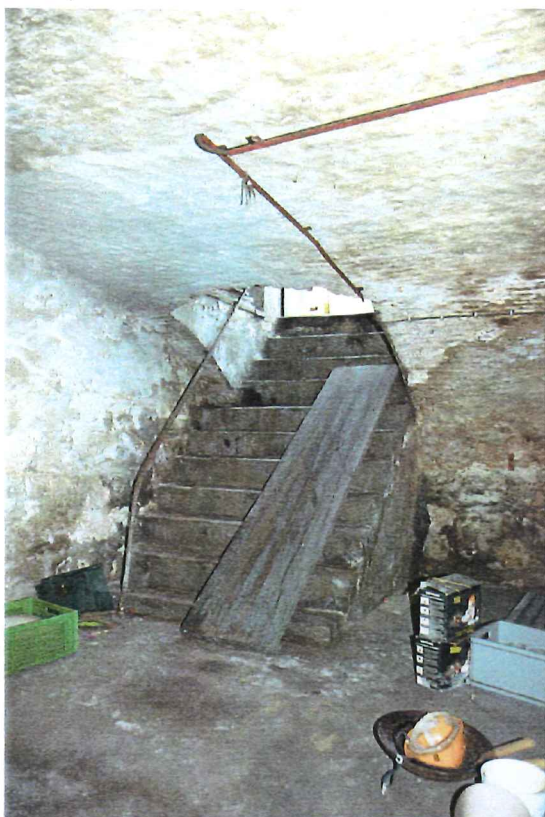
Afbeelding 156 Kelder: toegangstrap met hardstenen treden
