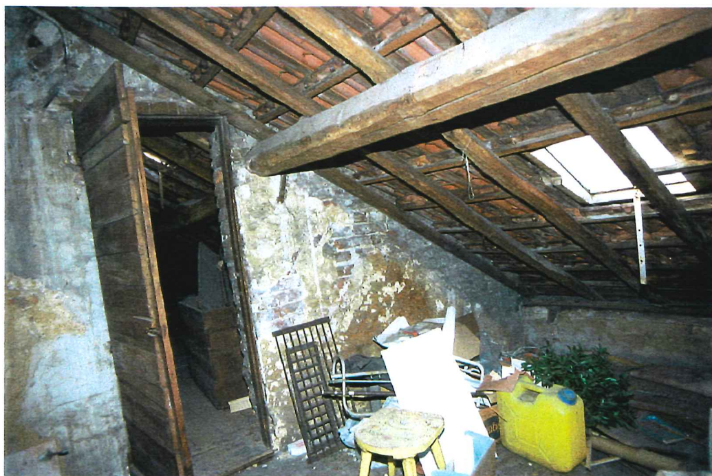
Afbeelding 47 Zolder nr. 16: ophoging in bouwmuur naar Putstraat 18
