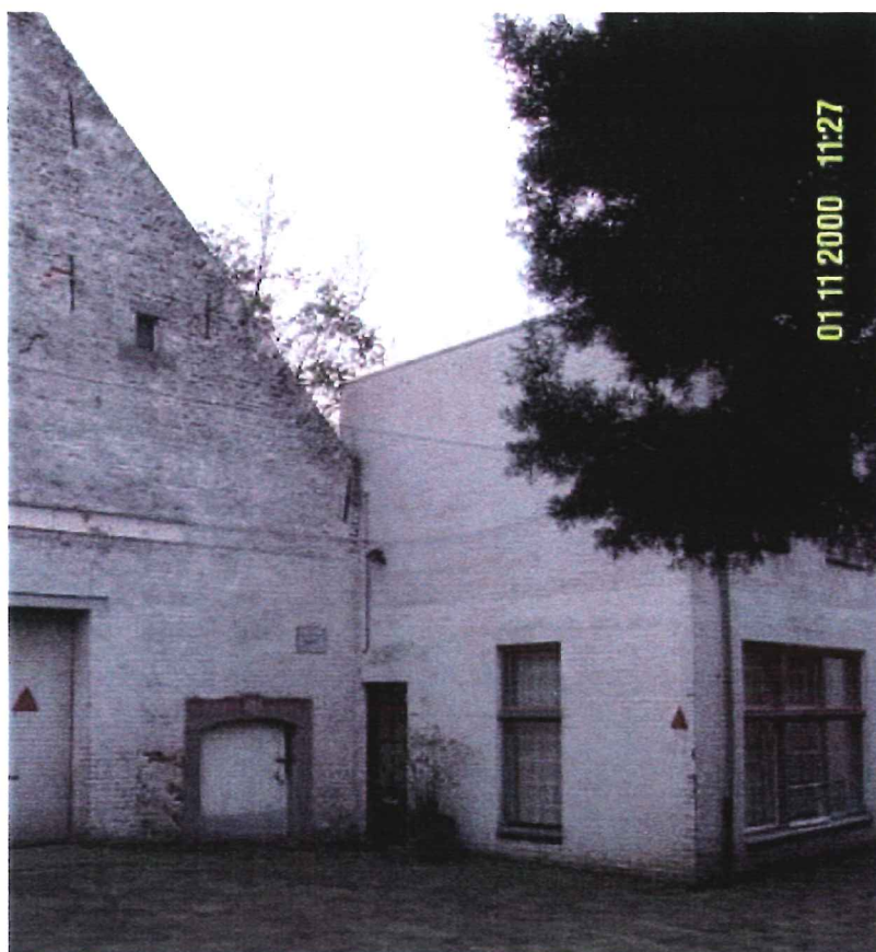
Afbeelding 150 Voorgevel met toegang tot kelder
