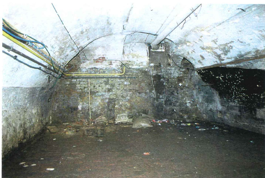
Afbeelding 38 Kelder nr. 18: gemetselde boog (A) onder toegang pand
