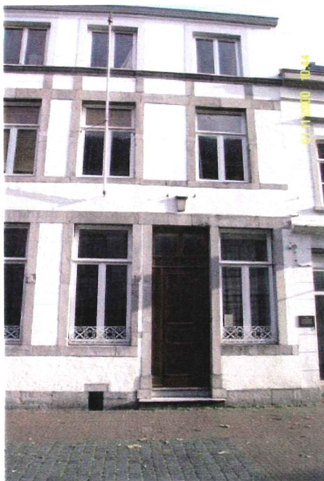
Afbeelding 69 Gevel met verplaatste deur
