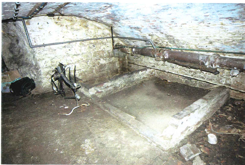
Afbeelding 101 Zuidelijke kelder: gemetselde bakken
