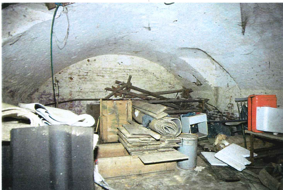
Afbeelding 78 Zuidelijke kelder: mogelijk oorspronkelijk kelderlicht (A) aan noordzijde
