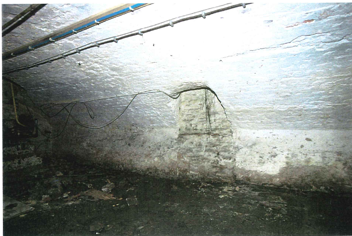
Afbeelding 100 Zuidelijke kelder: dichtgezette doorgang naar Putstraat 22
