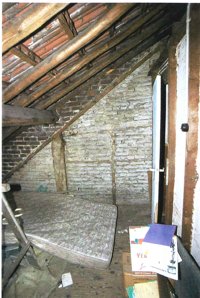
Afbeelding 46 Zolder nr. 16: houten vakwerk (A) in bouwmuur naar Putstraat 14 en ophoging (B)
