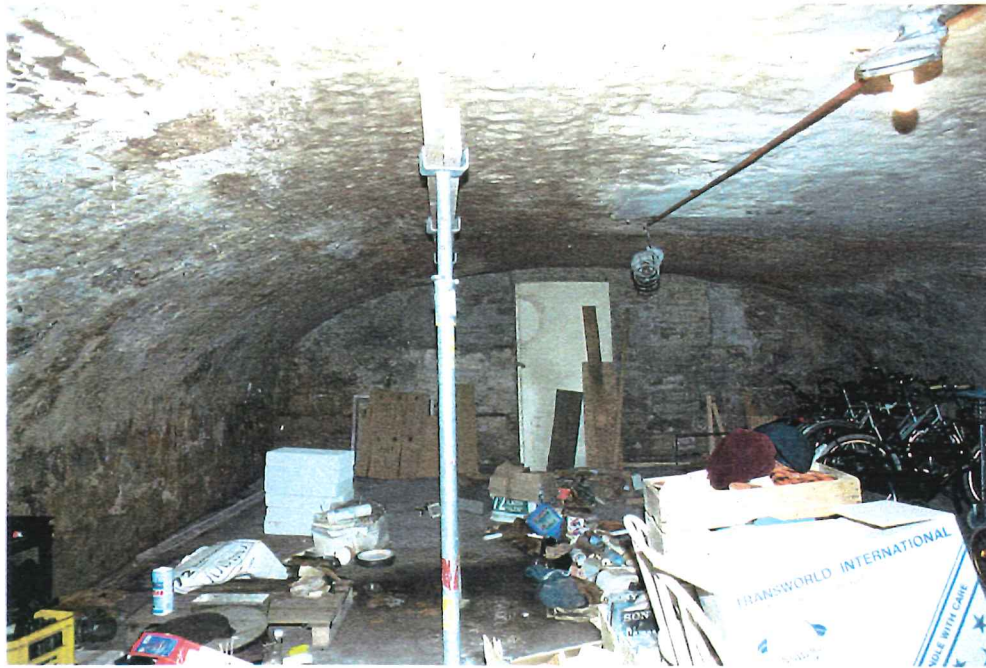
Afbeelding 154 Kelder: dichtgezette vensters in de noordwand (A en B)
