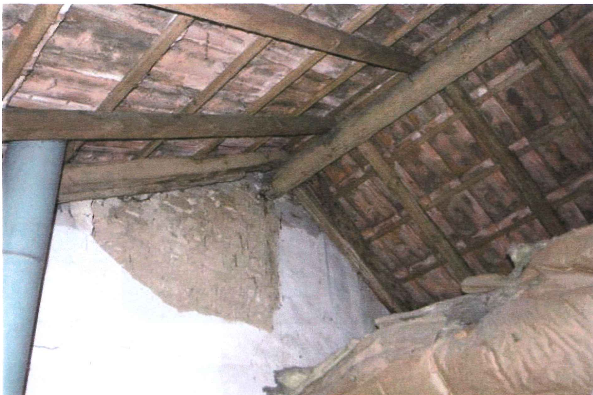
Afbeelding 24 Zolder: origineel stucwerk van leem en stro in bouwmuur
