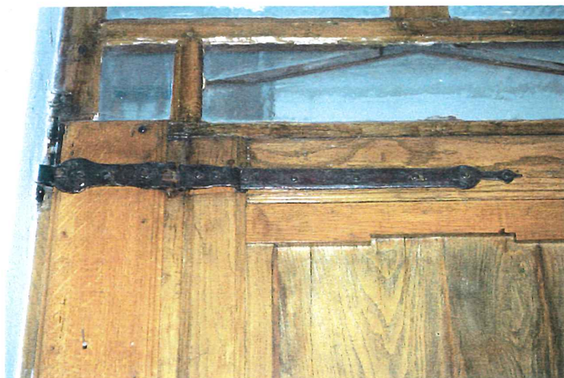
Afbeelding 85 Begane grond: voordeur met origineel hangwerk
