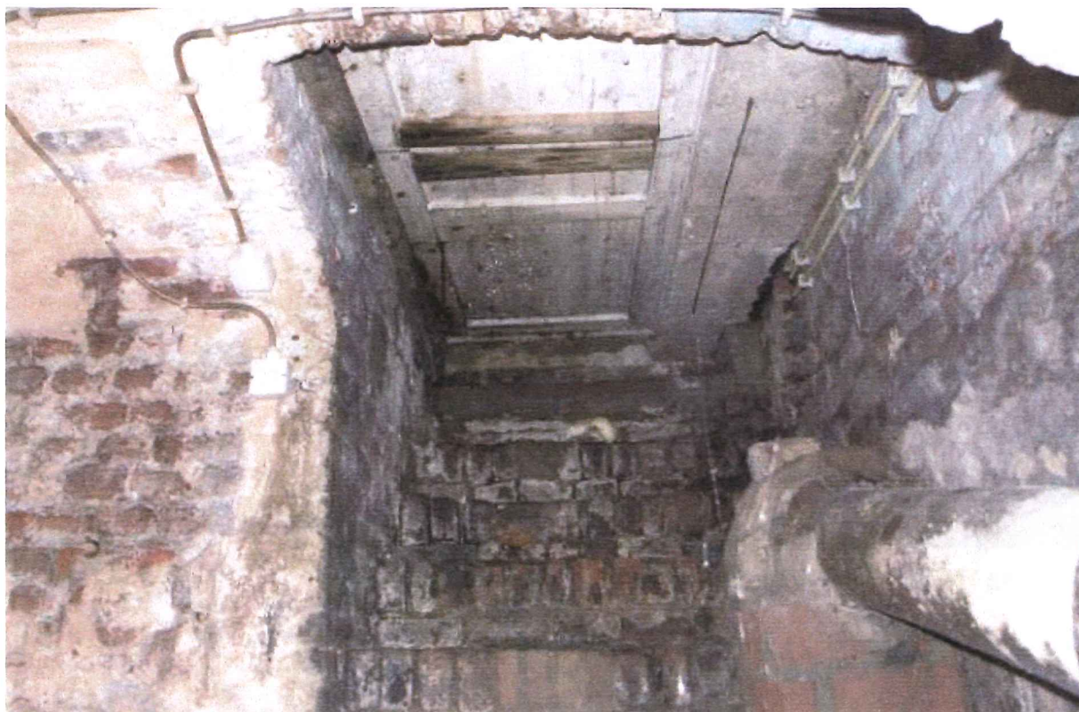
Afbeelding 19 Kelder: houten toegangsluik
