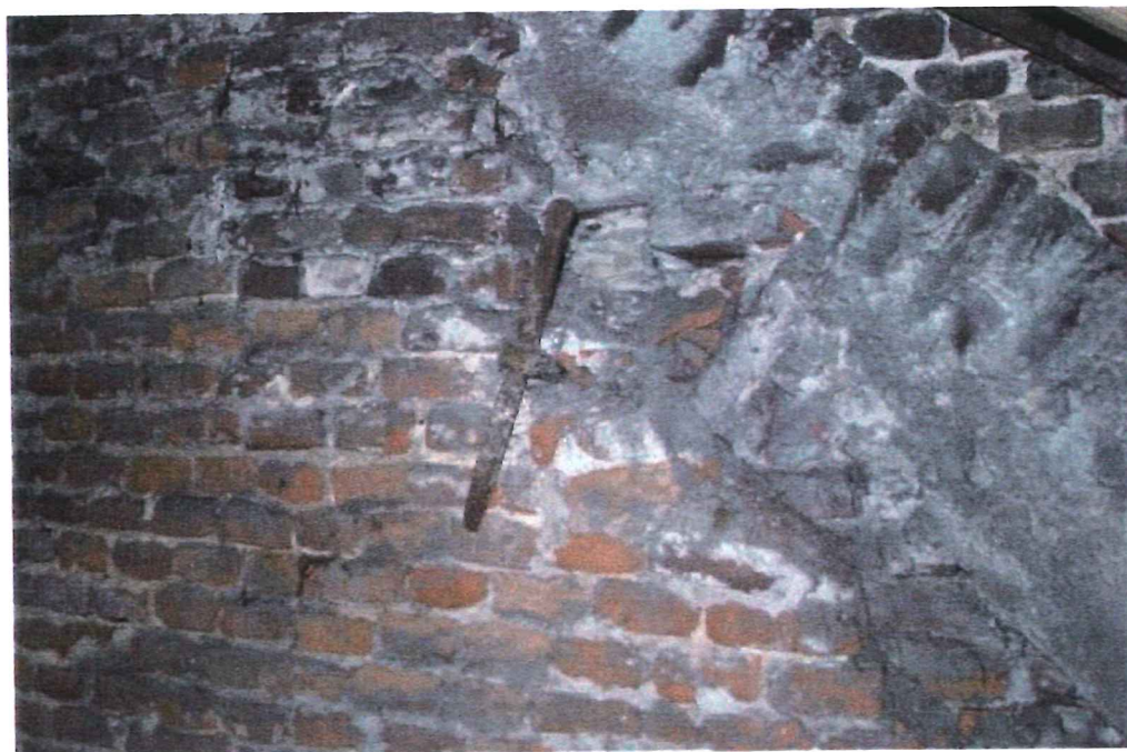
Afbeelding 90 Zolder: sporen van een ophoging van de kapconstructie
