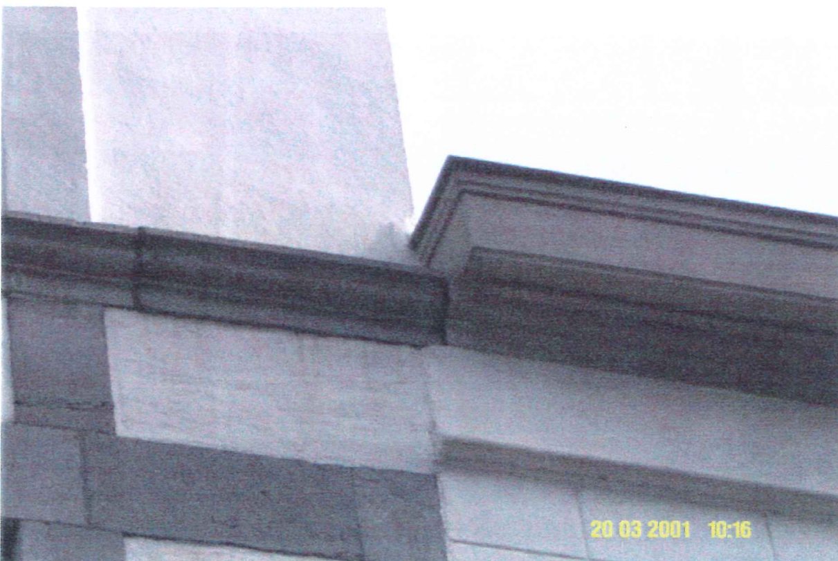
Afbeelding 74 Detail voorgevel: hardstenen gootlijst
