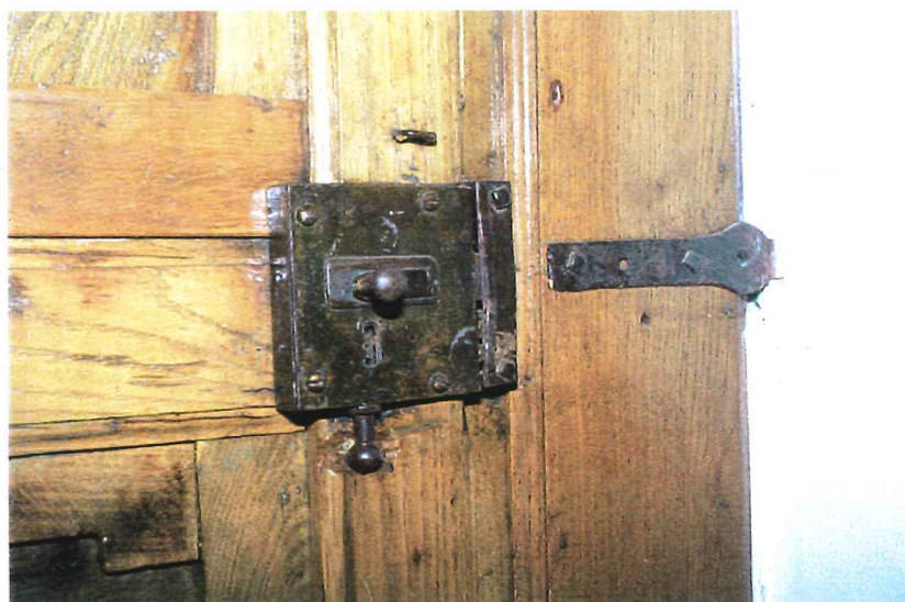
Afbeelding 84 Begane grond: voordeur met origineel sluitwerk
