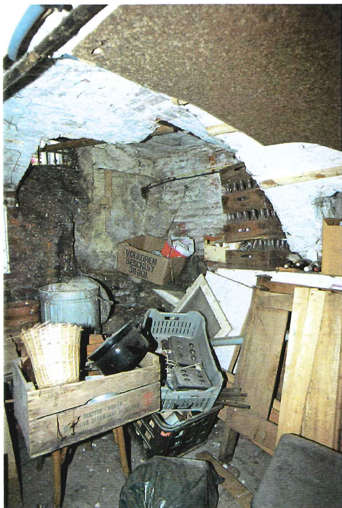
Afbeelding 59 Kelder: dichtgezette opening (A) naar Putstraat 18 en restanten van gemetselde trap (B) en sparing in het gewelf daarboven (C)
