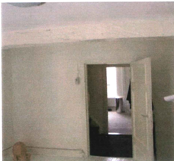
Afbeelding 23 2° Verdieping: houten moerbalk
