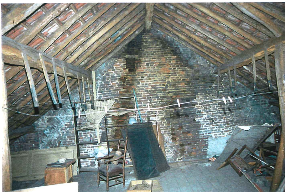
Afbeelding 49 Zolder nr. 18: ophoging (F) in (oostelijke) bouwmuur naar Putstraat 20 met dichtgezette doorgang (G); verschillende baksteenformaten (A t/m E)
