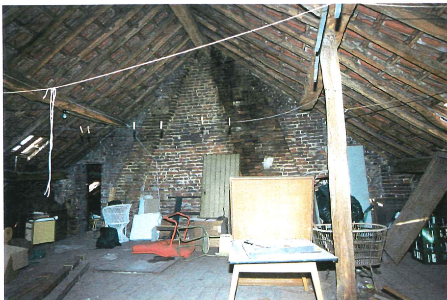
Afbeelding 48 Zolder nr. 18: (westelijke) bouwmuur naar Putstraat 16 met ingehakte doorgang en oorspronkelijke rookkanalen
