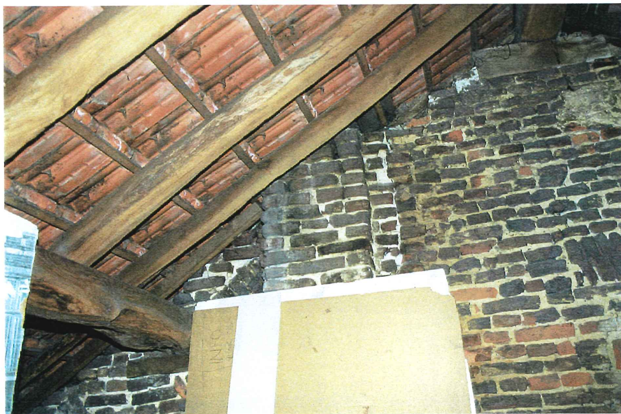
Afbeelding 87 Zolder: oorspronkelijk rookkanaal in zuidwestelijke hoek
