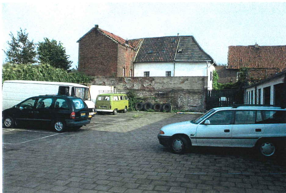
Afbeelding 183 Westelijke zijgevel Fort Sanderbout 6 met muurankers (A) en oude tuinmuur (B); witgeschilderde achtergevels van Pullestraat 6 en 8
