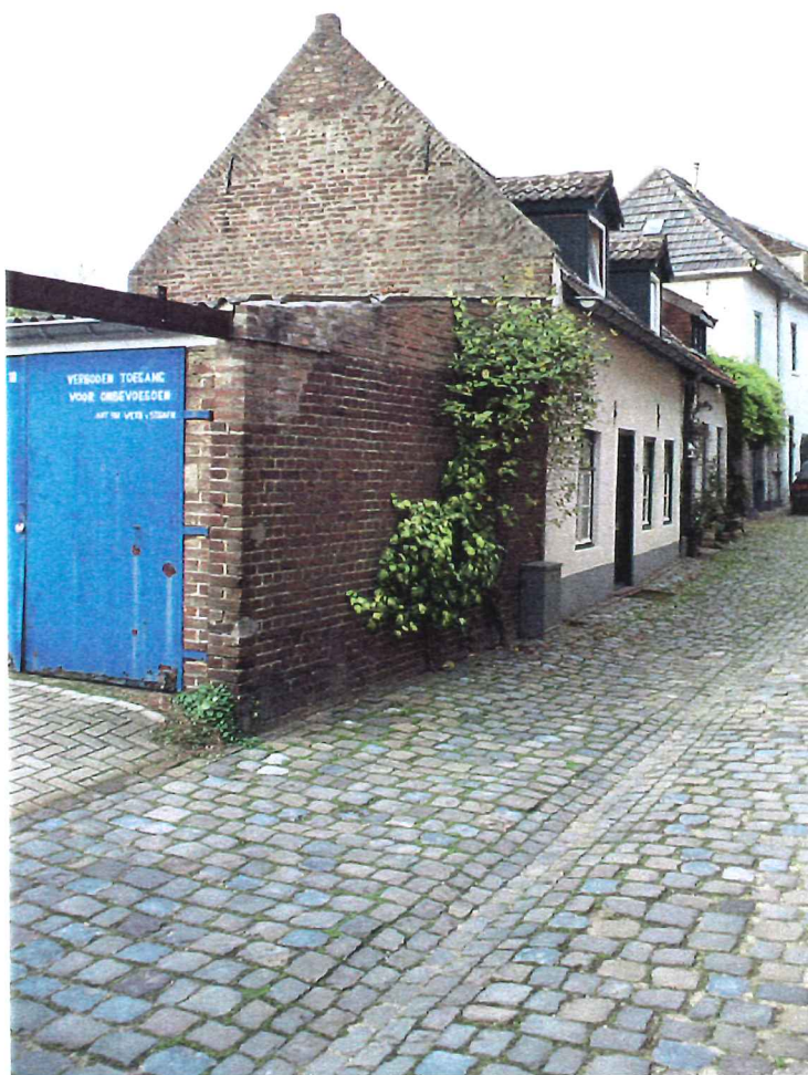
Afbeelding 171 Zuidelijke zijgevel met vlechtingen (A) en muurankers (B)
