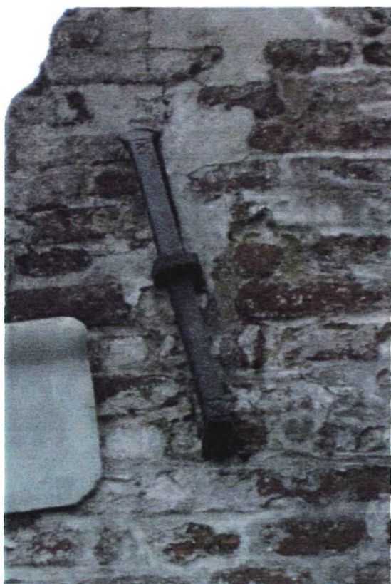
Afbeelding 153 Detail muuranker met ingeslagen Andreas-kruis
