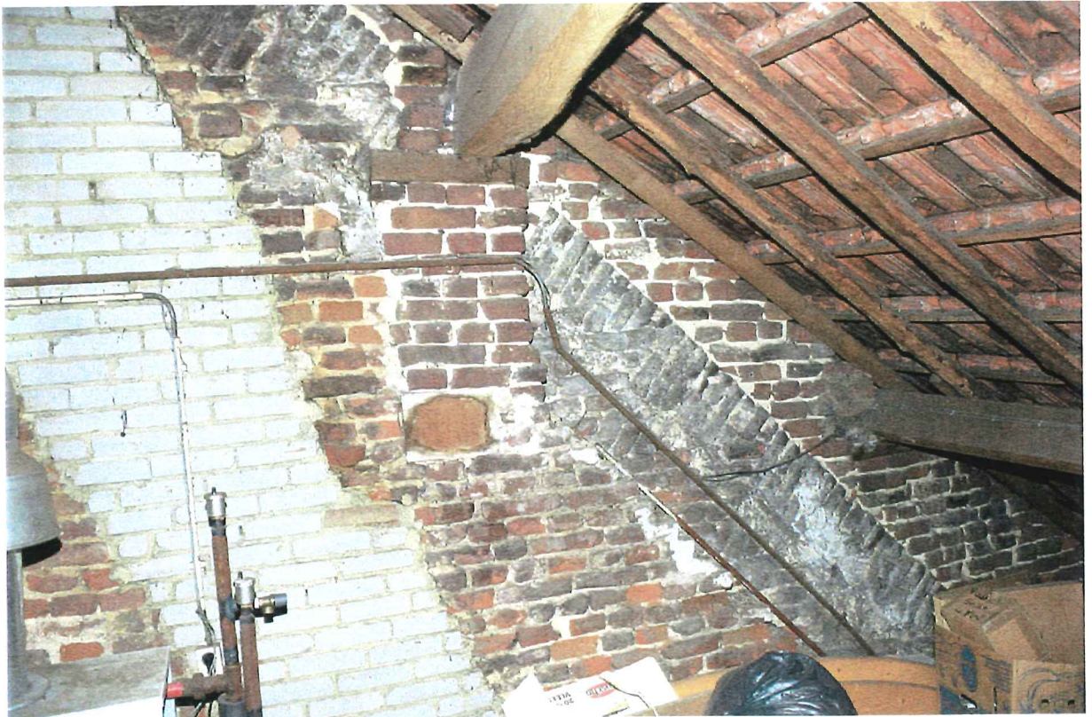
Afbeelding 88 Zolder: kapconstructie met naar boven verplaatste flieren (pijl A)
