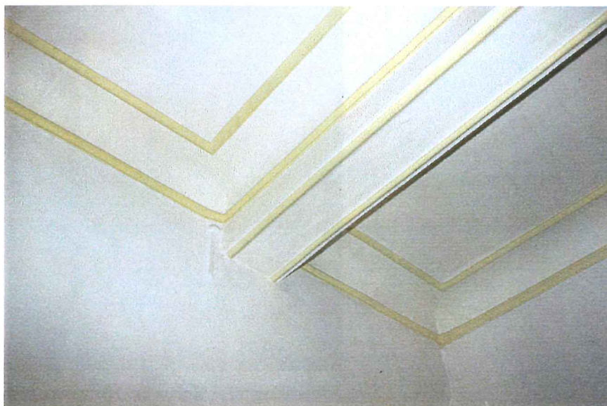
Afbeelding 43 Begane grond nr. 18: oorspronkelijke samengestelde balklaag, voorzien van stucwerk met lijsten; balkanker (A) in de scheidingsmuur naar Putstraat 20
