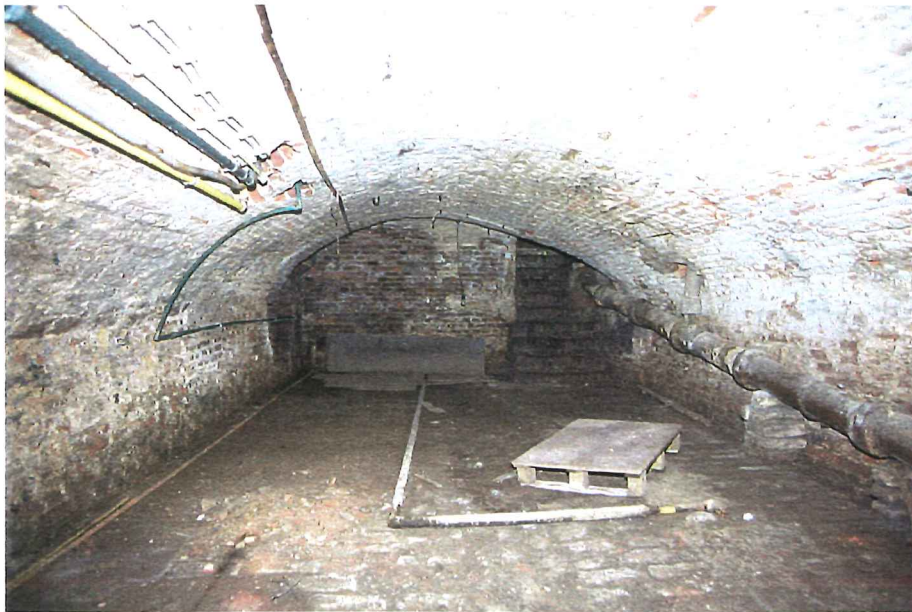
Afbeelding 17 Kelder: asymmetrisch gewelf aan achterzijde
