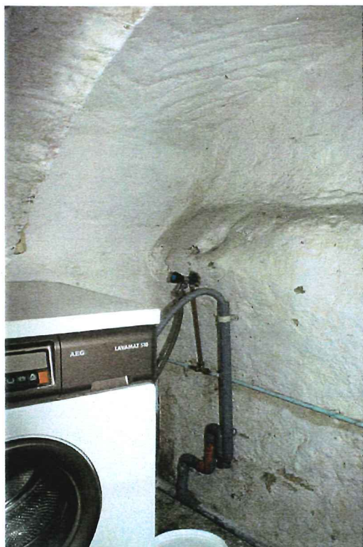
Afbeelding 82 Noordelijke kelder: mergelstenen aanzet tot gesloopt tongewelf (A)
