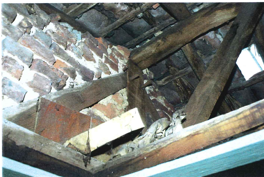
Afbeelding 191 Kapconstructie boven het oostelijk deel van het pand: aan de zuidzijde is een deel van het spant (A) zichtbaar
