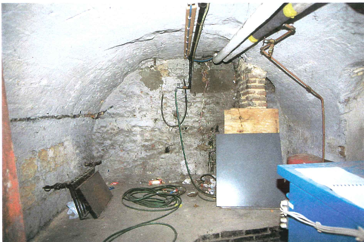
Afbeelding 36 Kelder nr. 16: dichtgezette opening aan straatzijde
