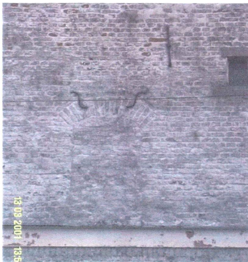
Afbeelding 151 Bouwspoor in voorgevel Moutschuur
