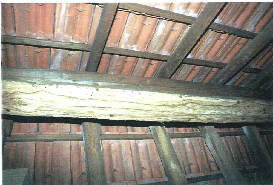
Afbeelding 160 Dakvlak: oorspronkelijke sporen aan de noordzijde (onder) en vervangen exemplaren aan de zuidzijde (boven)
