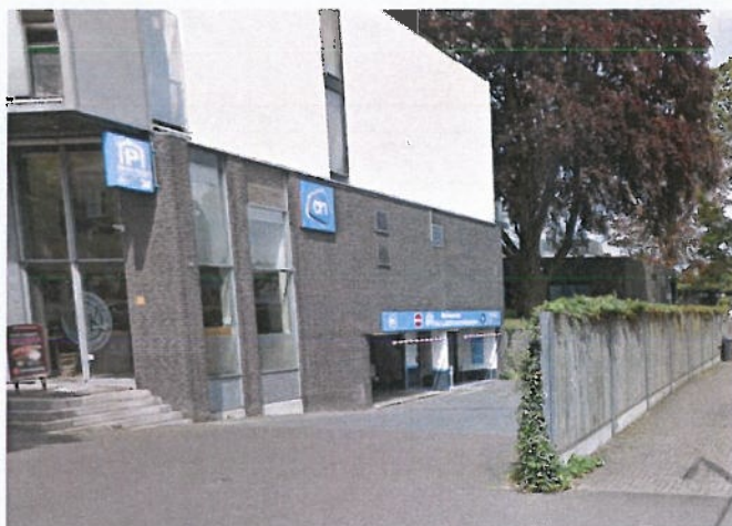
figuur 3: Foto locatie referentiemetingen parkeergarage Albert Heijn Arnhem (Bron: Google Maps)
