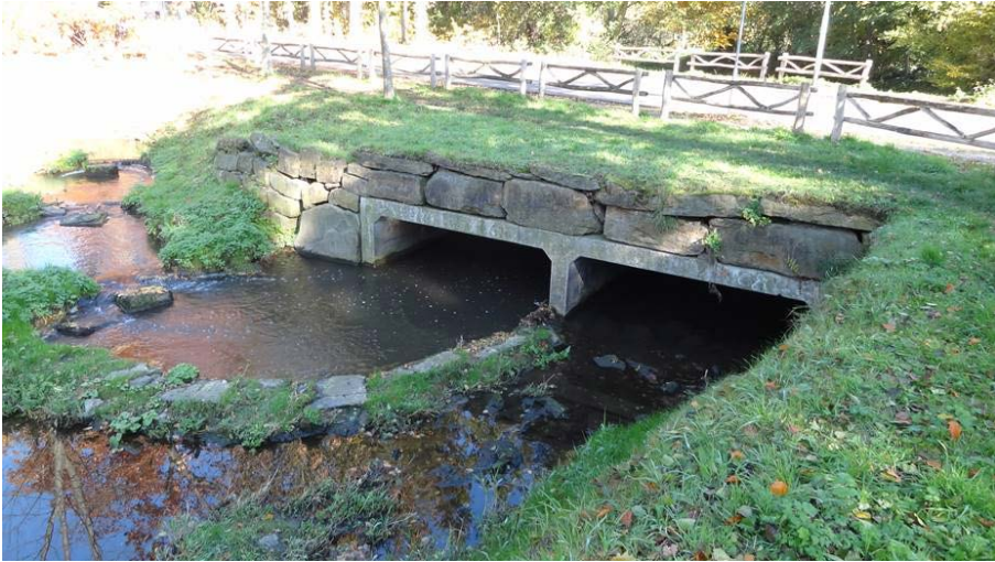
Figuur 6 De hoogwaterkokers onder de Molenweg.
