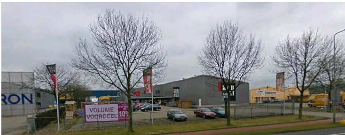
fig. 3 Voormalige Karwei bouwmarkt
