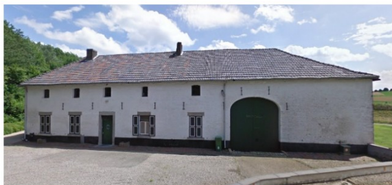
Figuur 24 Gevel van de woning Watersley 2-4
