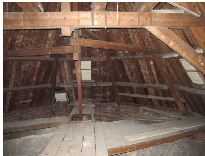
Kapelzolder, kapconstructie bij de koorsluiting.
