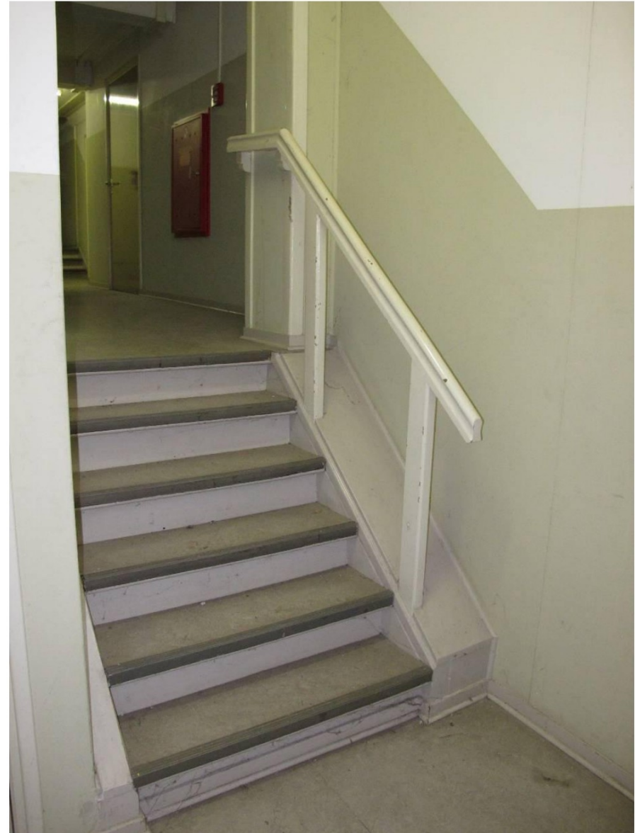
Trap in de centrale vleugel op de zolder die naar hoger niveau bij het dakhuis leidt.
