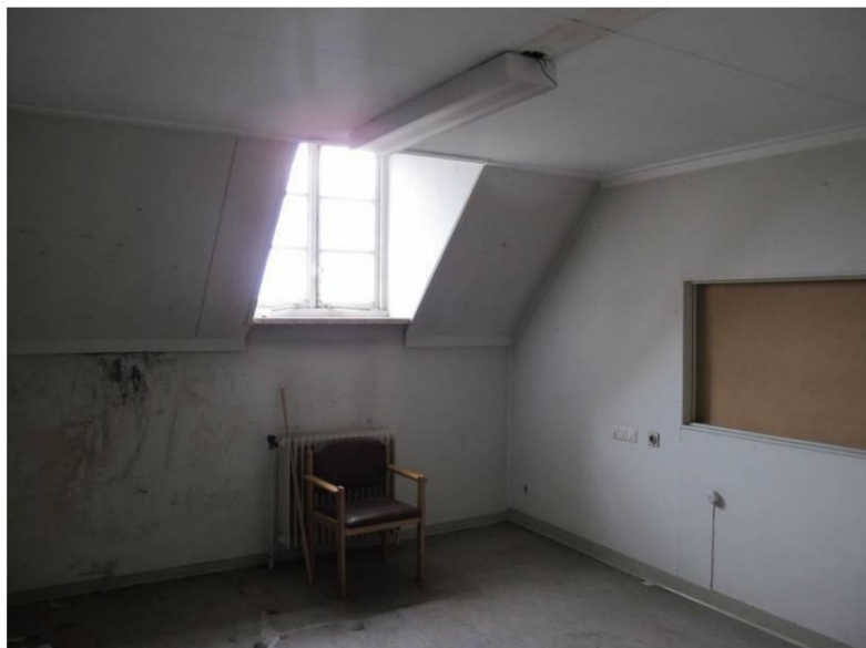
Een zolderkamer in de centrale vleugel.
