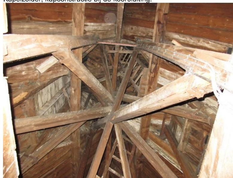
Kapelzolder. Constructie onder de dakruiter.
