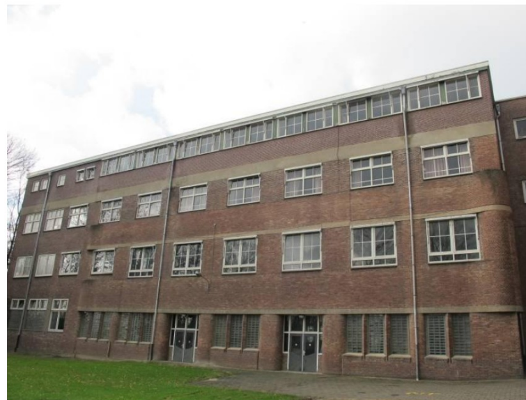
Overzicht voorgevel St. Josefsbau
