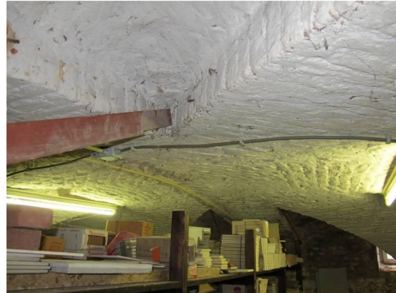
Samenkomst van de gordelbogen in de oude kasteelkelder.
