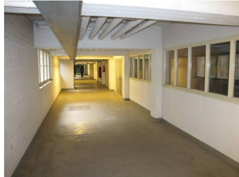
Gang in het souterrain van de schoolvleugel van de Antoniusbau met betonnen "portalen".
