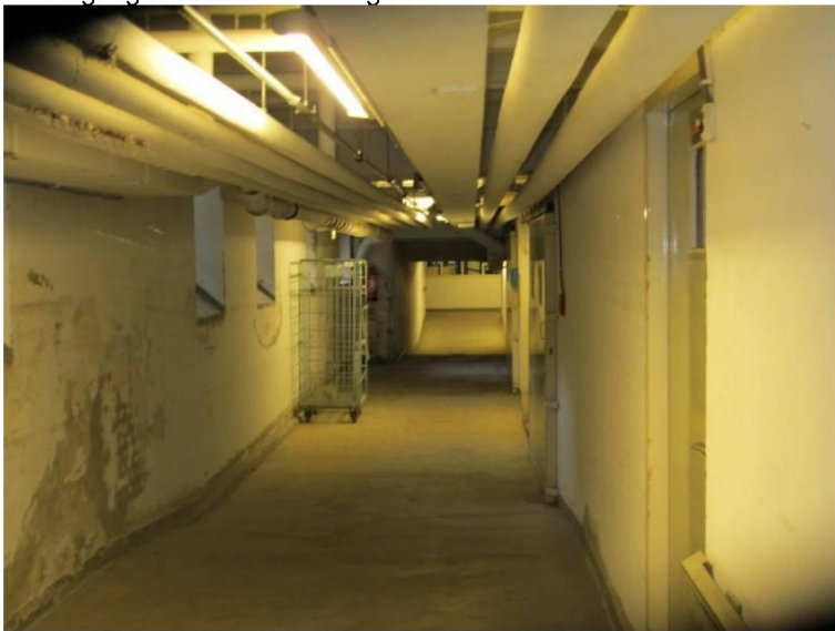
Keldergang onder de onderdoorgang van het verbindingslid van de Antoniusbau.
