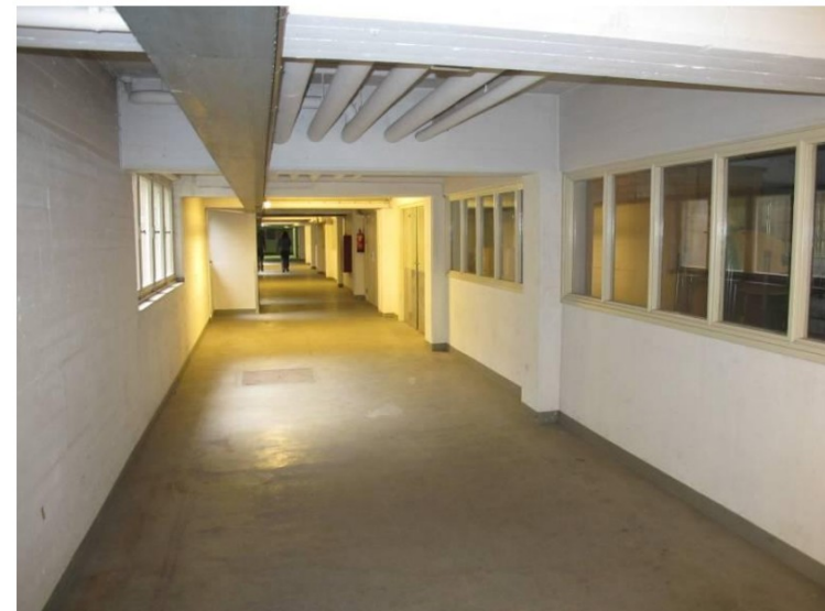
Keldergang in de schoolvleugel van de Antoniusbau uit 1960-63.
