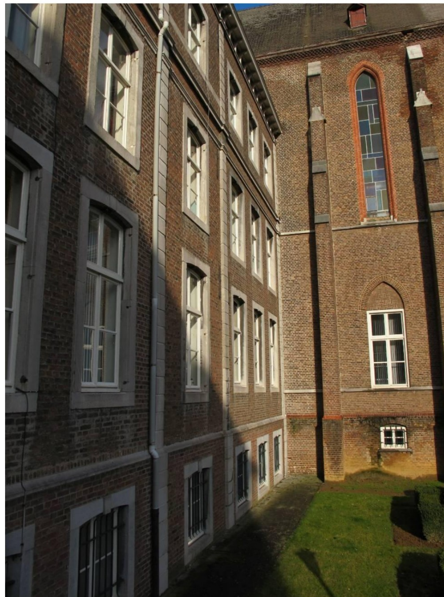
Rechter deel gevel richting kapel gezien.
