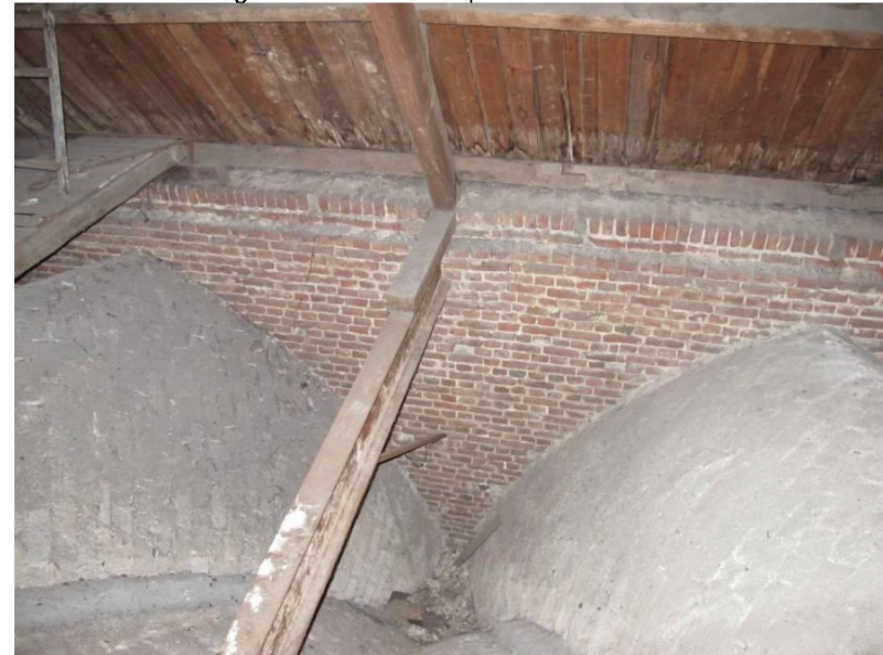
Stalen trek balk met houten slof en spantbeen op de kapelzolder.
