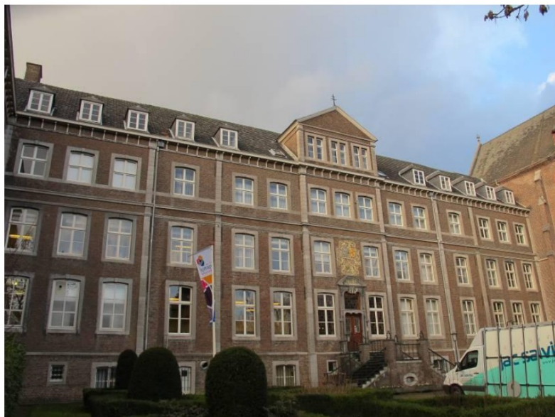
Overzicht van de voorgevel
