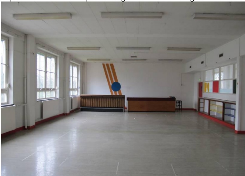
Zaal op de verdieping in de St. Josefsbau met betonnen wandkolommen en balken.
