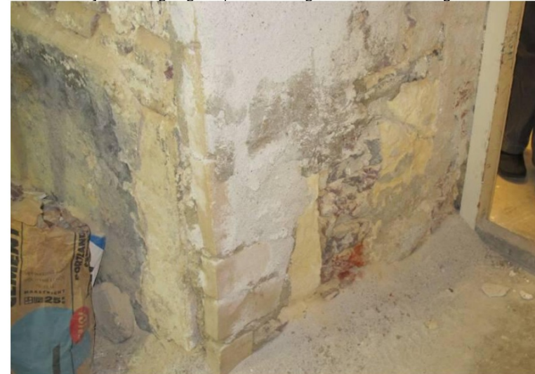
Zicht op het kistwerk van mergelblokken met baksteenpuin/mortelvulling in de doorgang van de kelder. FH MAB 2012
