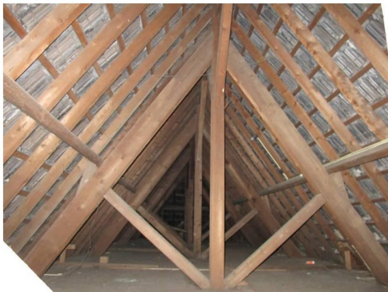
Vliering met kapconstructie boven de voorvleugel van de linker dwarsvleugel.
