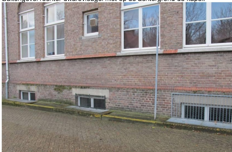
Jongere kelderlichten in de plint van de buitengevel van de rechter dwarsvleugel
