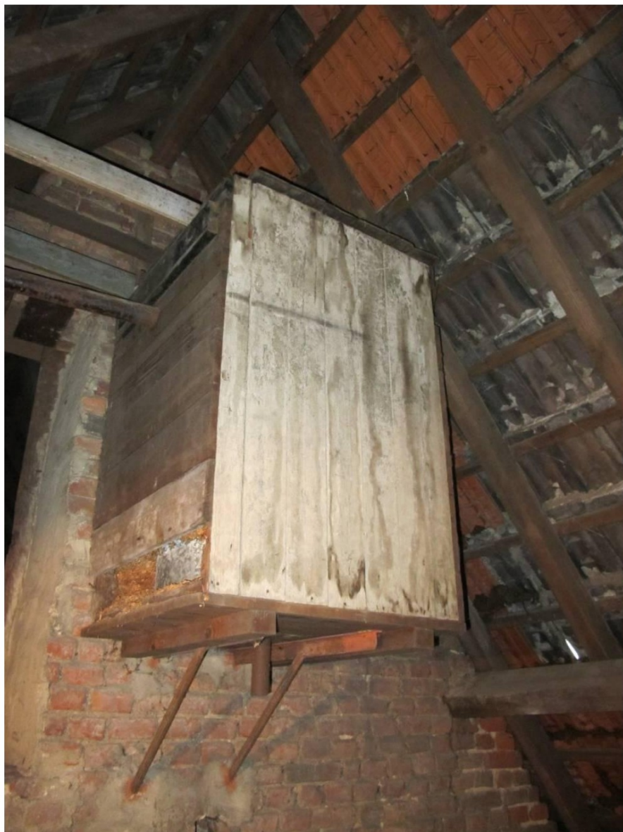
Watervat in geïsoleerde omkasting op de zolder tussen kapel en achtervleugel.
