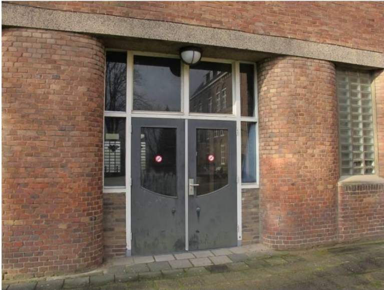
Detail deurpartij in voorgevel St. Josefsbau
