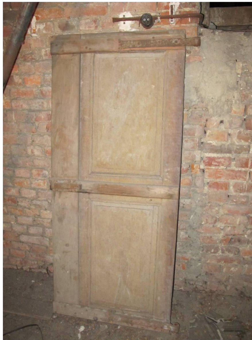
Thans losstaande paneeldeur uit de opening in de topgevel die toegang geeft tot de zolder boven de kapel.
