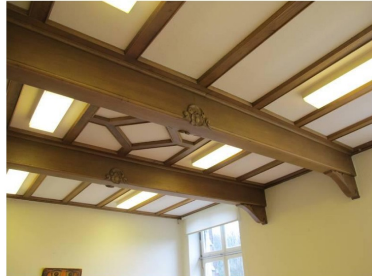
Balkenplafond uit de vroege jaren '60 in het middenvertrek op de verdieping van de centrale vleugel (voormalige werkkamer van de gardiaan)
