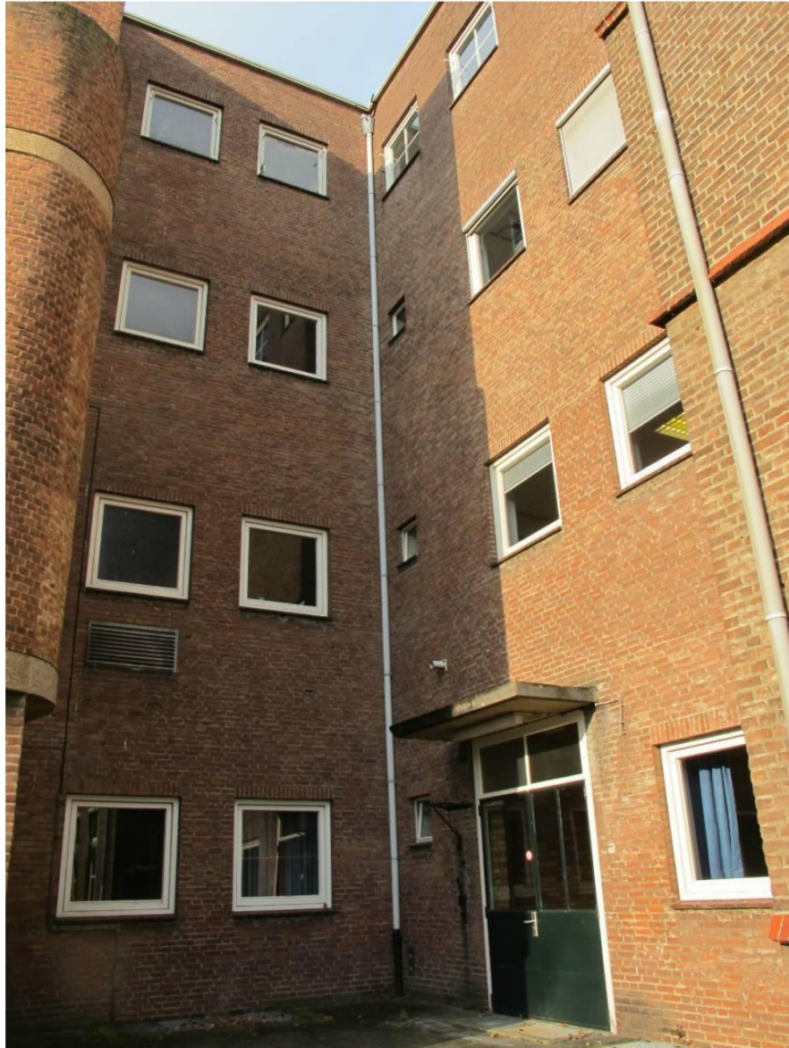
Antoniusbau: Verbindingslid tussen linker dwarsvleugel en St. Josefsbau.
