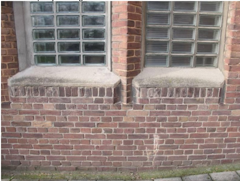
Detail venster in voorgevel St. Josefsbau
