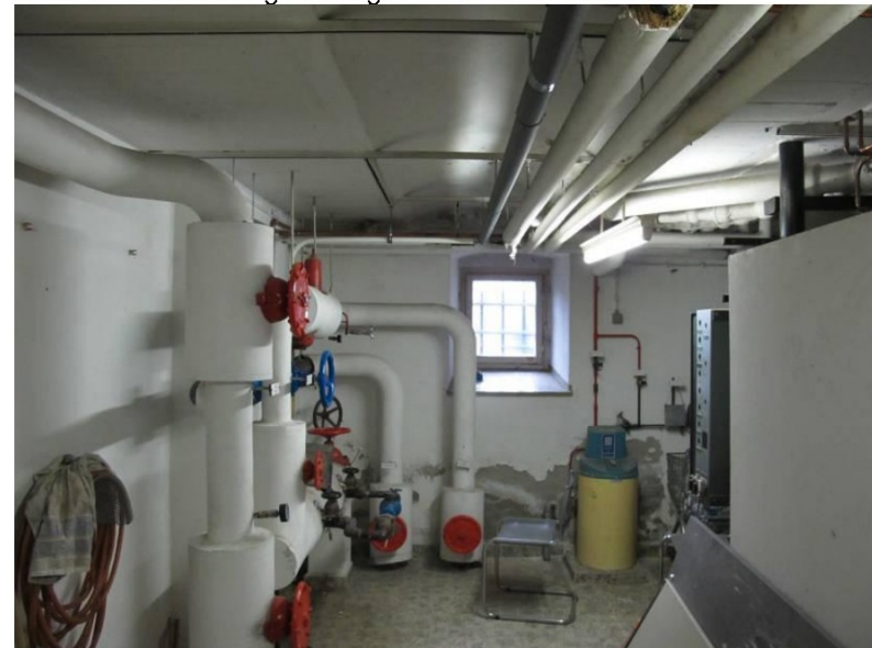
De oude stookkelder met troggewelven uiterst links in de centrale vleugel.
