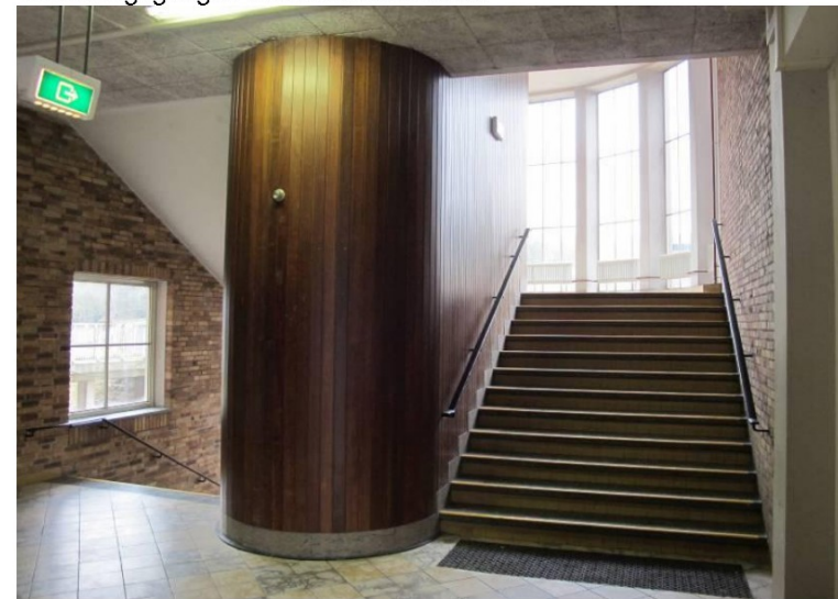
Antoniusbau, het trappenhuis op de verdieping gezien. De zware centrale kolom links naast de trap is niet oorspronkelijk, de vloeren, trappen en de plafondplaten wel!
