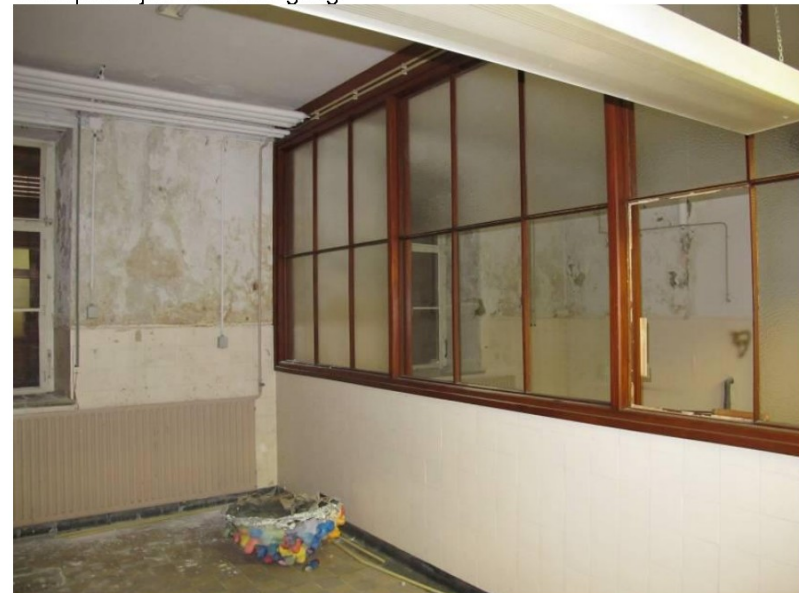
Scheidingswand tussen voormalige keuken en nevenruimte.
