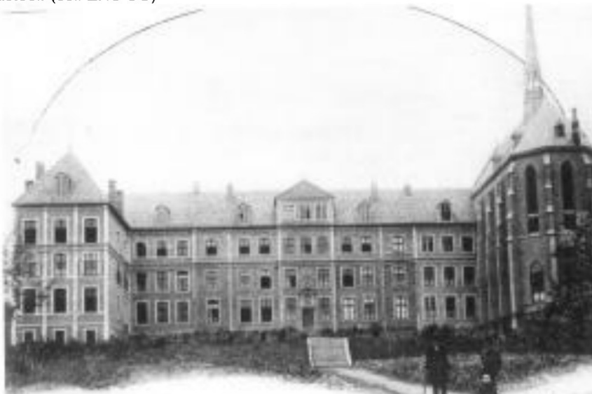
1902. Ook fase 2 is voltooid met de rechter vleugel met kapel en de verhoging van het kasteeltje dat nu volledig is ingebouwd (coll EHC SG)
