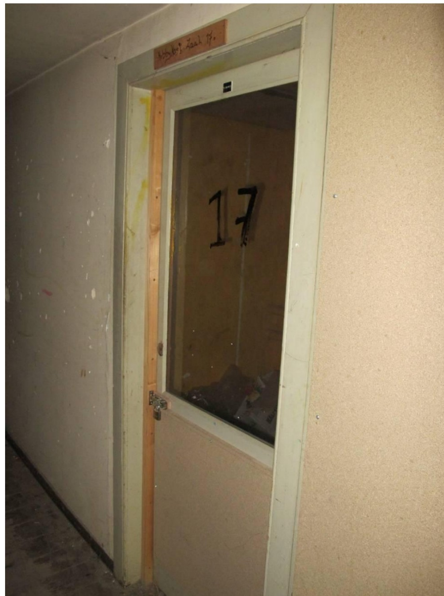
Oorspronkelijk deurkozijn met (afgeplate) paneel deur op de zolder van de rechter dwarsvleugel.
