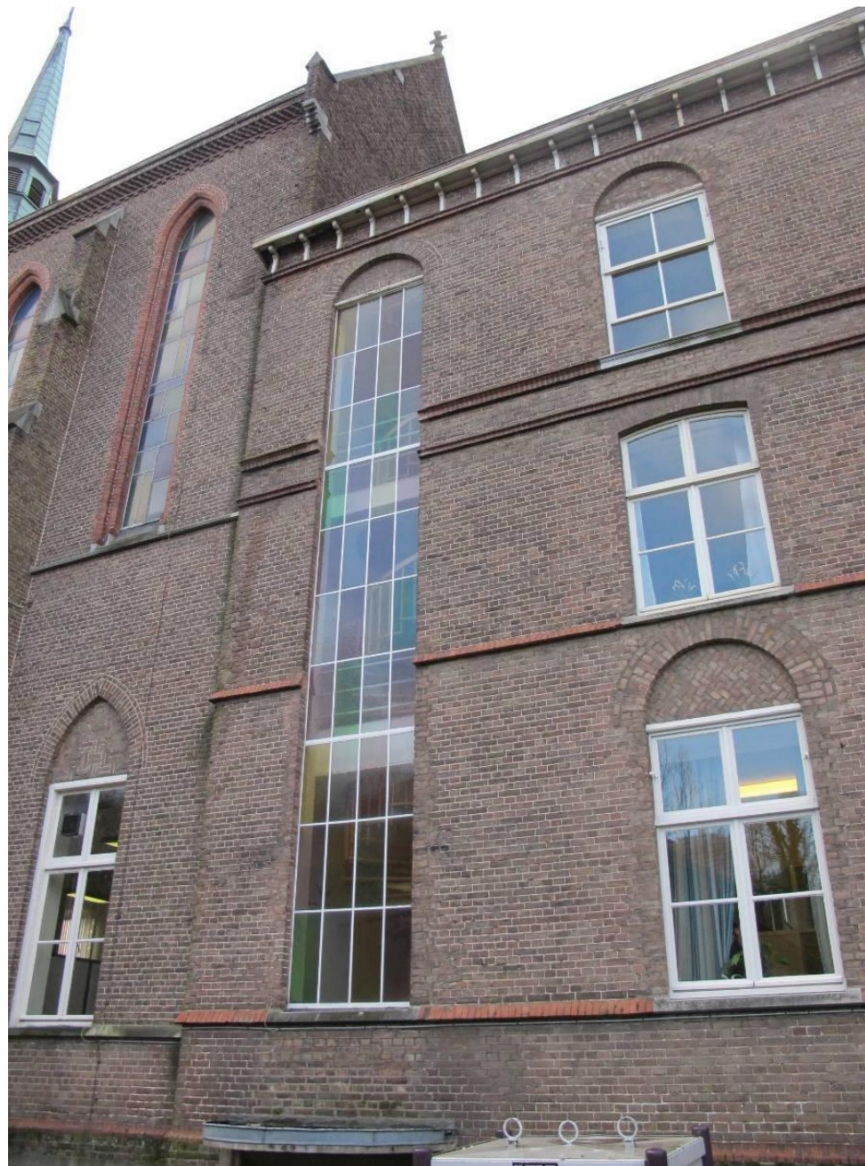
In 1963 ingebroken trappenhuisvenster in buitengevel rechter dwarsvleugel.
