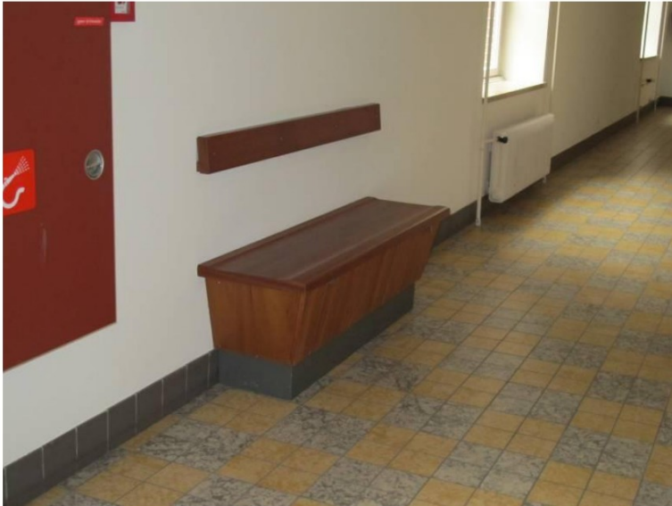
Vloer en zitbankje in de verbindingsgang op de verdieping naar de oude linker dwarsvleugel van het hoofgebouw.
