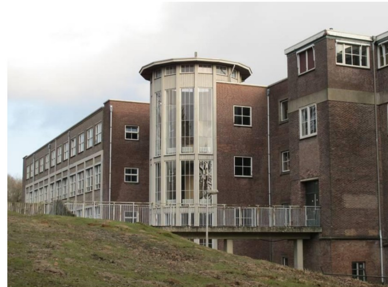
Trappenhuis en schoolvleugel van de Antoniusbau.
