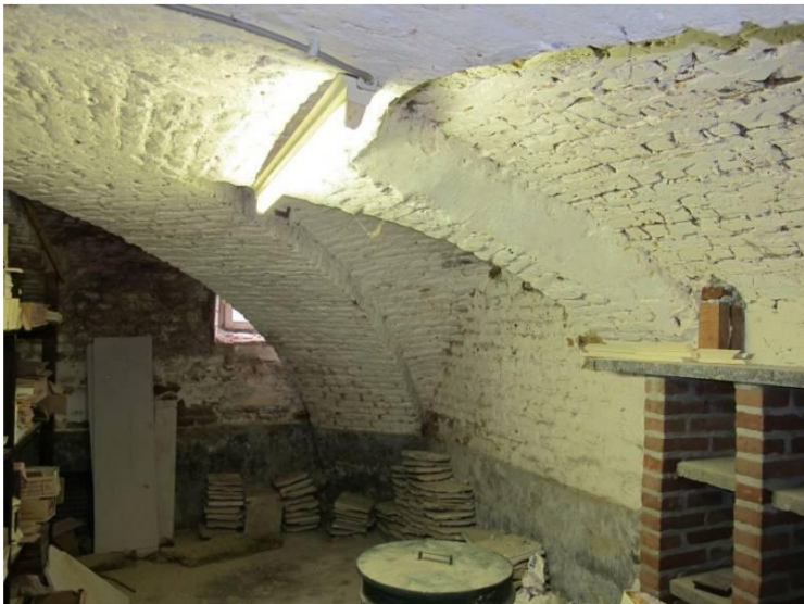
De oude kasteelkelder met rechtsboven het later gedichte gewelfvak, waar oorspronkelijk de toegangstrap doorheen was gestoken.
