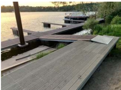
Passantensteigers aan het Leukermeer, realisatie 2019
