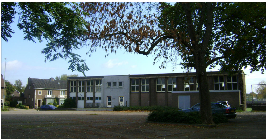
Figuur 1.3: de westelijke (voor)gevel van het leegstaande schoolgebouw in het plangebied
