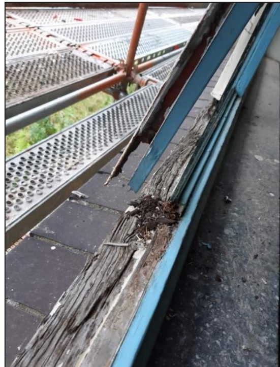
Figuur 5 en 6: Zicht op hardsteen en betonwerken kloostergevel (links) en rotte raamkozijnen in een van de twee andere opstallen.
