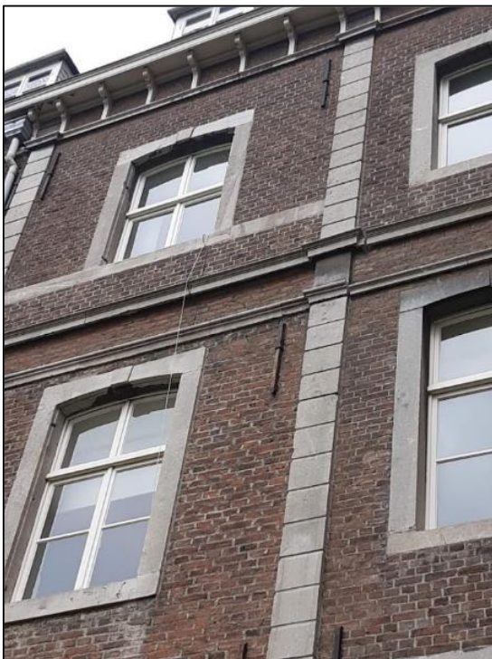
Figuur 5 en 6: Zicht op hardsteen en betonwerken kloostergevel (links) en rotte raamkozijnen in een van de twee andere opstallen.
