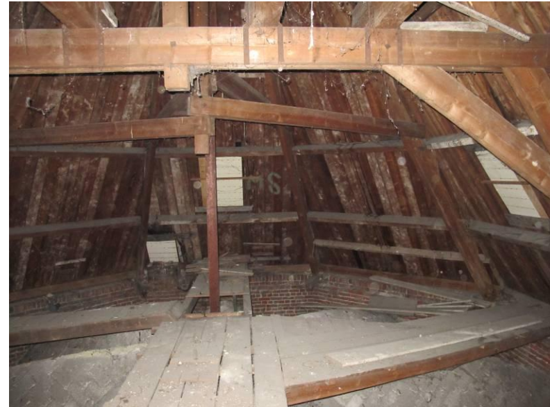
Kapelzolder, kapconstructie bij de koorsluiting.
