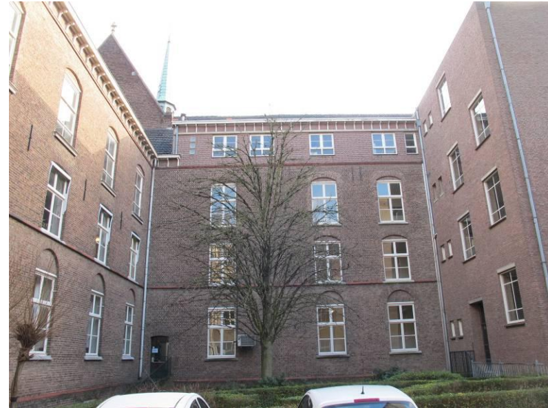
Achtergevel centrale vleugel en zijgevel rechter dwarsvleugel.
