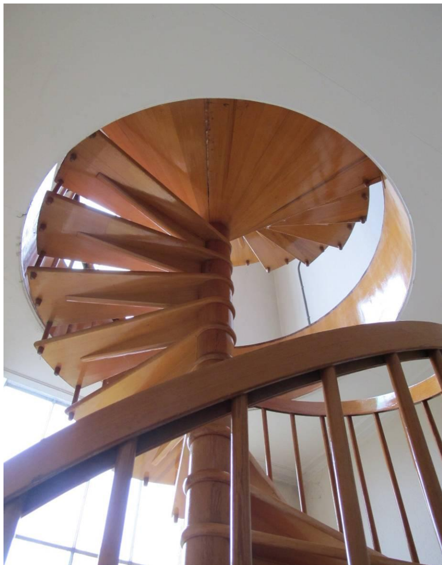
De door twee broeders in 1963 gemaakte eiken wenteltrap in de voormalige trappenhuissectie tussen de kapel vleugel en de achter vleugel in het rechter deel van het hoofdgebouw.
