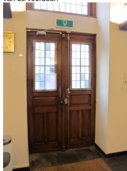
Binnenzijde van de oude hoofdentree in de hal van het voormalige kasteel.
