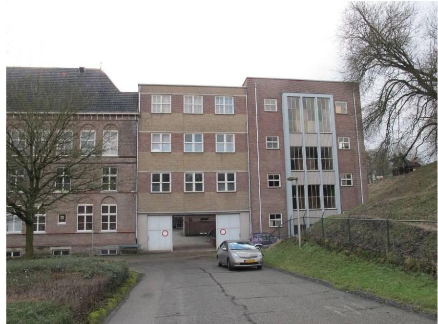
Verbindingslid met onderdoorgang van de Antoniusbau met rechts de kopgevel van de schoolvleugel. Links de oude vleugel uit 1900-1902.
