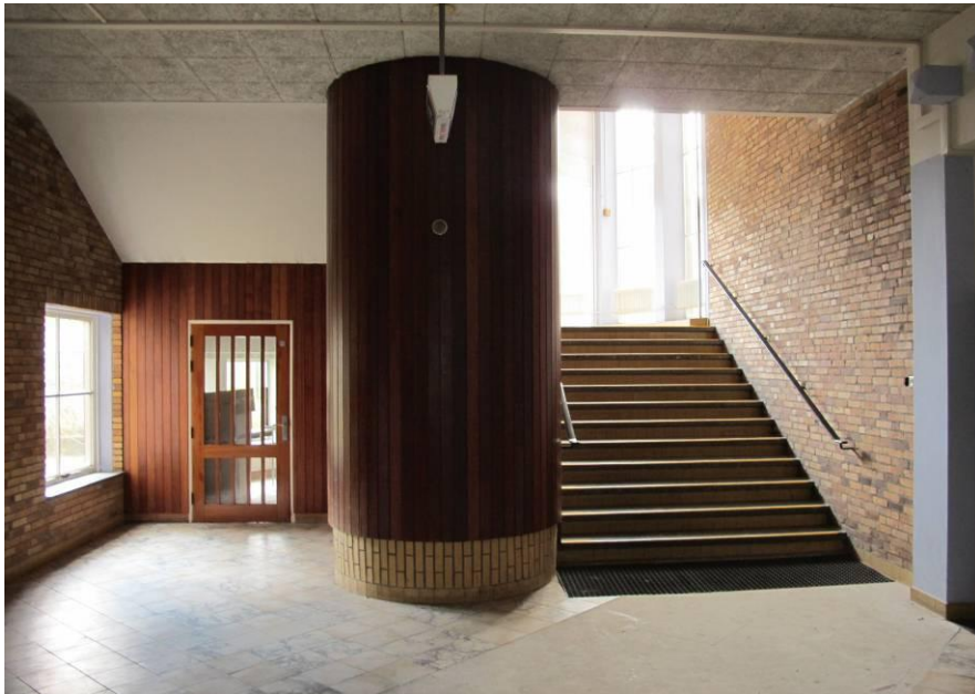
Antoniusbau, het trappenhuis op de begane grond gezien. De pui en de zware centrale kolom links naast de trap zijn niet oorspronkelijk, de plafondplaten wel!
