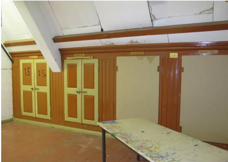
Wandkasten met kraaldelen betimmering en dubbele paneeldeuren uit 1902 op de zolder van de rechter dwarsvleugel.
