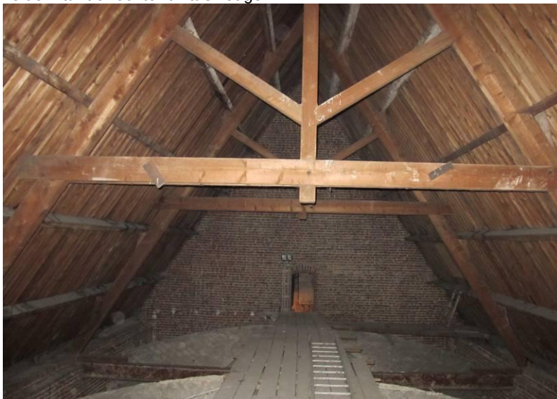
Kapelzolder met kapconstructie en loopplanken over de gewelven, gezien richting de topgevel.
