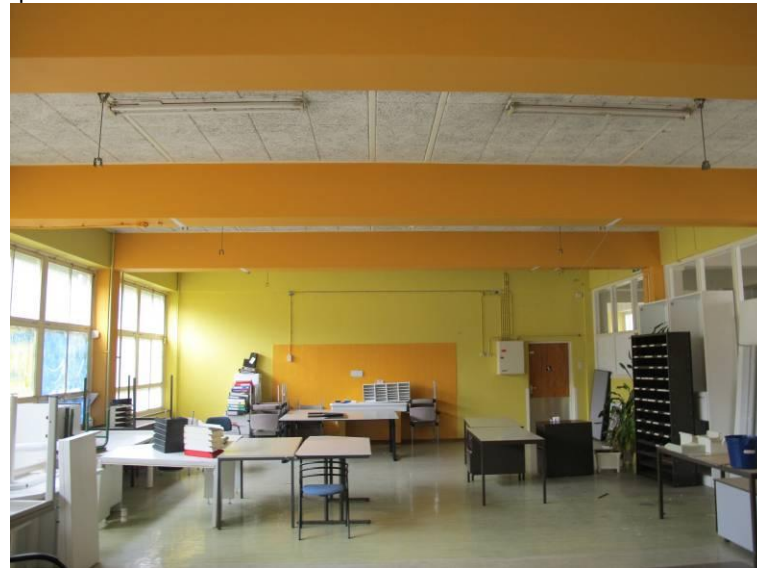
Lokaal in de schoolvleugel van de Antoniusbau met zware betonnen balken en wandkolommen.
