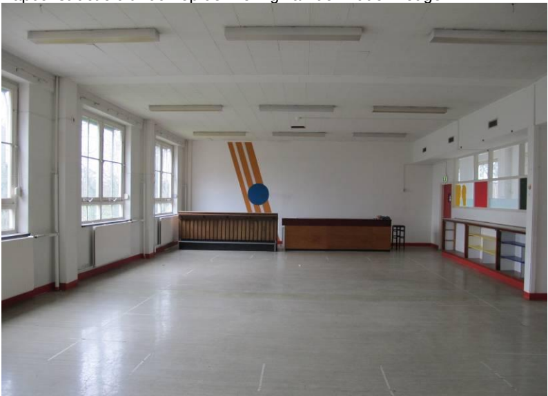
Zaal op de verdieping in de St. Josefsbau met betonnen wandkolommen en balken.
