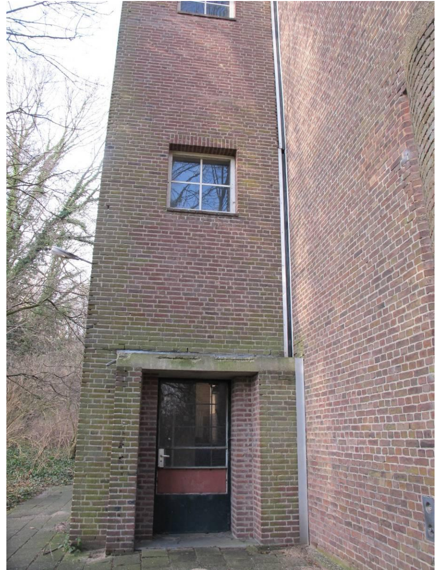
Trappenhuis uit late jaren '60 tegen kopgevel St. Josefsbau.
