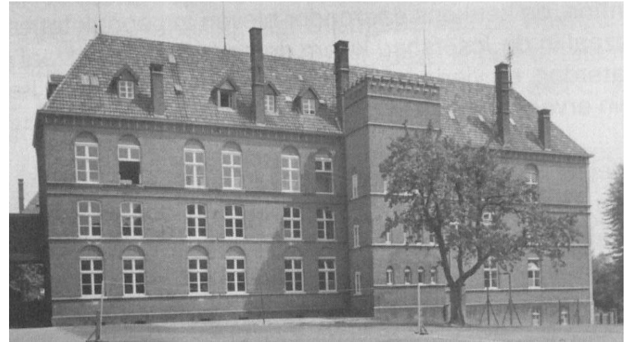
De zijgevel van de in 1897-98 gebouwde linker vleugel van het oude hoofdgebouw met nog de toilettoren en de forse schoorstenen op de kap. Links is nog de oude verbindingsgang zichtbaar tussen deze vleugel en de Josefsbau, die in 1960 plaats maakte voor een nieuwe hoge verbinding met trappenhuisstoren van de Antoniusbau. (PA OFM Fulda)
