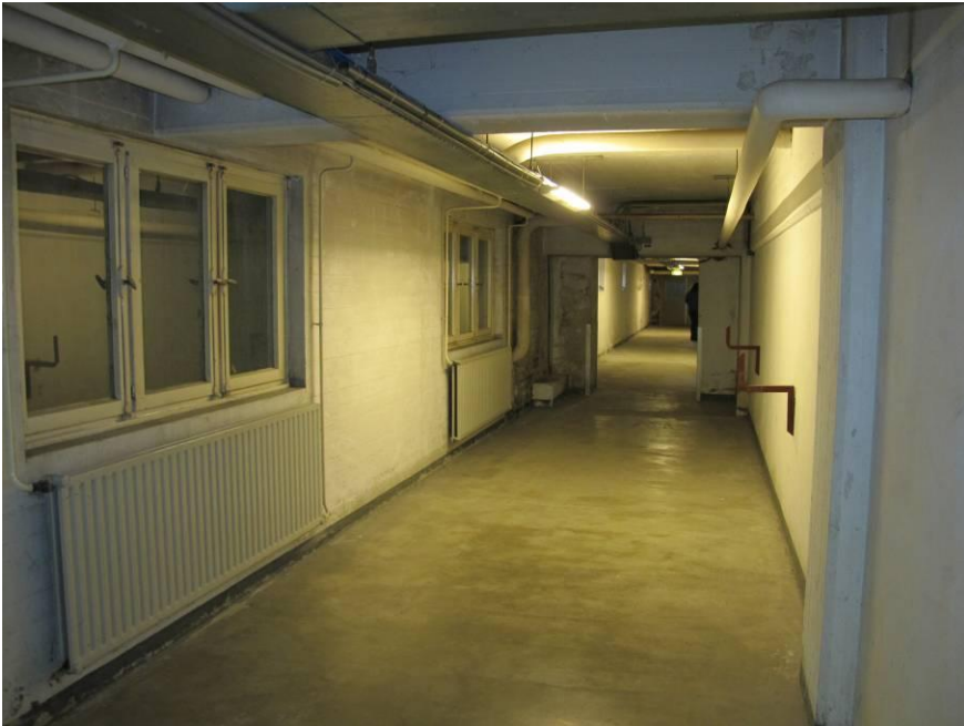
Keldergang onder het verbindingslid met entree op de binnenplaats van de Antoniusbau gezien richting de keldergang onder de oude linker dwarsvleugel.
