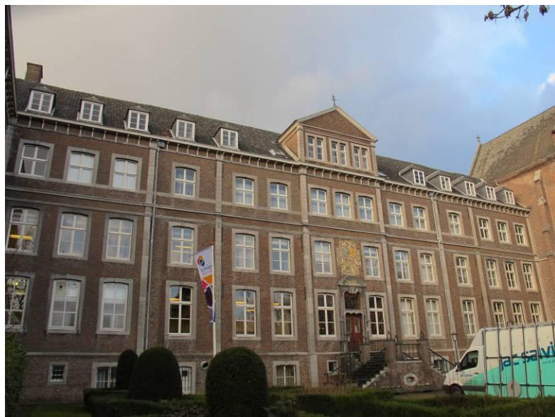
Overzicht van de voorgevel
