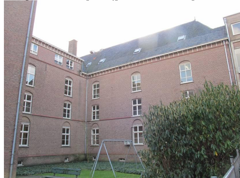
Achtergevel centrale vleugel en zijgevel linker dwarsvleugel
