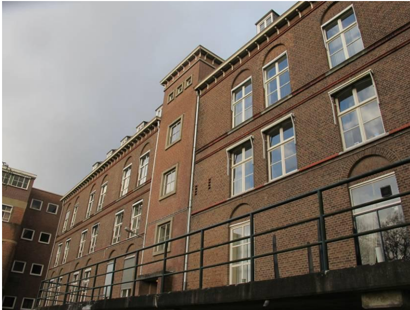
Buitengevel van de linker dwarsvleugel met in het midden de trappenhuisstoren uit de jaren '60.
