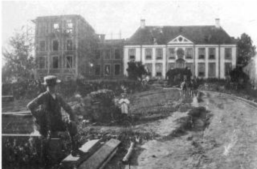
Een bijzondere foto van Watersley tijdens de bouw van de eerste fase, links van het kasteel. (coll EHC SG)
