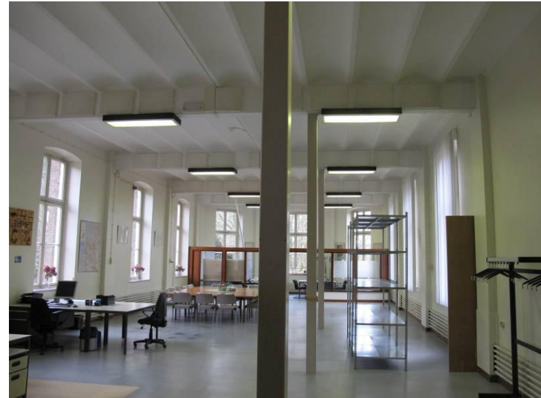
De voormalige studiezaal onder de kapel met troggewelven. De kolommen zijn veel later geplaatst.
