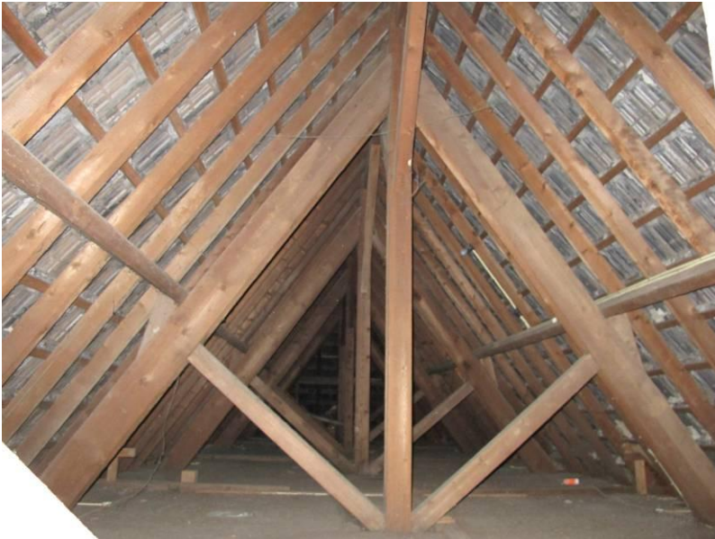
Kapconstructie uit 1901 op de vliering van de middenvleugel.
