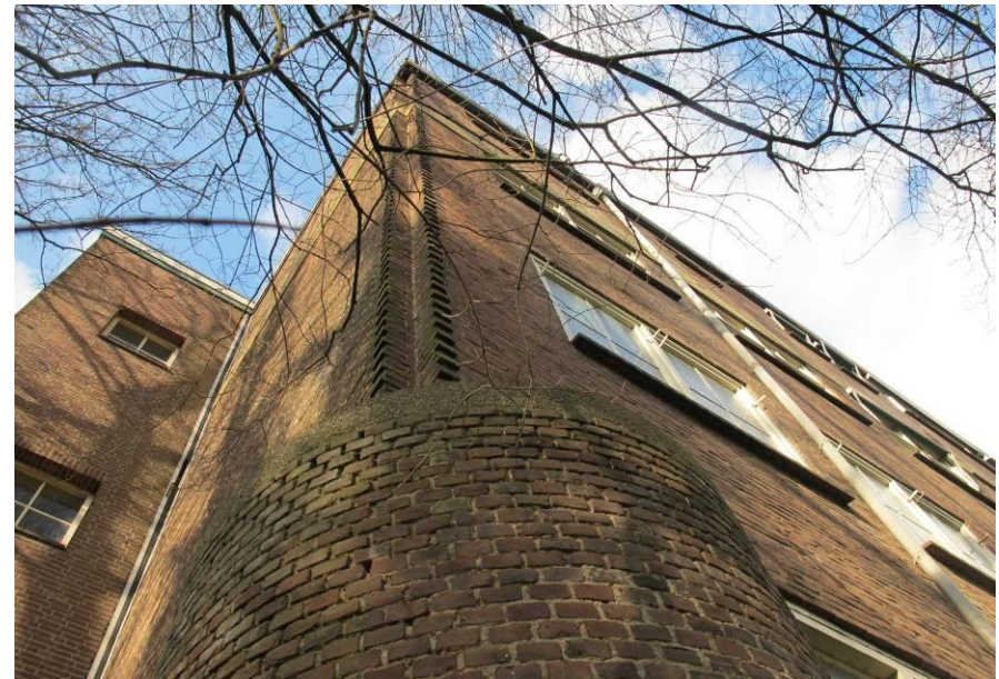
Linker hoek voorgevel St. Josefsbau met de vertandingen en daaronder de ronde hoekpartij.
