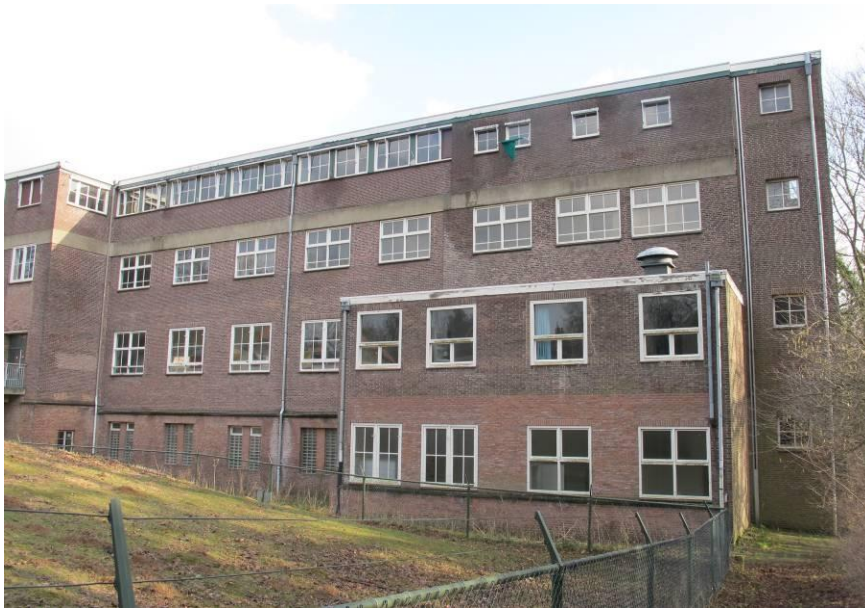
Overzicht achtergevel St. Josefsbau
