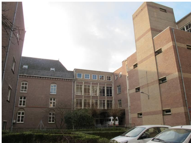
Het verbindingslid met entree en rechts daarvan de lifttoren met annexen van de schoolvleugel van de Antoniusbau. Links de oudbouw.
