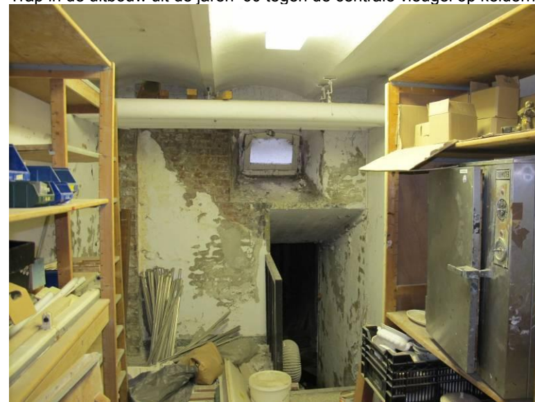
Kelderruimte uit 1897/98 onder de linker dwarsvleugel met op de achtergrond een latere doorgang naar twee buiten het gebouw gelegen betonnen kelders.
