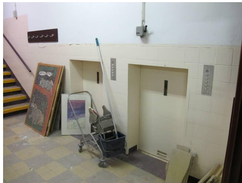
Transportliftjes in de doorgang
