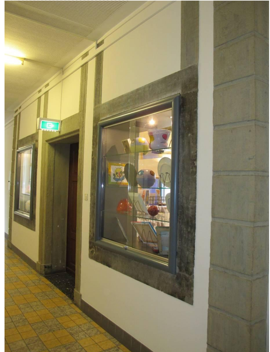
Detail van de door Laudy in 1968-70 weer in de gang in het zicht gebrachte elementen van de achtergevel van het kasteel.
