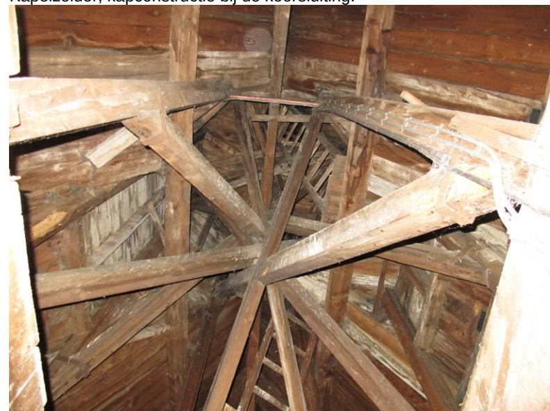
Kapelzolder. Constructie onder de dakruiter.
