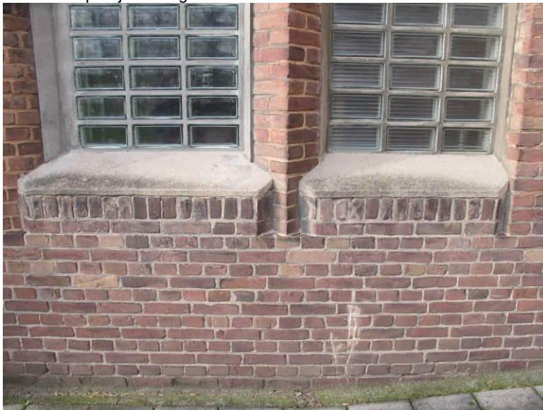
Detail venster in voorgevel St. Josefsbau
