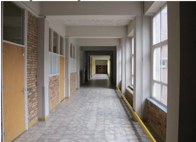
Gang in de schoolvleugel van de Antoniusbau op de tweede verdieping aan de zijde van de binnenplaats. De meeste hier zichtbare elementen en afwerking dateren nog uit de bouwtijd.
