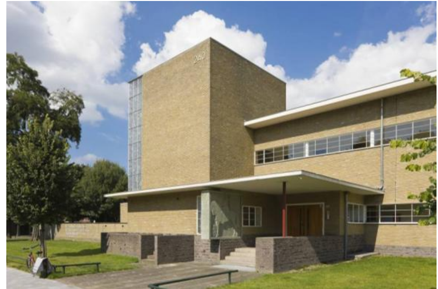
Rijks HBS Koning Willem II Tilburg. Functionalistische architectuur van Jos Wielders, de bouw is begonnen in 1934.
