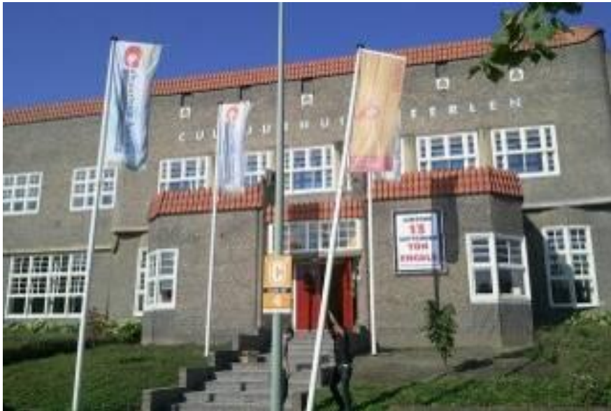
Het Cultuurhuis in Heerlen, een oorspronkelijk in 1921 door Jos Wielders voor de Franciscanen in Amsterdamse School-stijl gebouwd onderdeel van een complex dat was bestemd voor de opvang van mijnwerkers en hun gezinnen.
