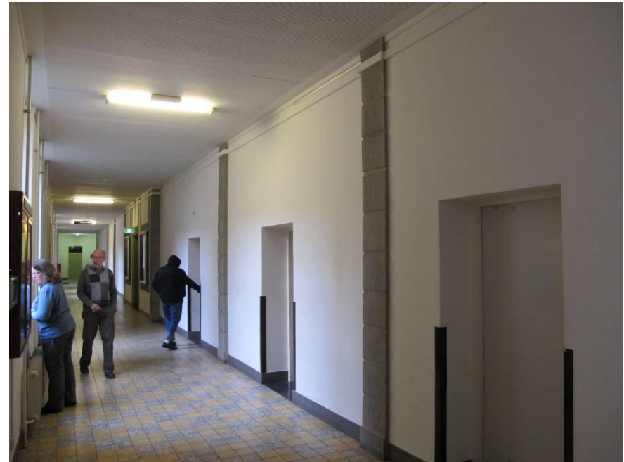
Achtergang op de begane grond van de centrale vleugel met bij de rechter wand de weer in het zicht gebrachte pilasters van de oude achtergevel van het kasteel. Verdere afwerking zijn modern, daterend overwegend uit de periode dat de Paulusstichting het goed betrok.
