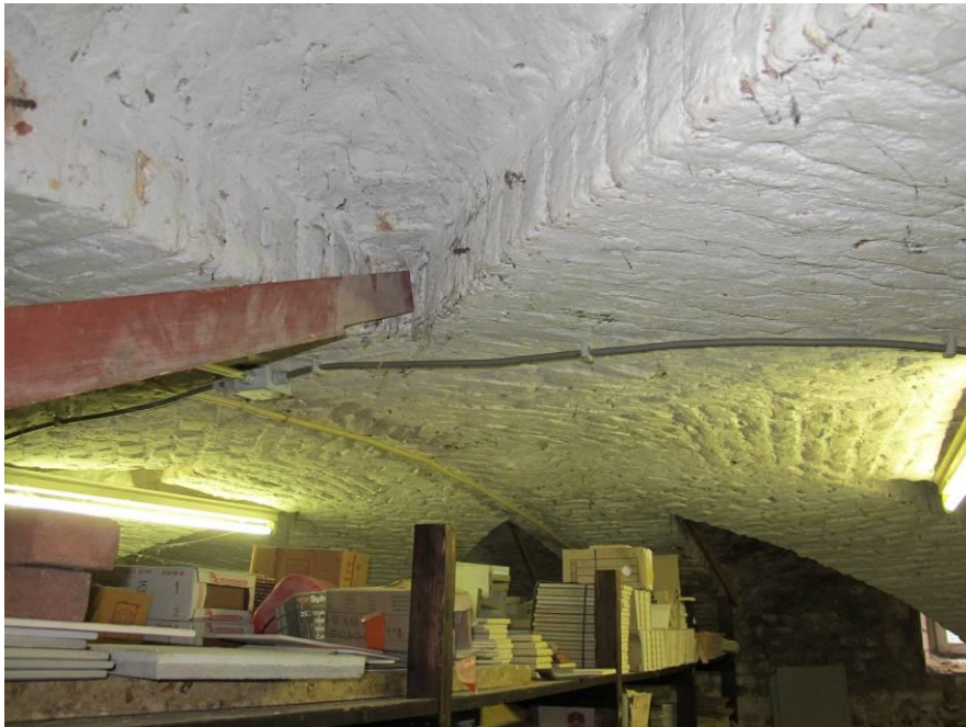
Zicht op het middendeel van het achtdelige gewelf van de kelder onder de vestibule van de voorvleugel. FH MAB 2012
