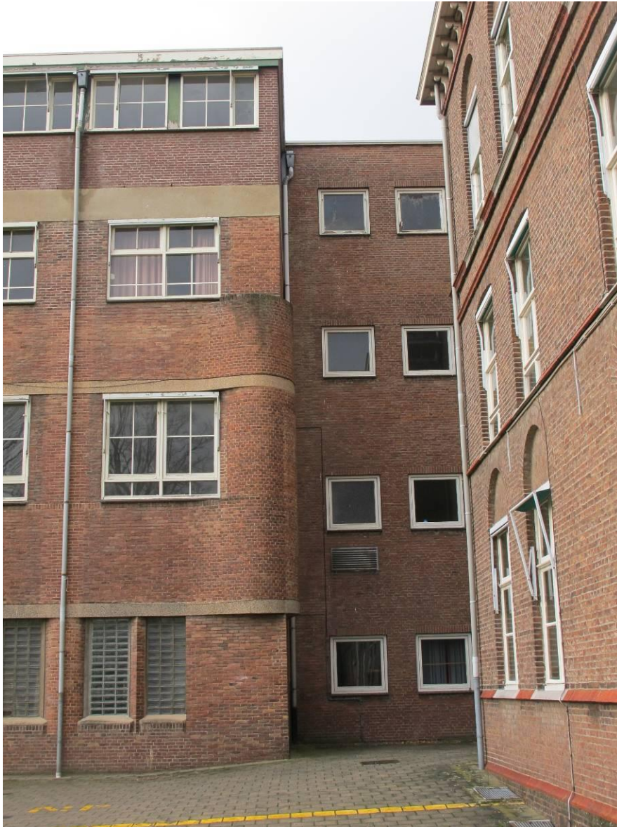
Rechter hoek voorgevel van de St. Josefsbau en het verbindingslid uit de jaren '60.
