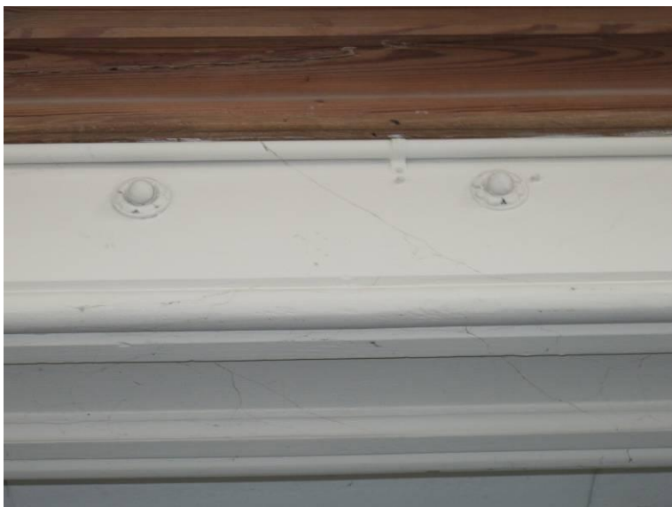
Detail van de omtimmerde stalen balk onder de orgelgalerij.
