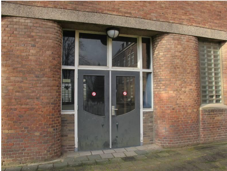
Detail deurpartij in voorgevel St. Josefsbau
