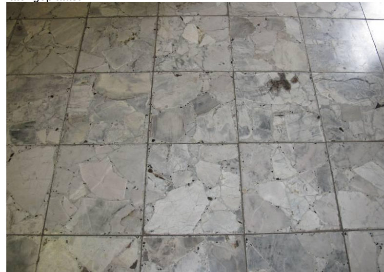
Detail vloer in trappenhuis/lift uitbouw tegen de achtergevel van de centrale vleugel.
