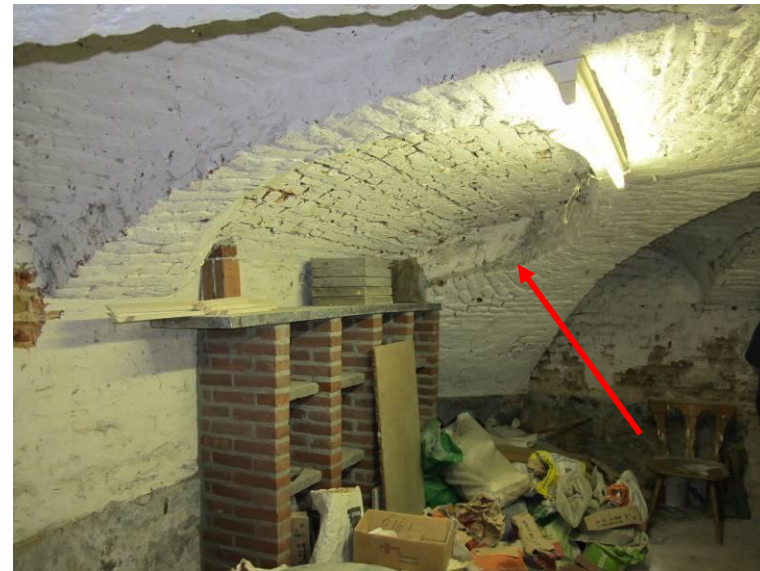
Linker zijde van de kelder met gewelf. De rode pijl wijst naar de plaats waar vermoedelijk de toegangstrap door het gewelf heen heeft gestoken. FH MAB 2012
