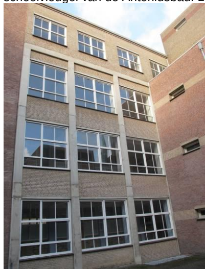
Linker deel binnenplaatsgevel schoolvleugel Antoniusbau.
