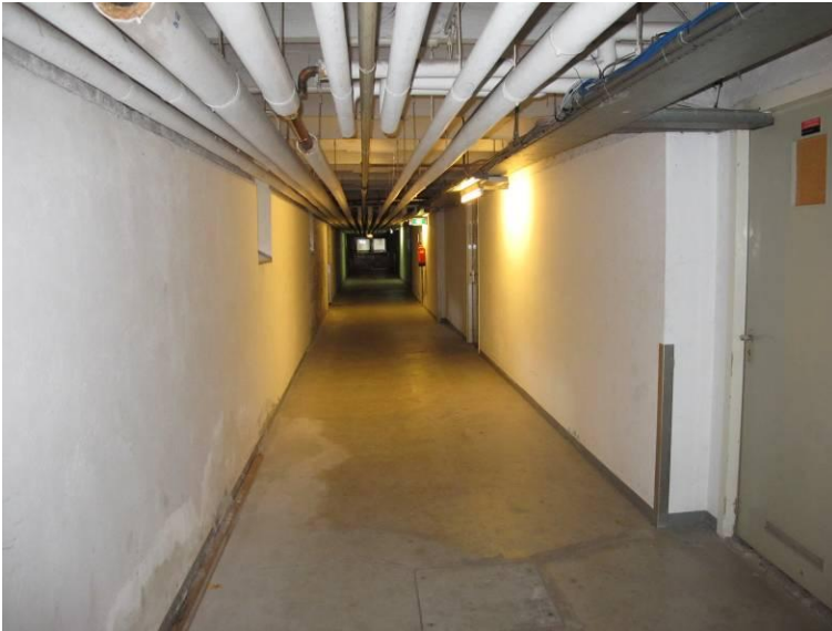
Keldergang in de centrale vleugel.
