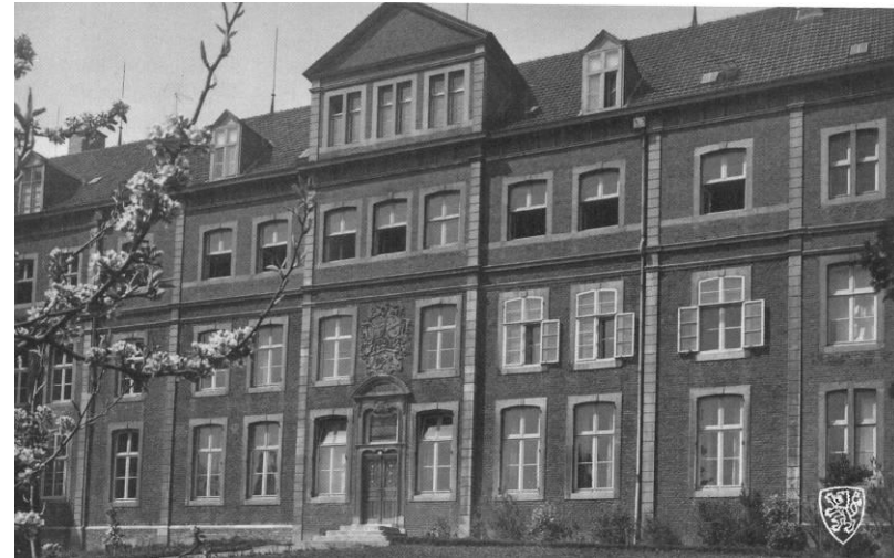
Middendeel van de voorgevel van het hoofdgebouw in de vroege jaren '60. De oude trap is nog aanwezig en de kelderzone is nog niet als een souterrain vrijgelegd. De ramen op de verdieping bezitten nog voorzetramen. (EHC SG)
