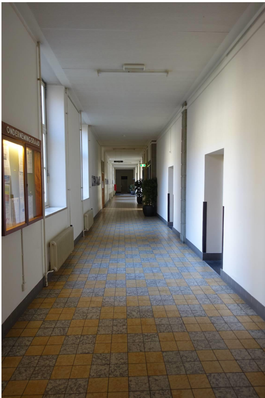
Achtergang op de begane grond van de centrale vleugel naar het noorden gezien.
