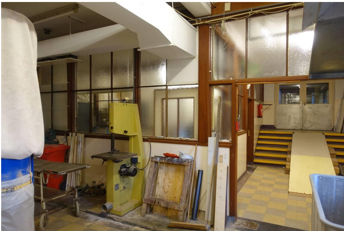
Kelderruimte met werkplaats onder het oostelijke deel van de zuidelijke vleugel.
