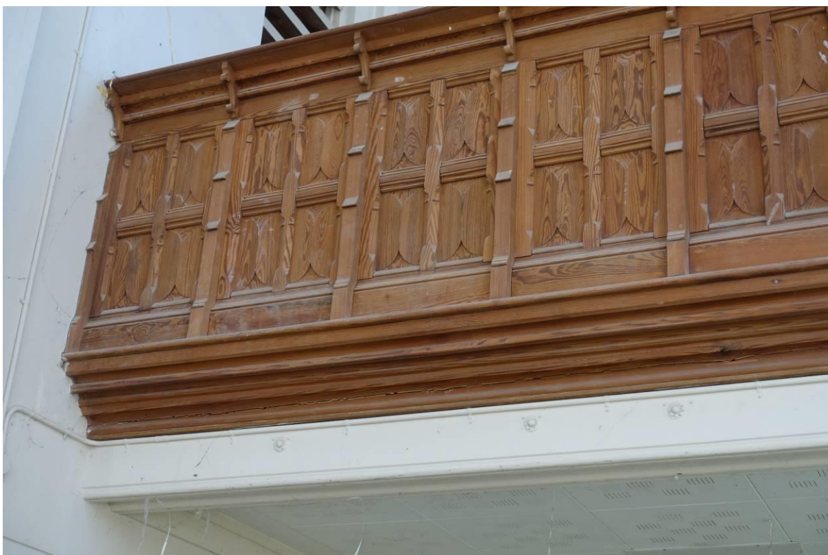
Linker deel van de oorspronkelijke neogotische balustrade van het orgelbalkon.
