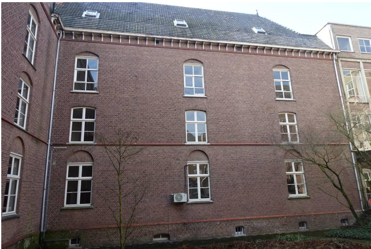
Noordgevel van de zuidelijke vleugel aan de binnenplaats.
