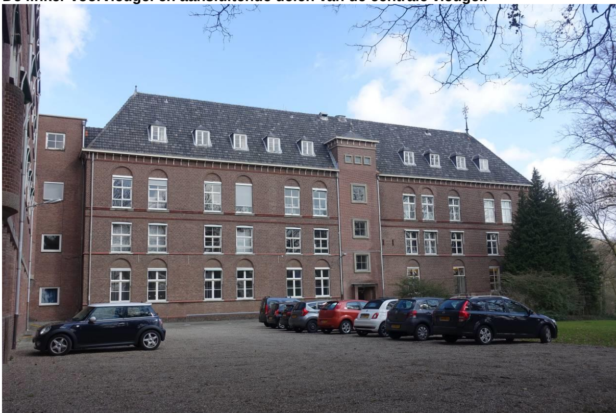
De zuidelijke gevel van de zuidelijke vleugel.
