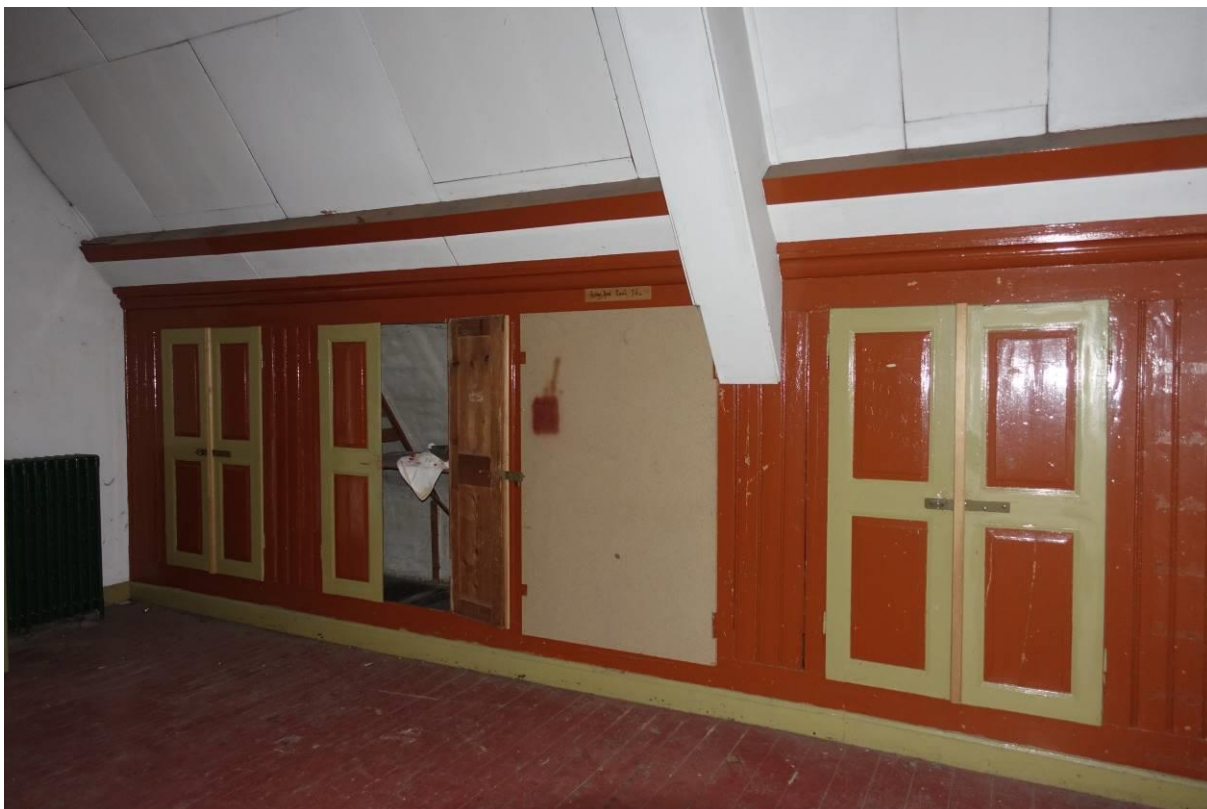
Knieschotten met paneeldeurtjes op de voorzolder van de noordelijke vleugel.
