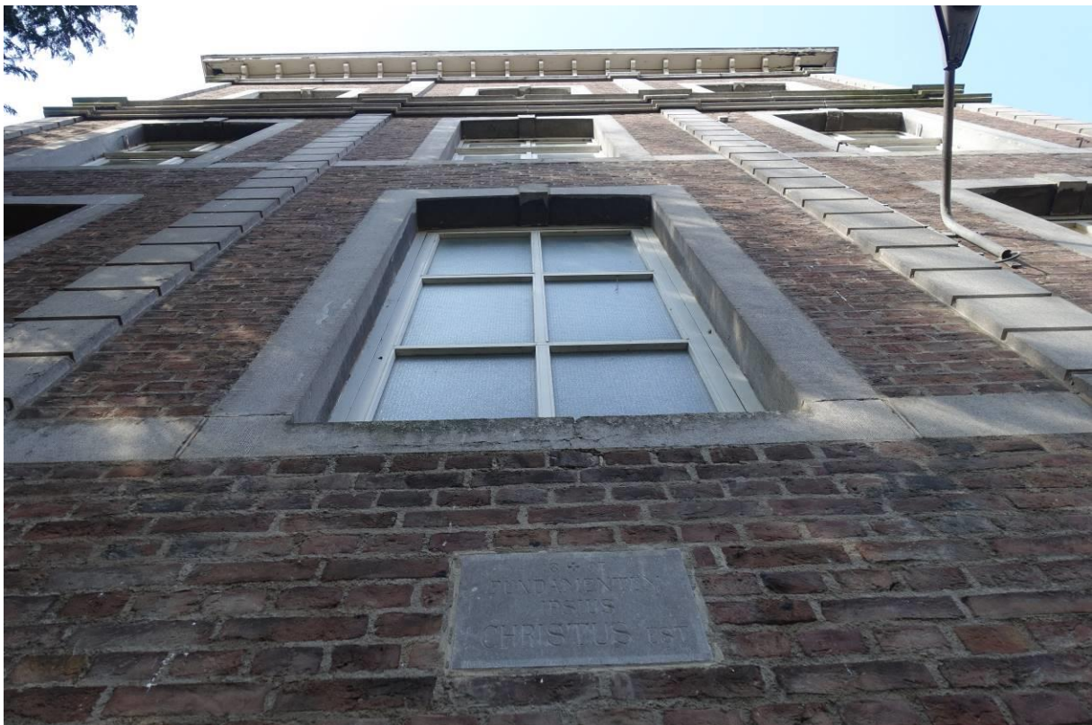
Zicht omhoog langs de oostelijke kopgevel van de zuidelijke vleugel.
