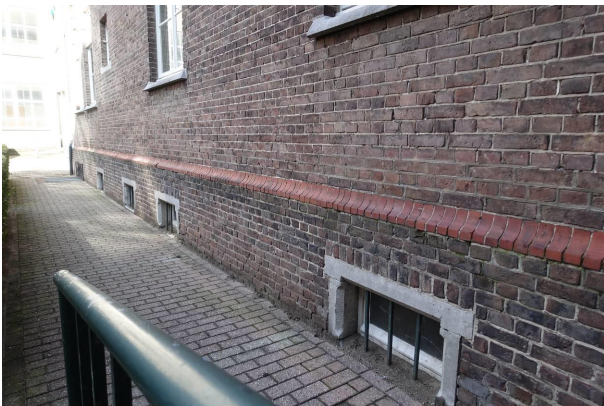
Plint met kelderlichten van de noordelijke vleugel aan de binnenplaats.
