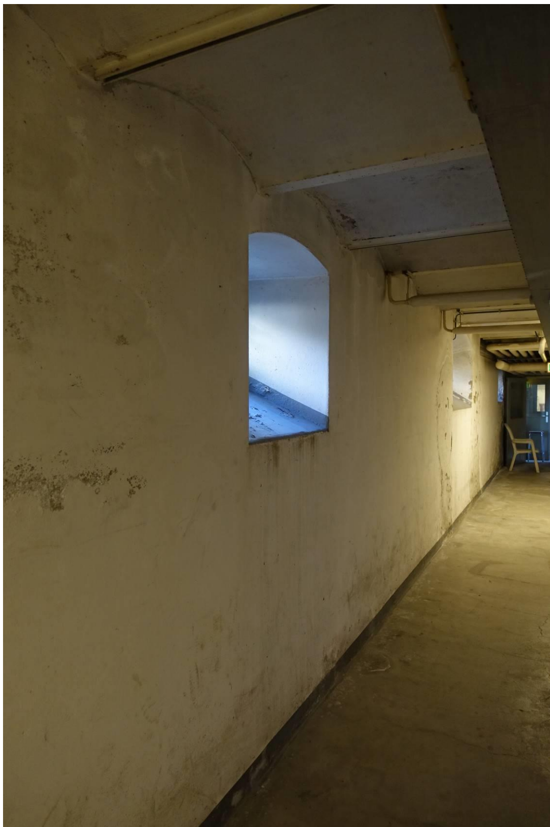
Gang in de kelder van de zuidelijke vleugel naar het oosten gezien.
