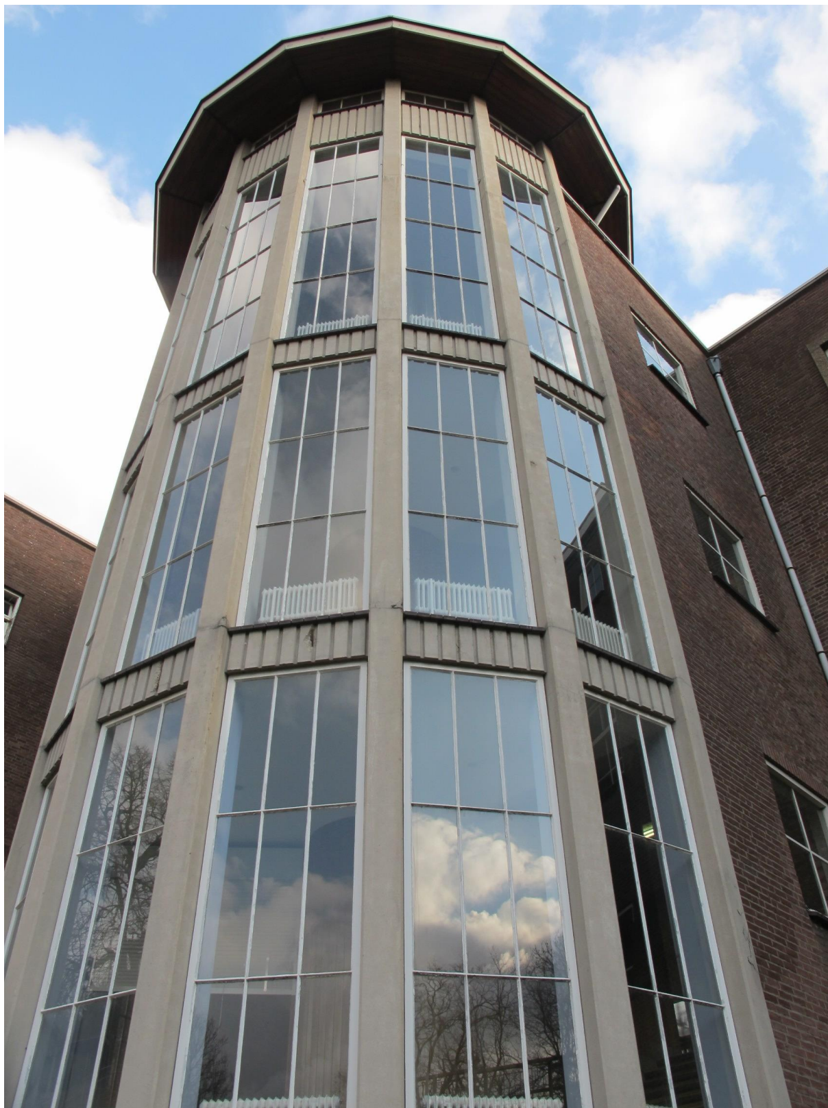
De veelhoekige transparante trappenhuisstoren van 1960.
