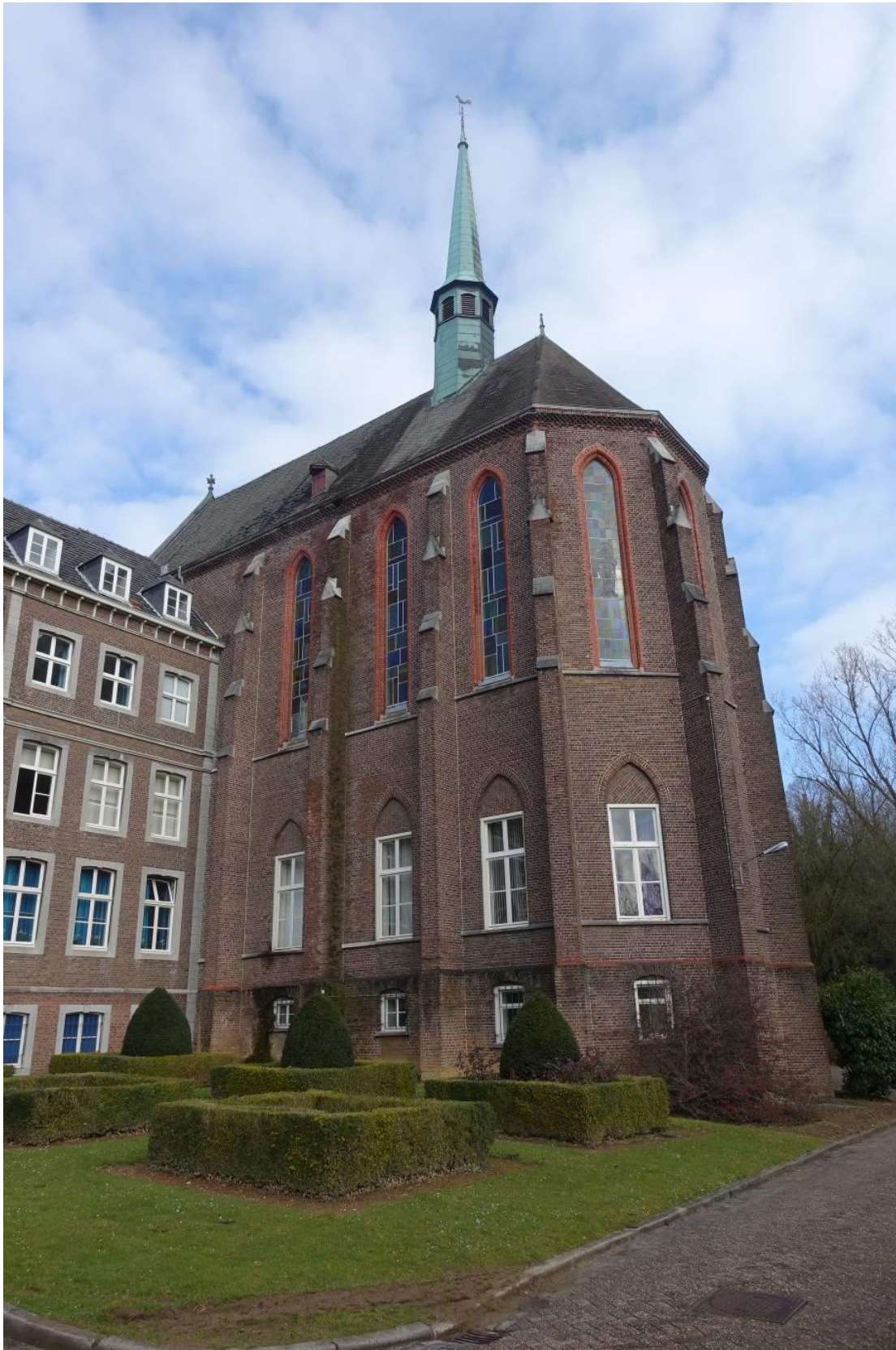
De kapel en aansluitend deel van de centrale vleugel.
