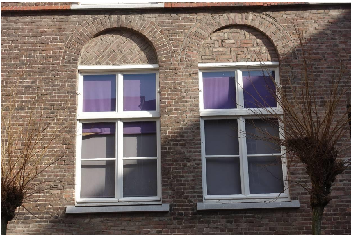
Vensters met boogvelden met siermetselwerk in de zuidgevel van de noordelijke vleugel.
