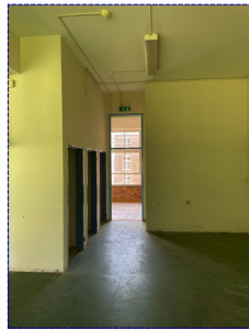
3. Wanden te slopen t.b.v. nieuwe invulling
