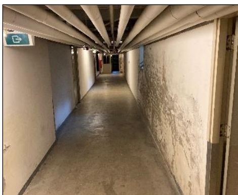
Foto's: beperkingen bij isolatiemogelijkheden bij het kelderplafond en bij de begane grondvloer met de tegels en plinten
