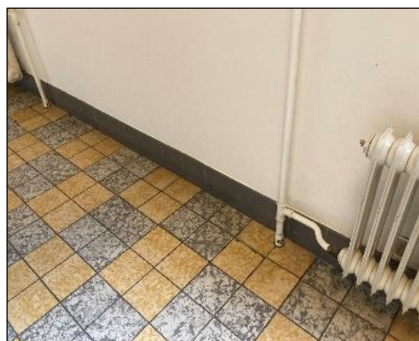
Foto's: beperkingen bij isolatiemogelijkheden bij het kelderplafond en bij de begane grondvloer met de tegels en plinten
