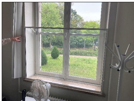
Foto: huidig gedeeltelijk achterzetraam ter voorkoming van tocht, ter plekke van gebouwdeel 1
