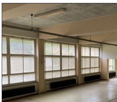
Foto: mogelijkheden plaatsen achterzetgevel gebouwdeel 3
