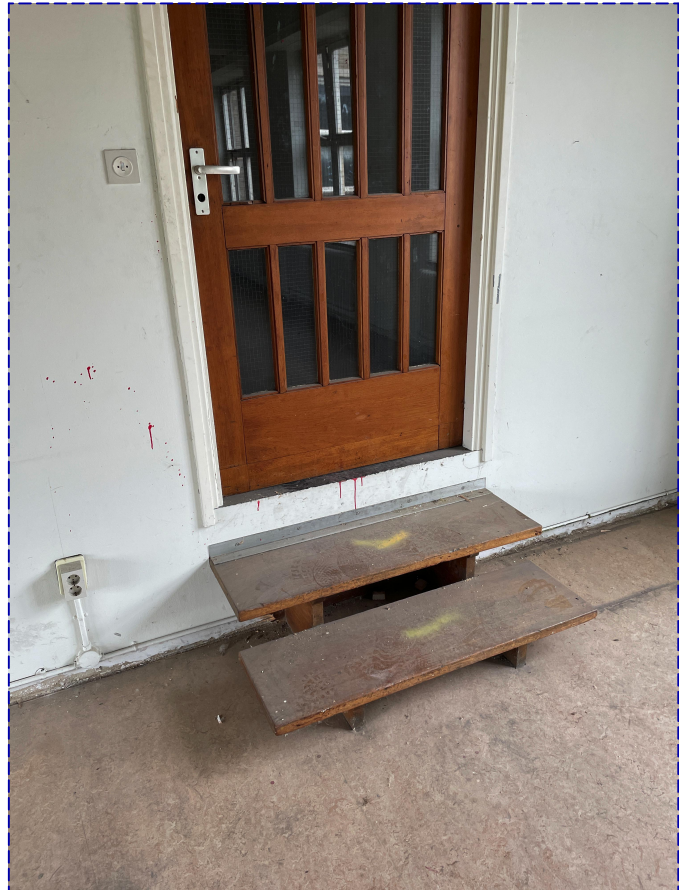
6. trap & deur te verwijderen t.b.v. nieuwe invulling
