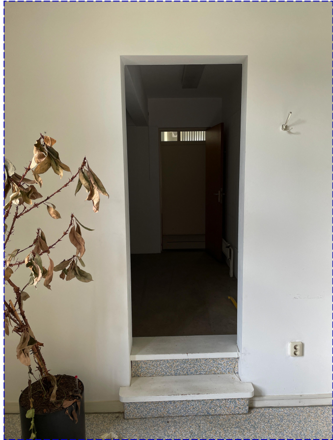
10. Doorgang dicht te zetten t.b.v. herstellen voedselliften
