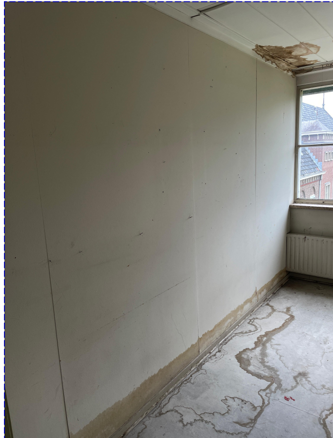
8. Gipswand te verwijderen t.b.v. nieuwe invulling vleugel
