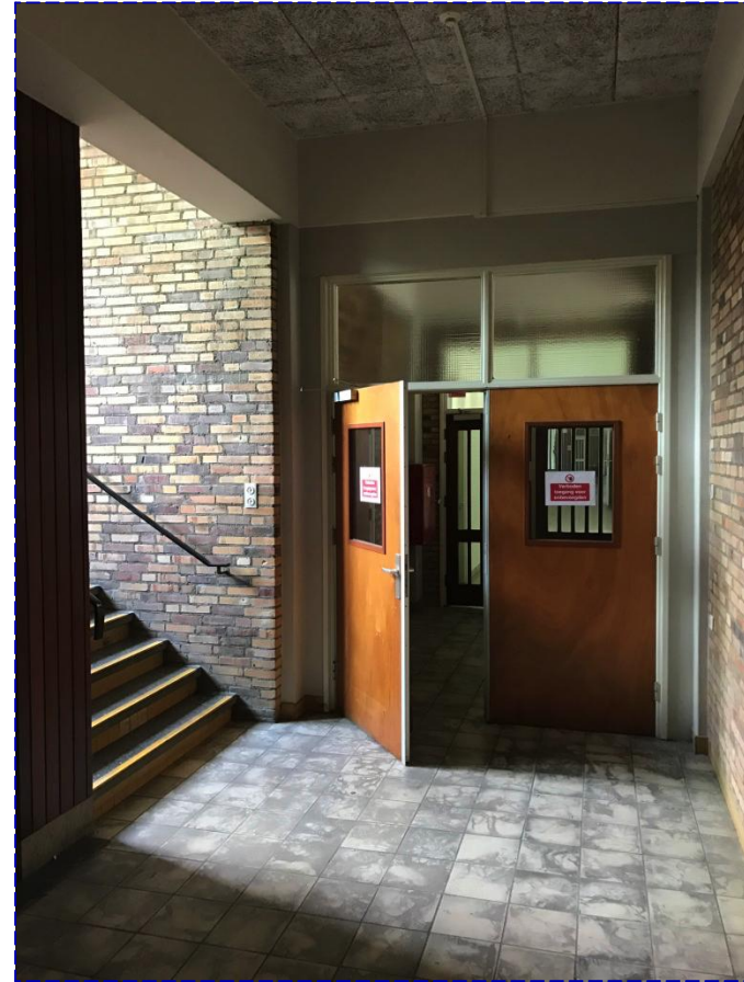
7. Houten omkleding trappenhuis verwijderen
