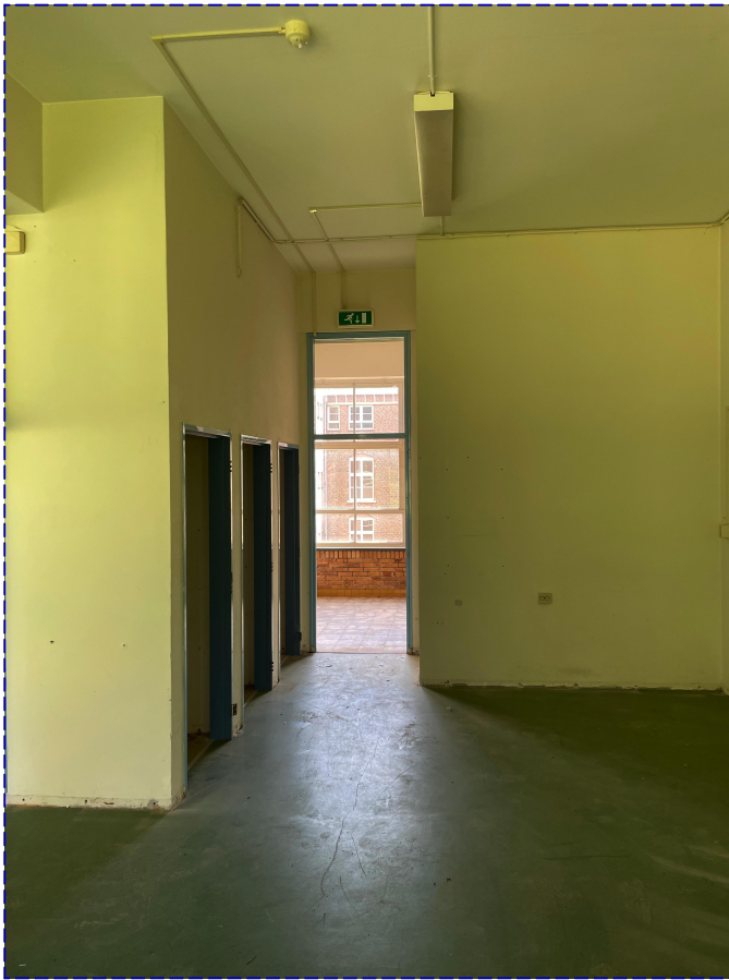
3. Wanden te slopen t.b.v. nieuwe invulling
