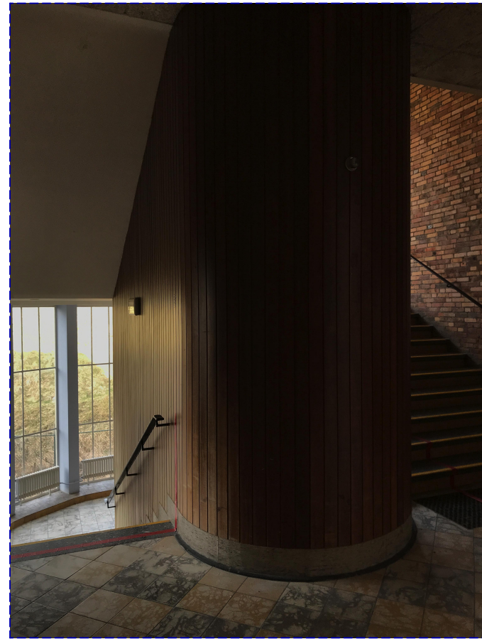
1. Houten omkleding trappenhuis verwijderen
