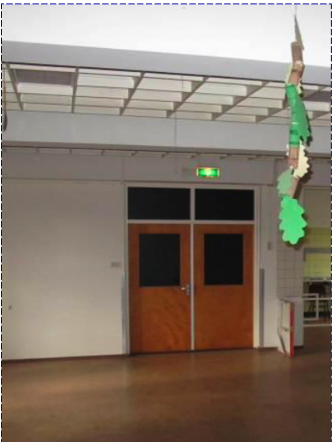
5. Dubbele deur te verwijderen t.b.v. nieuwe invulling.
