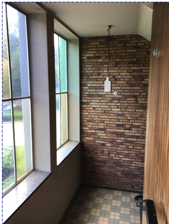
4. Houten inbouw in trappenhuis te verwijderen.
