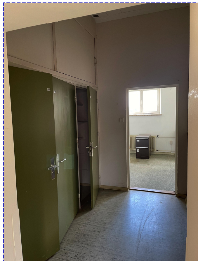
13. Gipswanden te verwijderen t.b.v. nieuwe invulling
