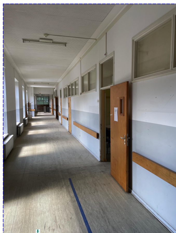
16. Gipswanden te verwijderen t.b.v. nieuwe invulling
