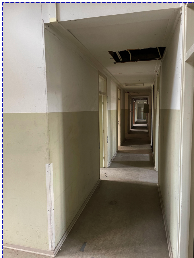
11. Gipswanden te verwijderen t.b.v. nieuwe invulling vleugel
