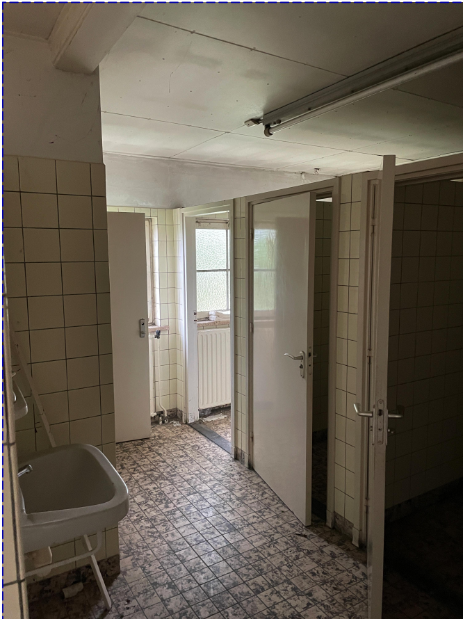
7. Sanitaire ruimte te verwijderen t.b.v. nieuwe invulling
