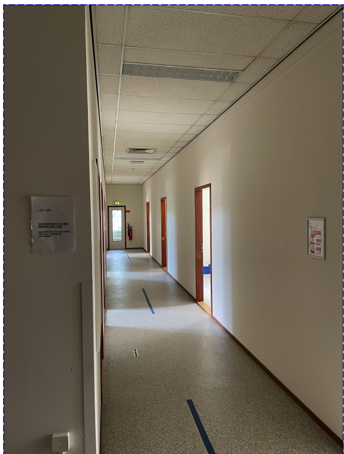
12. Gipswanden te verwijderen t.b.v. nieuwe invulling
