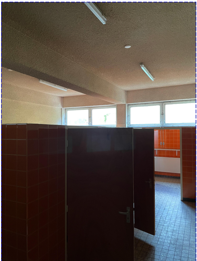
4. Toiletgroep te verwijderen voor t.b.v. nieuwe invulling
