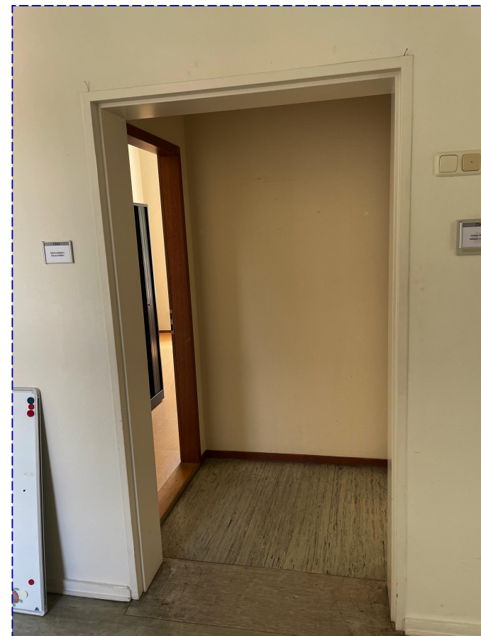
11. Gipswanden te verwijderen t.b.v. nieuwe invulling
