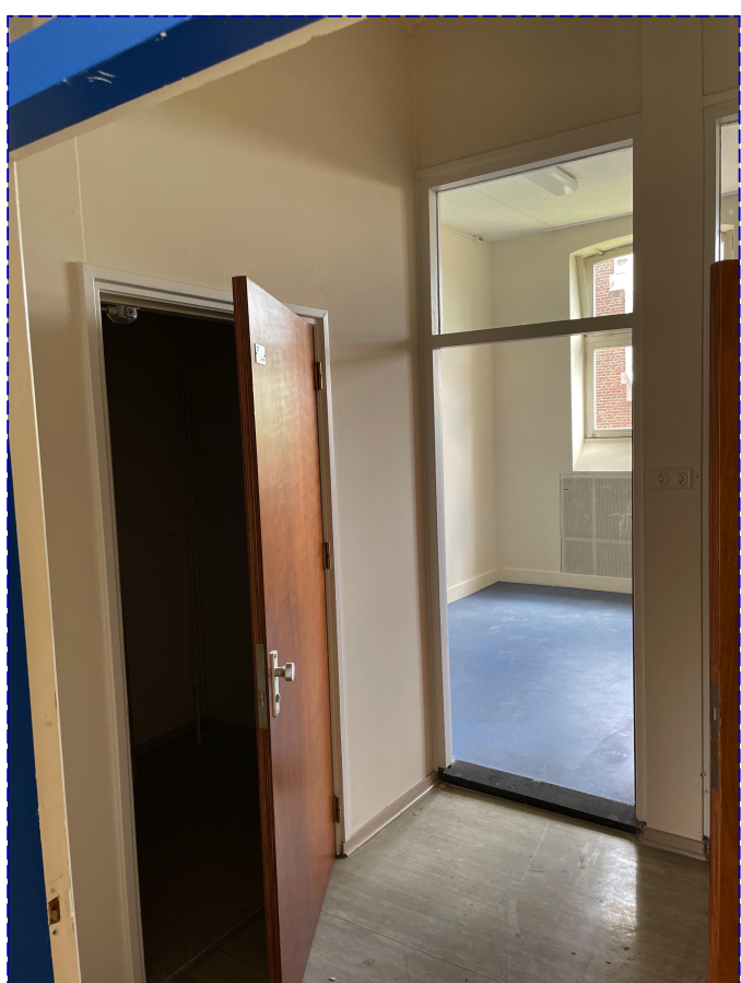
15. Gipswanden te verwijderen t.b.v. nieuwe invulling
