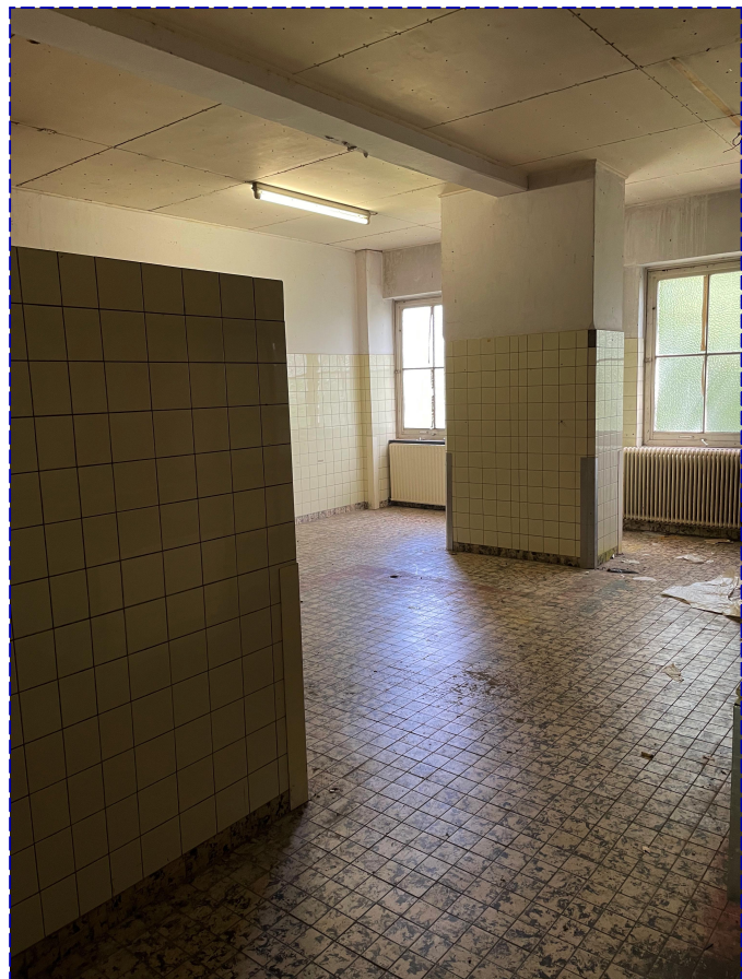
5. Toiletgroep te verwijderen voor t.b.v. nieuwe invulling
