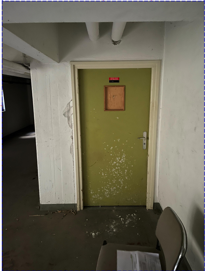
Deur te verwijderen t.b.v. nieuwe invulling
