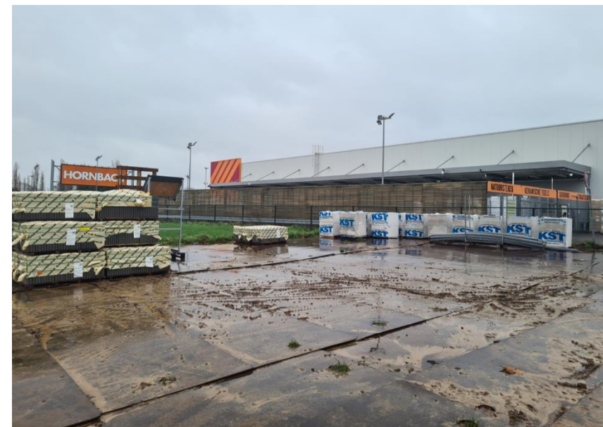
Figuur 9: Materiaal opslag gelegen in de noordwestelijke hoek van het perceel
