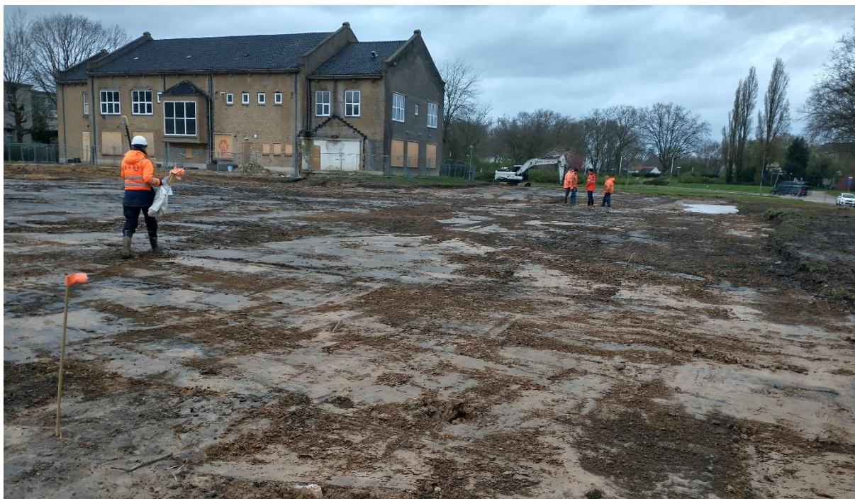
Figuur 15. Impressie gebied Mauritspark (oostelijk deel), alvorens het aanleggen van de proefsleuven, waarbij goed te zien is dat de bovenlaag is afgegraven. Foto genomen vanuit het ZO.
