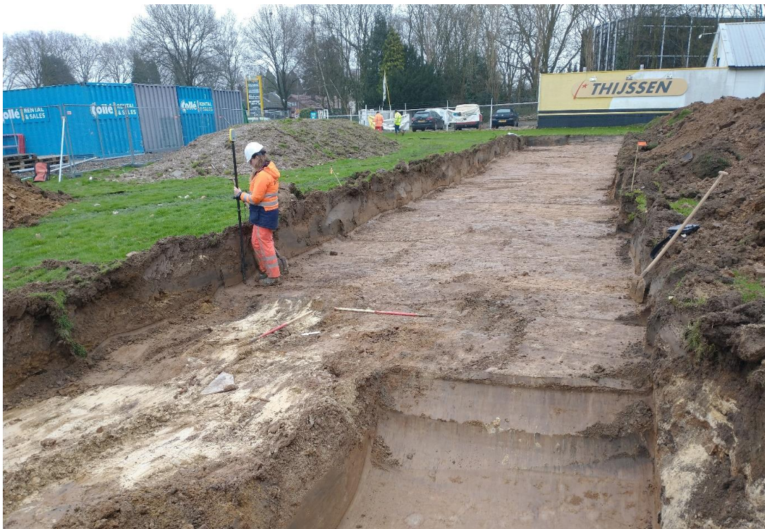
Figuur 7. Impressie WP 3 ter plaatse van een grasveld, en het inmeten van de putrand met een GPS. Op de voorgrond een recente verstoring (S9999; gebied VIDAR). Foto genomen vanuit het NW.
