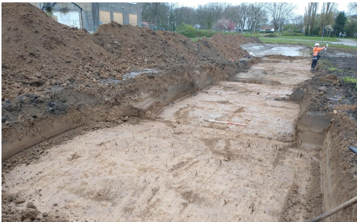
Figuur 16. Impressie gebied Mauritspark (oostelijk deel), tijdens de aanleg van WP 20. Deze sleuf diende verplaatst te worden vanwege de aanwezigheid van water ter plaatse van het oppervlak (te zien op de achtergrond). Foto genomen vanuit het ZO.
