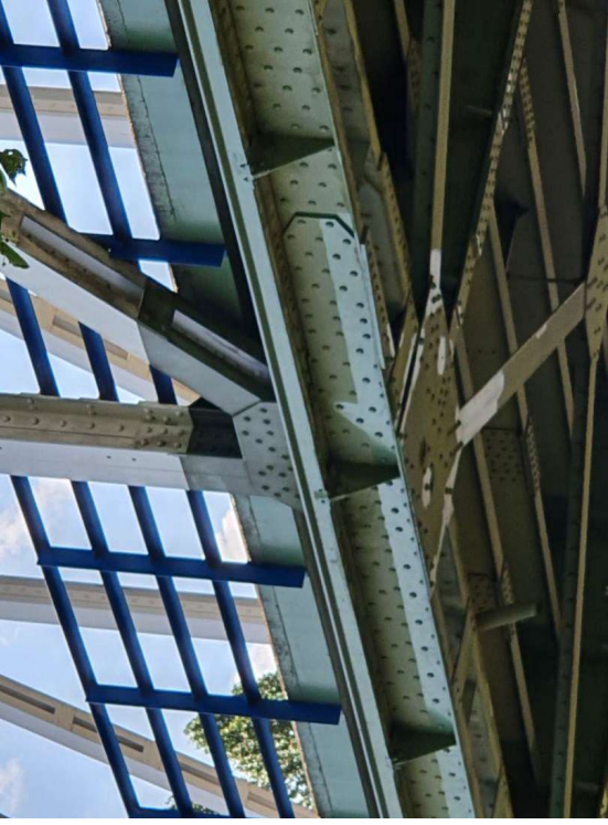
Detail van hoofdligger met een na de oorlog bij herstel aangebrachte plaat aan de noordzijde van de brug vanaf de westoever. Op de ligger is de rails van de verfwagen op consoles geplaatst. FH MAB 2021
