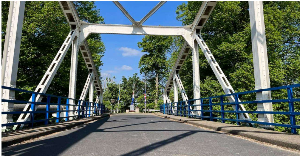
Brug Obbicht gezien vanaf het wegdek in westelijke richting met links de gastransportleiding
