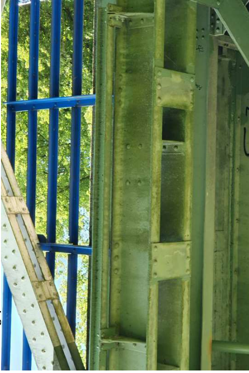
Detail van hoofdligger met een na de oorlog bij herstel aangebrachte plaat aan de noordzijde van de brug vanaf de westoever. Op de ligger is de rails van de verfwagen op consoles geplaatst. FH MAB 2021
