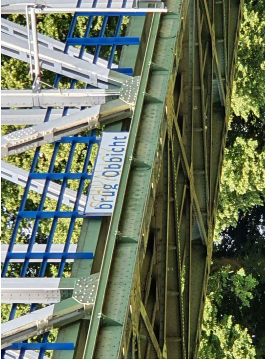
Balustrade en plaat met naam van de brug aan de noordzijde. FH MAB 2021
