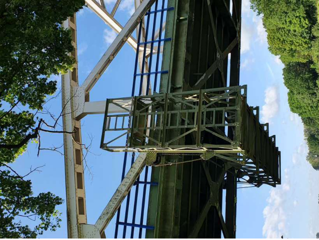
De brug en de verfwagen vanuit het noorden. FH MAB 2021
