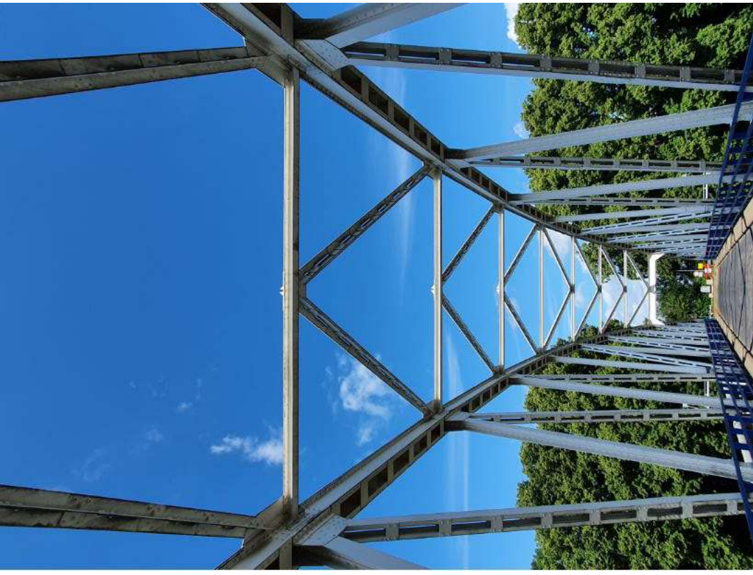
Zicht over de brug met bovenwindverband in K-patroon. FH MAB 2021
