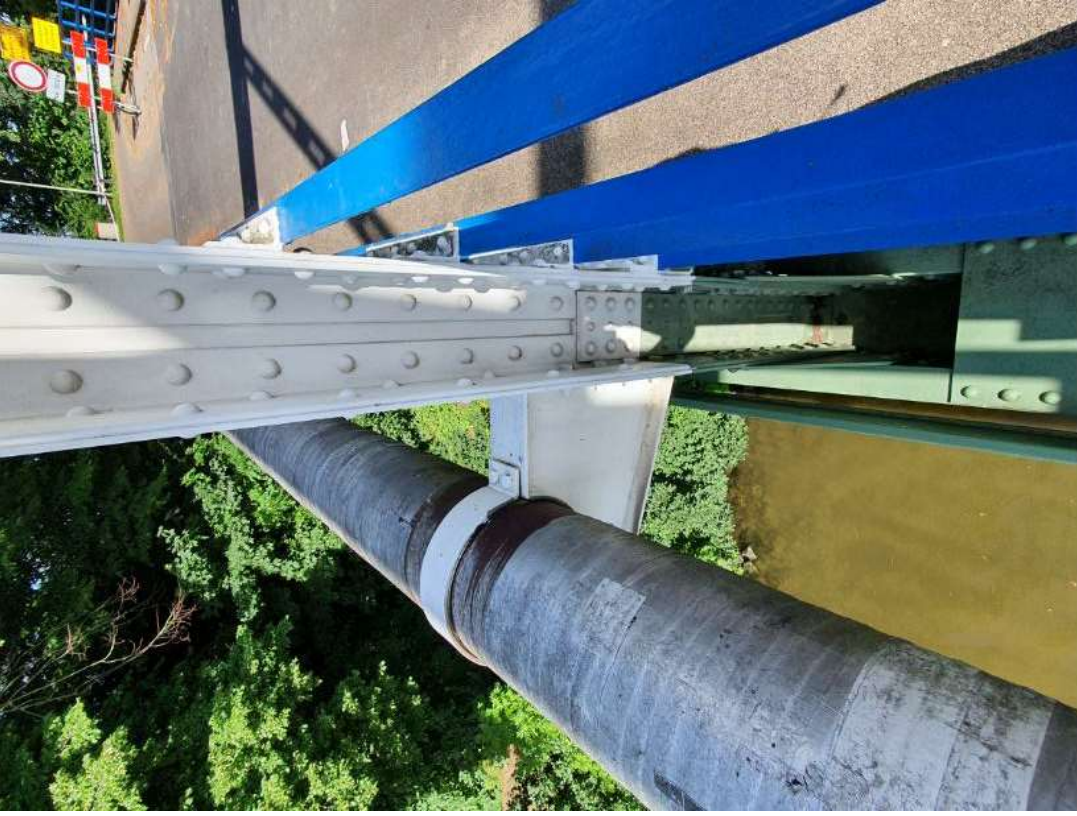
Detail van de constructie van de gastransportleiding aan de zuidzijde van de brug. FH MAB 2021
