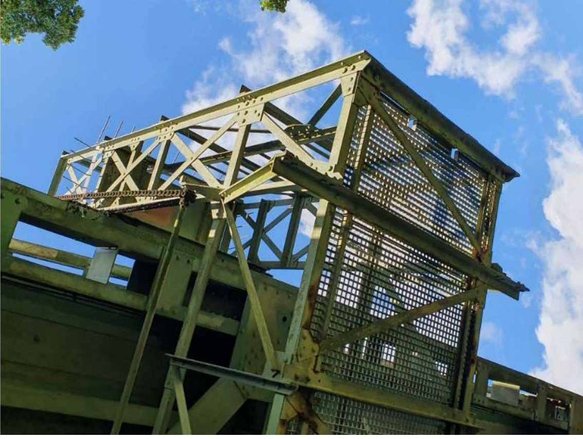
De onderzijde van de verfwagen met bordes en trap aan de noordzijde. FH MAB 2021
