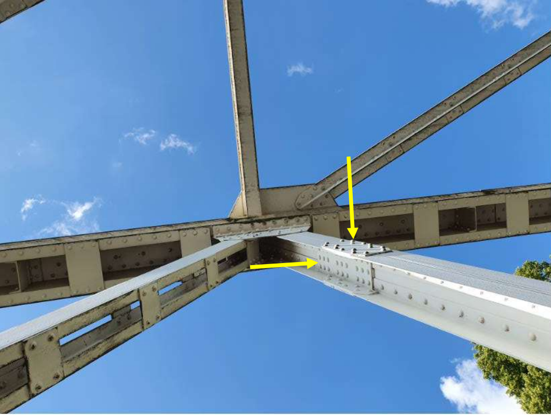
De stijl aan de zuidzijde die na de oorlog is hersteld met stuikeplaten (gele pijlen). FH MAB 2021
