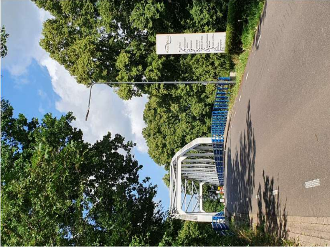
De brug vanuit de oostelijke oprit gezien. FH MAB 2021
