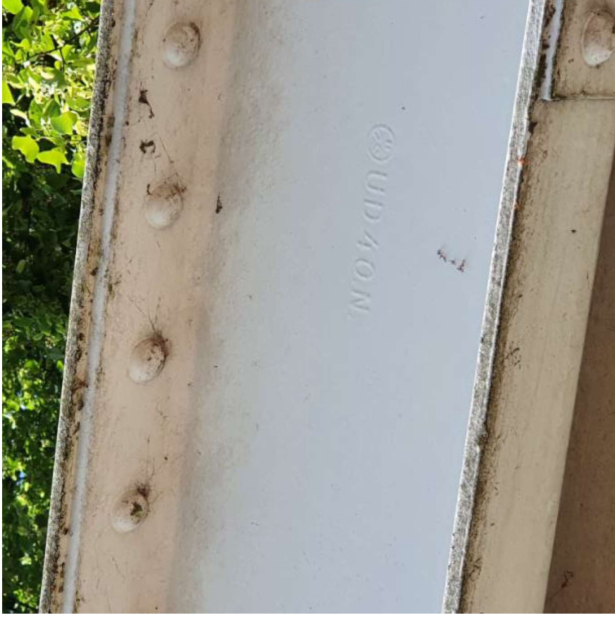
Opschrift van met logo en afkorting UD van de Dortmund-Union op een 40N profiel aan de binnenzijde de boog van de brug Obbicht. FH MAB 2021
