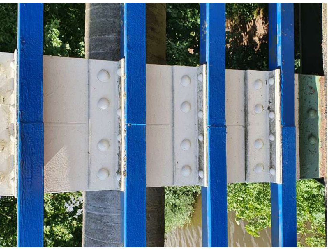
De verbinding van de balustrade op een verticale stijl aan de zuidzijde. FH MAB 2021
