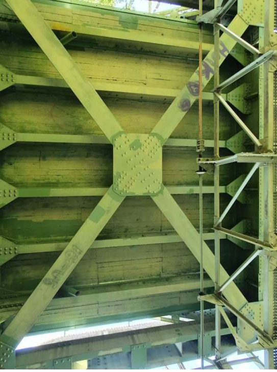
De onderzijde van de brug met dekconstructie, onderwindverband en balustrade van de verfwagen. FH MAB 2021
