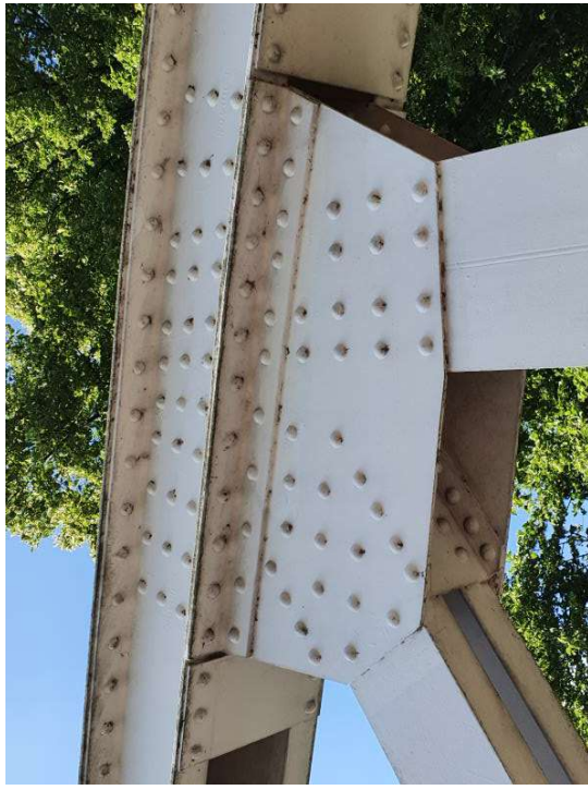
Verbinding tussen stij, diagonaal en boog aan zuidzijde. FH MAB 2021
