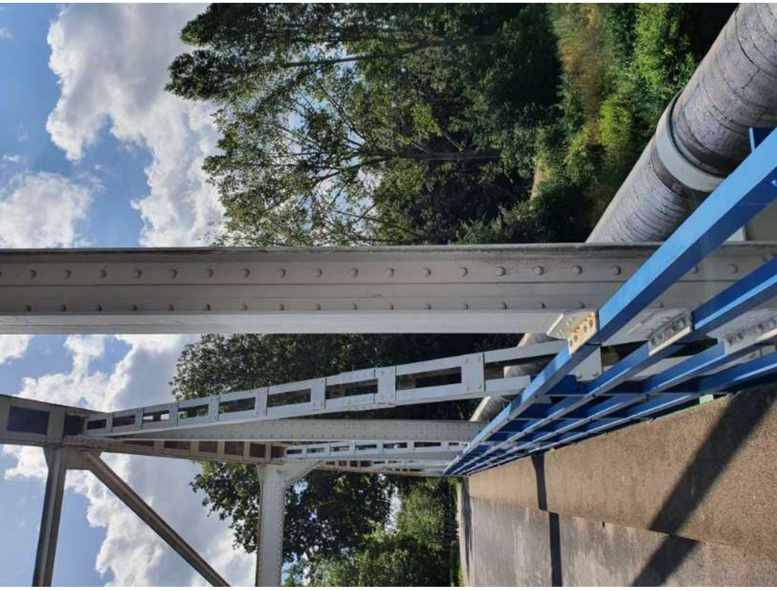
De stijlen en diagonalen aan de zuidzijde naar het oosten gezien. FH MAB 2021
