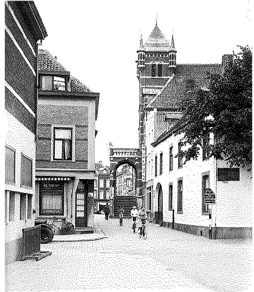
Doorkijkje vanuit de Rosmolenstraat richting Markt, met rechts de stadsboerderij Beaujean en het stadhuis, in 1934 (EHC_gp_209).
