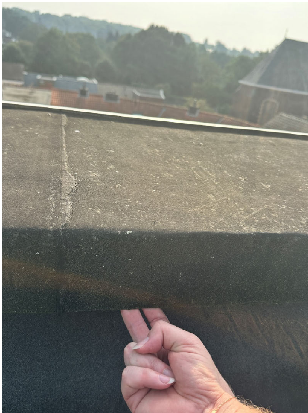
• Afbeelding 23: Onderzijde dakrand
