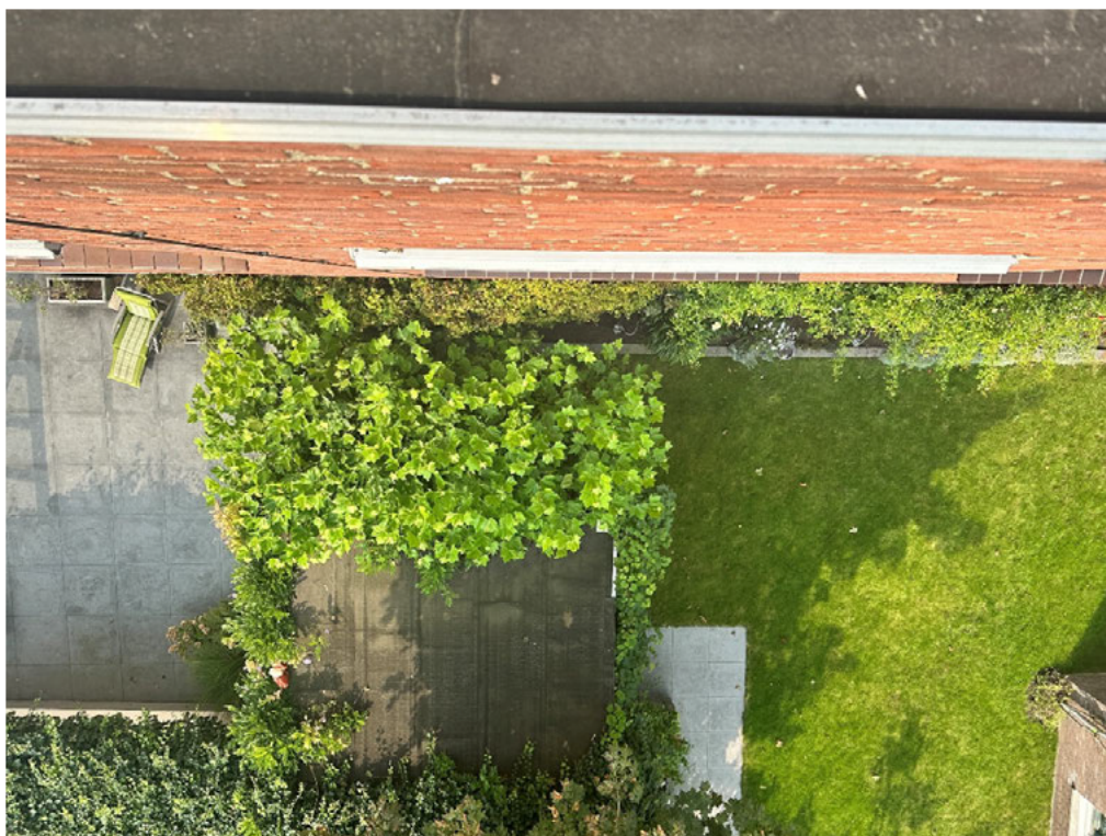
• Afbeelding 24: Metselwerk gevel grenzend aan naastgelegen tuinen
