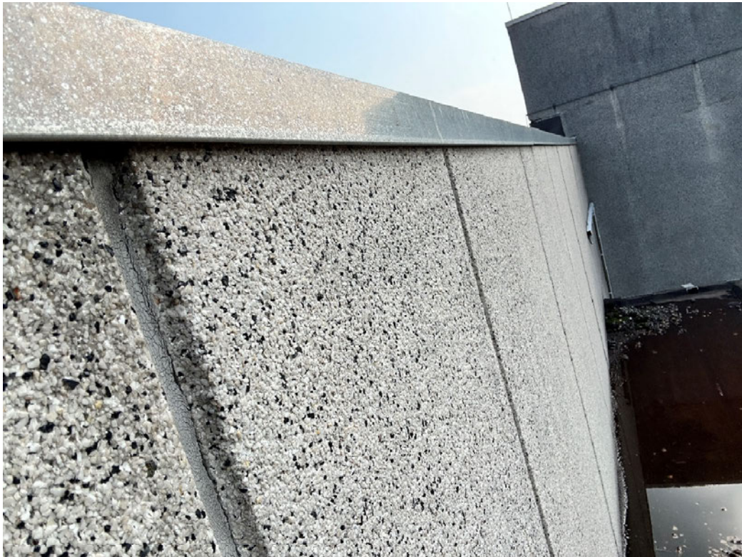
• Afbeelding 26: Dakrand, aluminium daktrim
