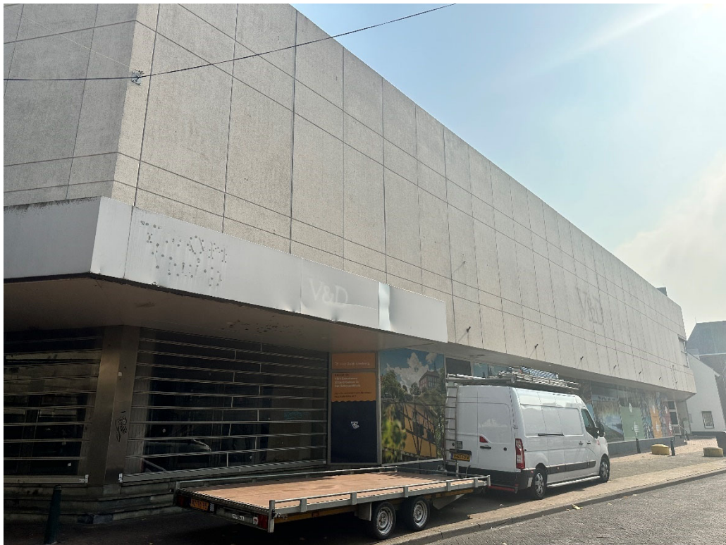
• Afbeelding 4: Gevel van het te verbouwen gebouw aan de Plakstraat
