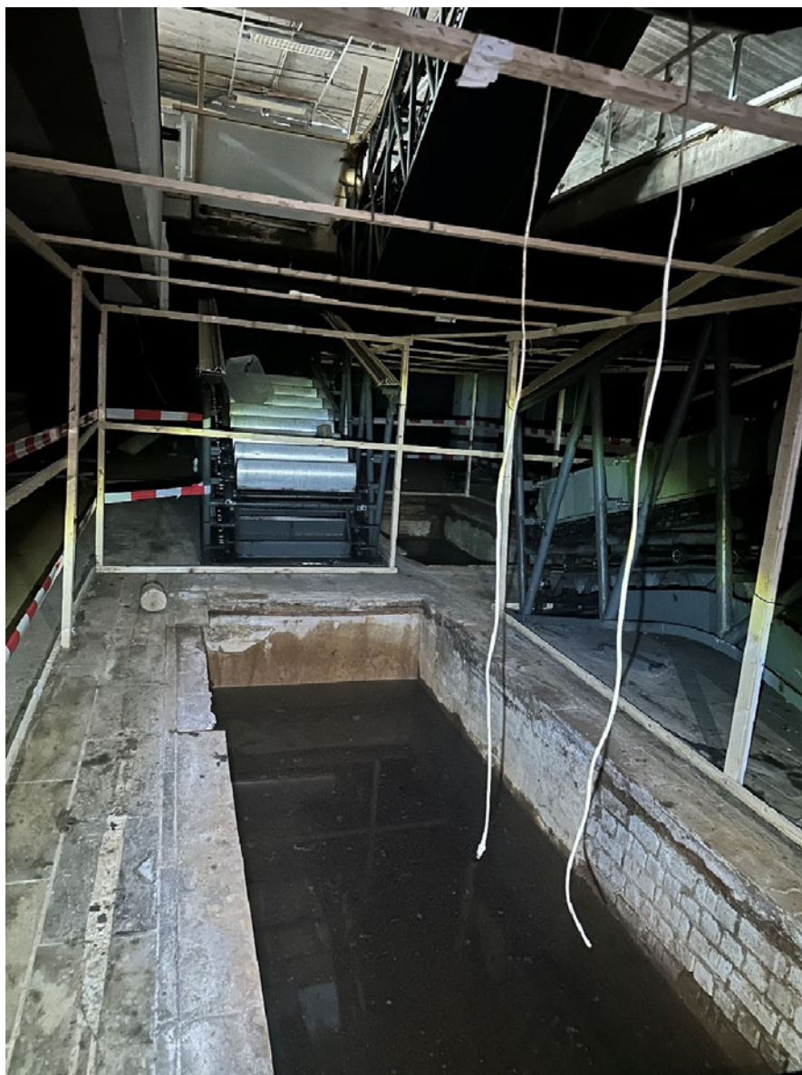
• Afbeelding 14: Bak van de roltrappen, vol water
