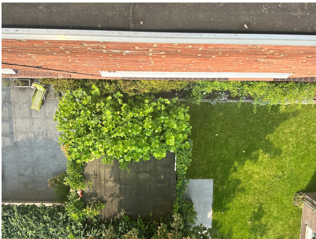
• Afbeelding 24: Metselwerk gevel grenzend aan naastgelegen tuinen
