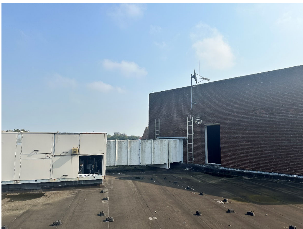
• Afbeelding 17: Opbouw op het dak met daarin de mechanische ventilatie
