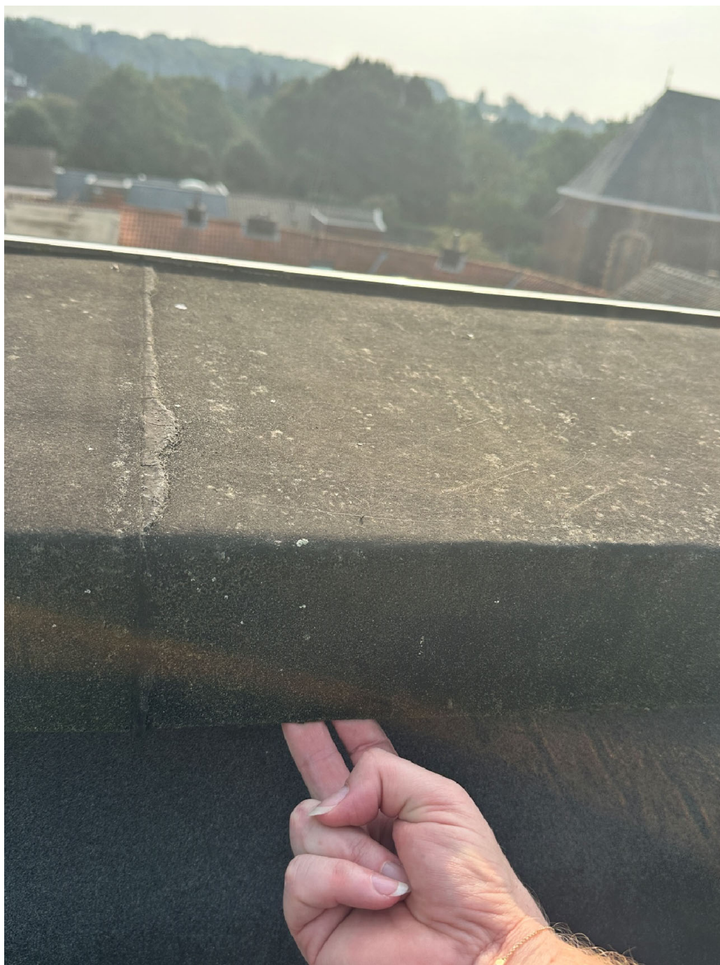
• Afbeelding 23: Onderzijde dakrand
