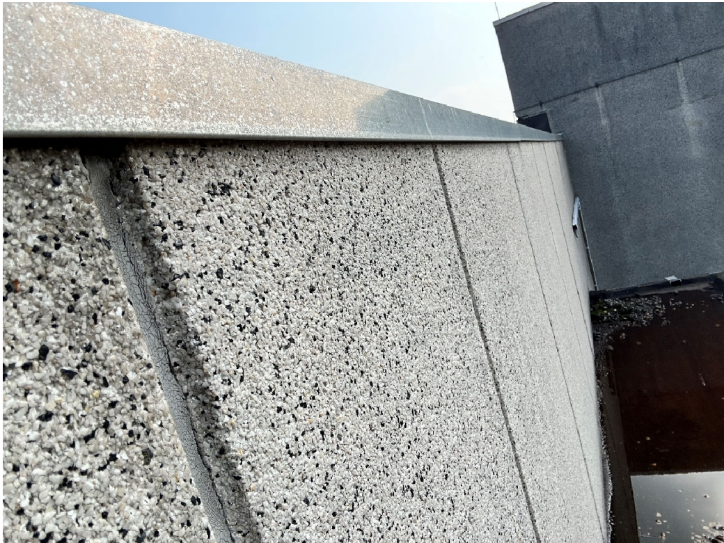
• Afbeelding 26: Dakrand, aluminium daktrim
