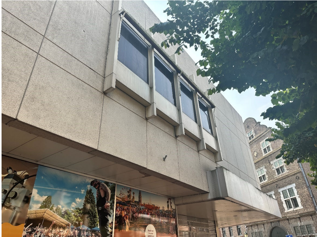
• Afbeelding 5: Fragment gevel aan de Markt
