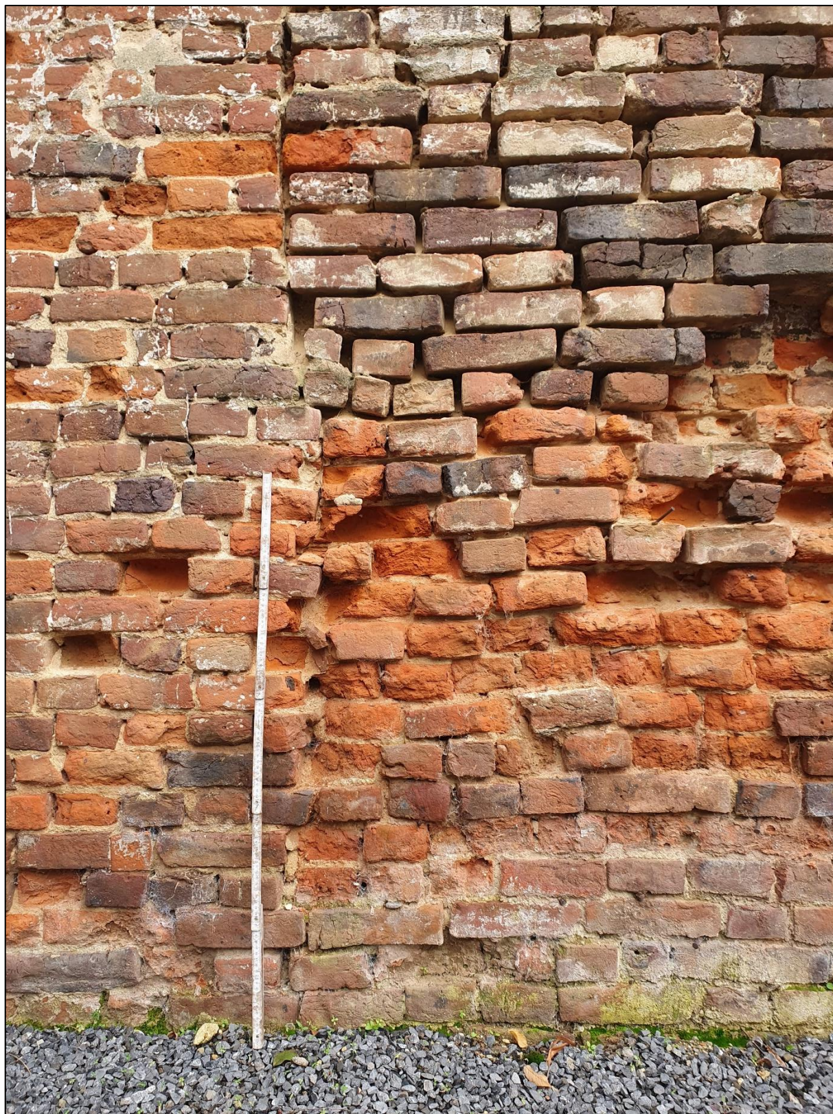
Figuur 24: Gefaseerd ontstaan opgaand muurwerk in veldbrandstenen op de zuidgrens van het perceel met de bebouwing van huisnummer 22 (oktober 2024).
