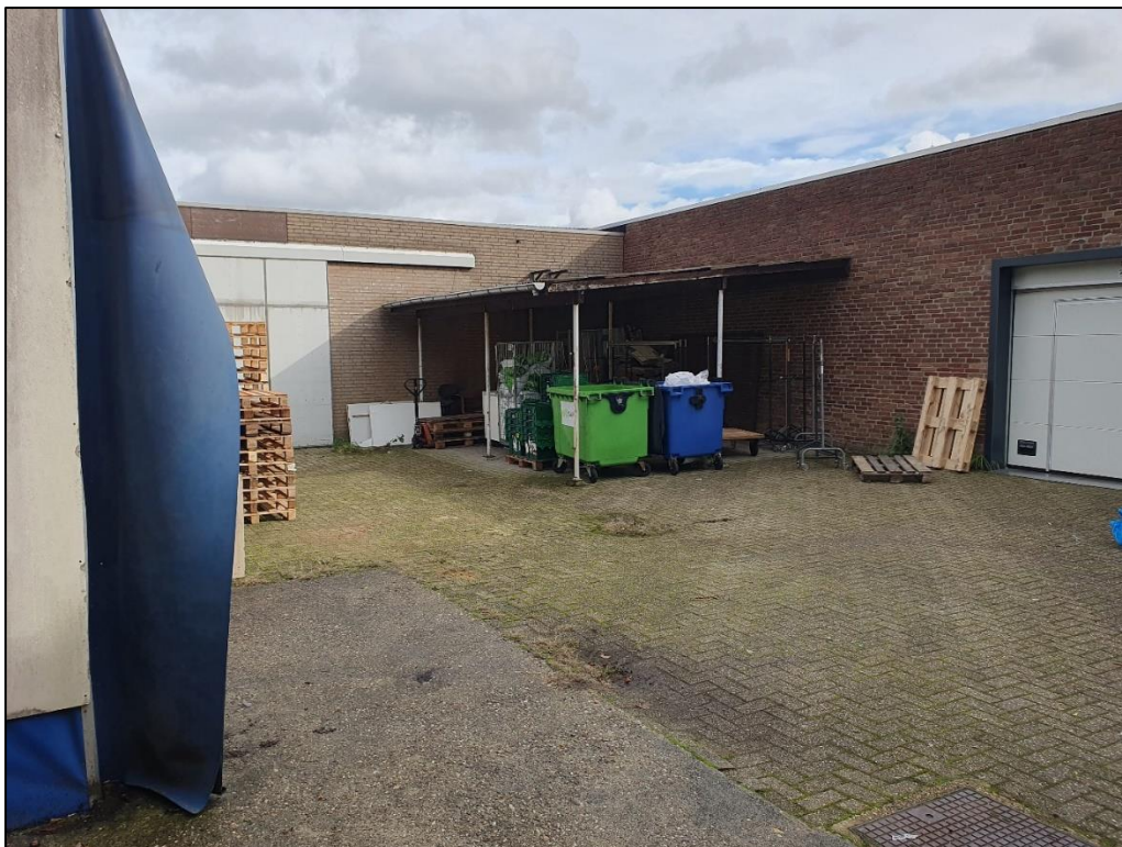
Figuur 17: Het centrale deel van het plangebied achter de bebouwing van huisnummer 18. Op de plaats van de klinkerverharding is boring 2 gezet. De foto is gemaakt in noordoostelijke richting (oktober 2024).
