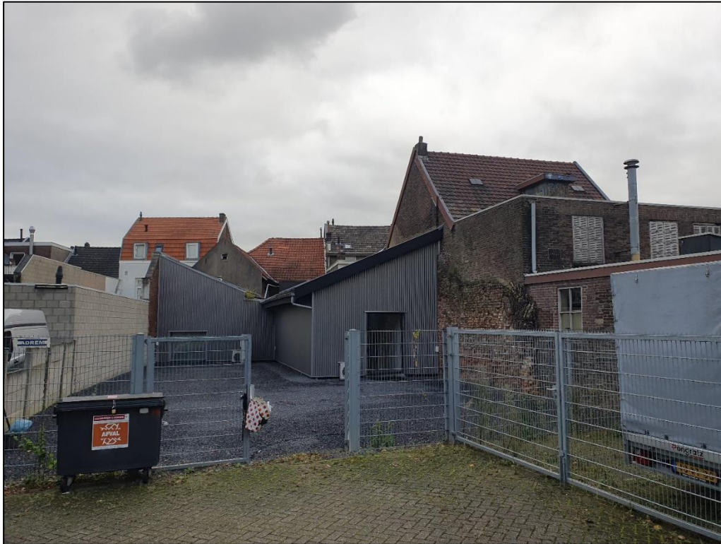
Figuur 16: Het met grijze split verharde achtererf van huisnummer 22 (noordwestelijk deel plangebied). Hier zijn de boringen 1a-c gezet. Aan weerszijden van de moderne grijze uitbreiding zijn resten van oud muurwerk te zien. Die liggen op de noordelijke en zuidelijke perceelsgrens. Achter de open deur ligt een trap naar een op het niveau van de Steenweg gelegen winkelvloer (niet zichtbaar). De rode daken op de achtergrond zijn van de bebouwing binnen het plangebied dat direct aan de Steenweg ligt (oktober 2024).
