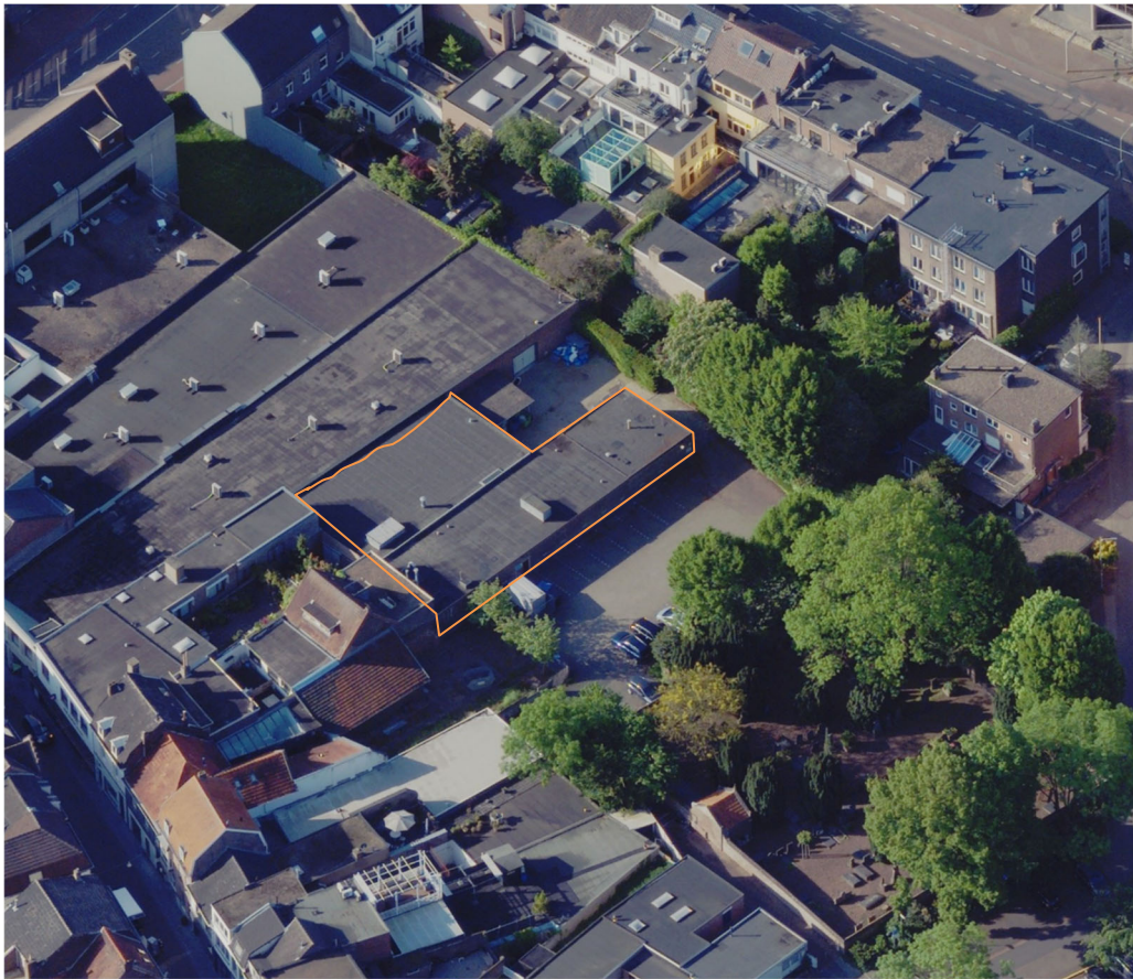
• Afbeelding 28: Te slopen bebouwing langs parkeerplaats Steenweg
