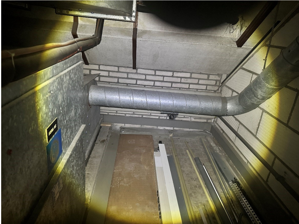
• Afbeelding 13: Onderzijde dak van bouwdeel boven de winkel, dit wordt gesloopt tbv de bouw van nieuwe bovenwoningen
