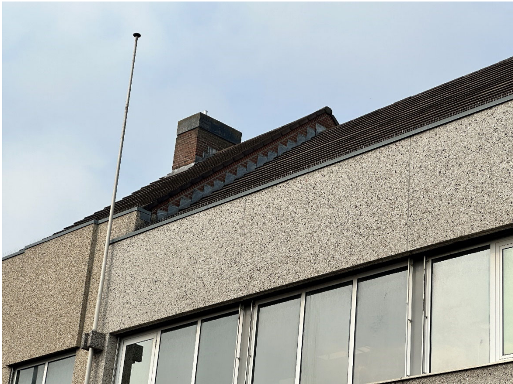
• Afbeelding 11: Te slopen bovengevel, linker bouwdeel wordt volledig gesloopt
