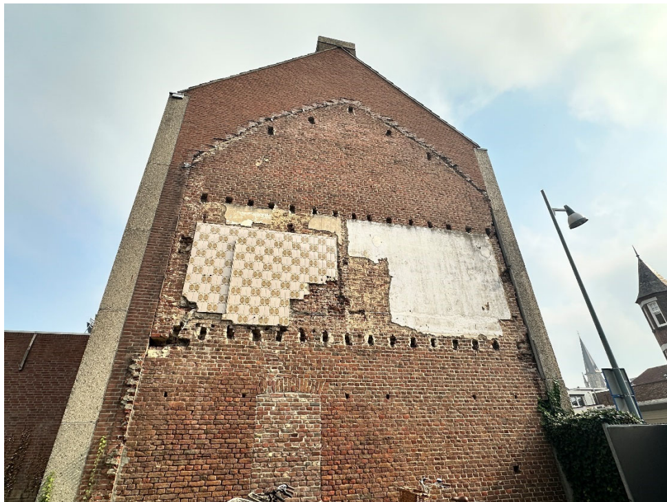
• Afbeelding 4: Zijgevel aan de Rijksweg Zuid, dit bouwdeel wordt gesloopt
