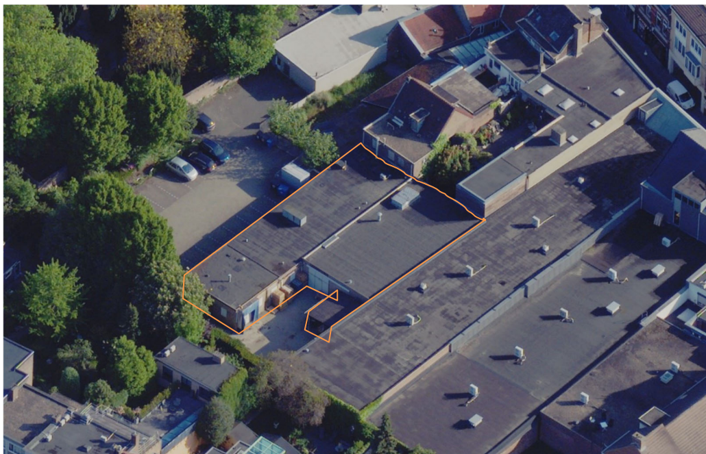
• Afbeelding 29: Te slopen bebouwing langs parkeerplaats Steenweg
