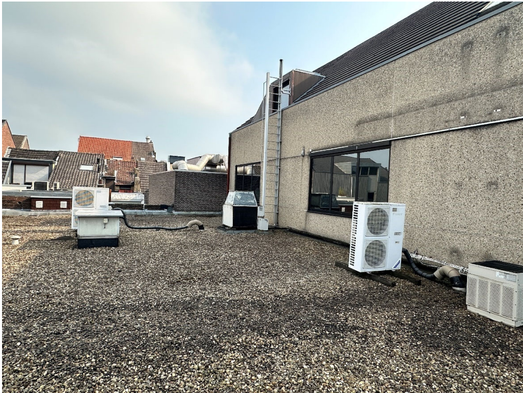
• Afbeelding 15: Achterzijde te slopen bovenbouw
