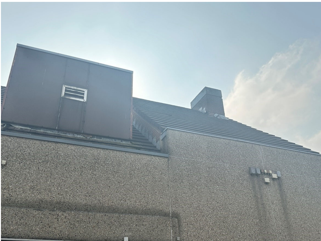
• Afbeelding 14: Achterzijde te slopen bouwdeel en bovenbouw
