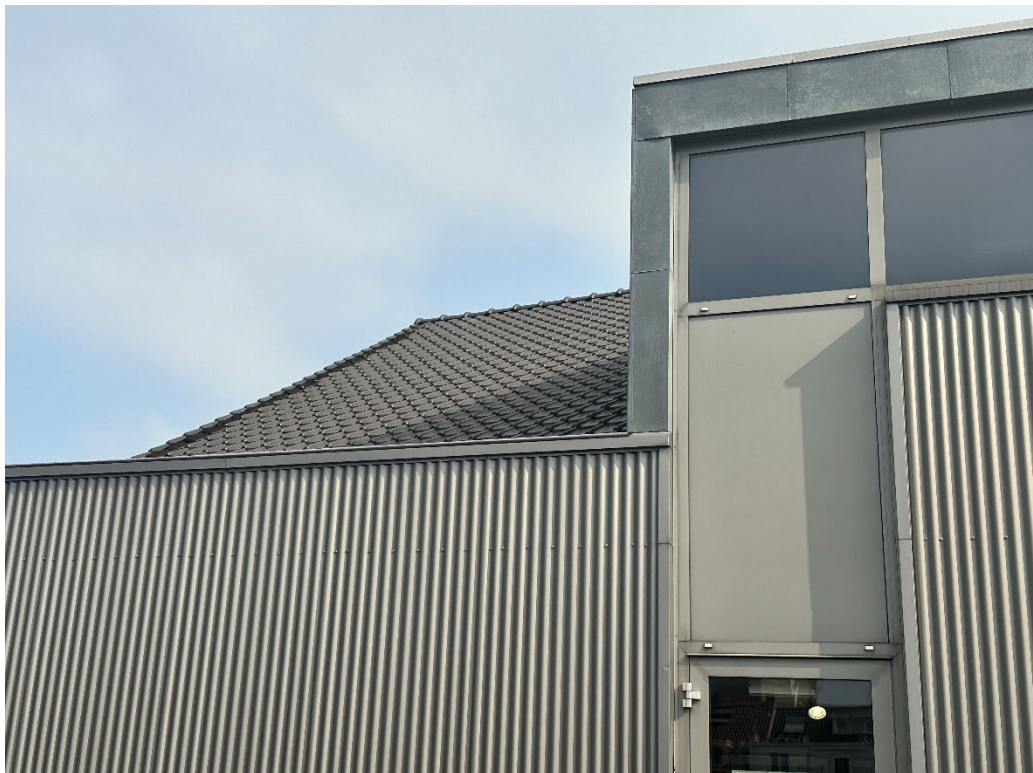
• Afbeelding 22: Achterzijde dak van de winkel aan de Steenweg, deze wordt inpandig verbouwd tot appartementen
