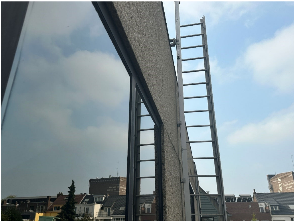
• Afbeelding 16: Detail achterzijde te slopen bovenbouw
