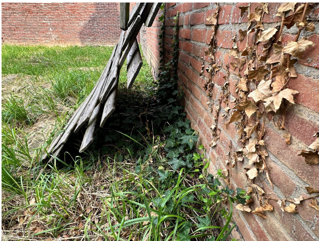
• Afbeelding 7: Opslag op braagliggend terrein
