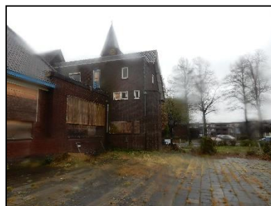
Figuur 7. Schoolplein en oude basisschool (vanuit het westen gezien).
