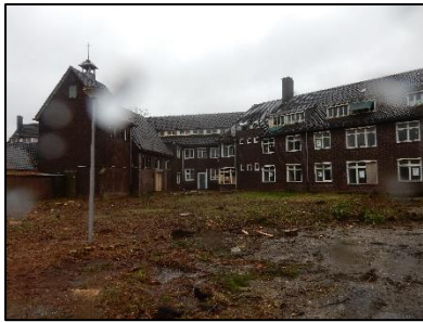
Figuur 9. Binnenplaats en achteraan- zicht klooster (vanuit het westen ge- zien).
