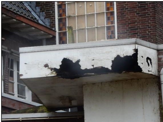
Figuur 17. Kapotte boeiboorden waar vleermuizen door naar binnen kunnen.
