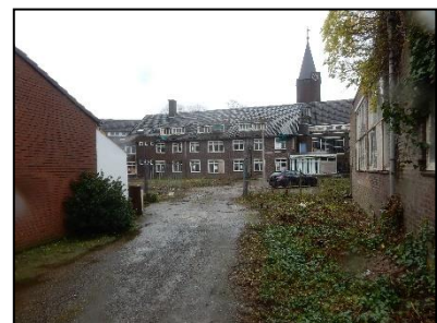
Figuur 8. Binnenplaats en achteraan- zicht klooster (vanuit het westen ge- zien).
