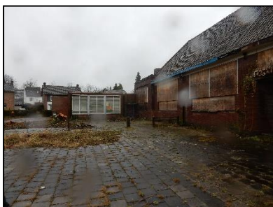
Figuur 6. Schoolplein en oude basisschool (vanuit het oosten gezien).
