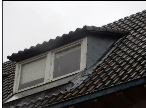
Figuur 14. Dakpannen op dakkapel die geschikt zijn om in te vliegen voor gierzwaluw.
