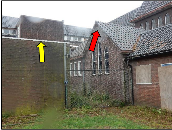
Figuur 15. Rode pijl: ruimte voor vleermuis onder randpannen. Gele pijl: daklijst waar vleermuizen onder kunnen kruipen.
