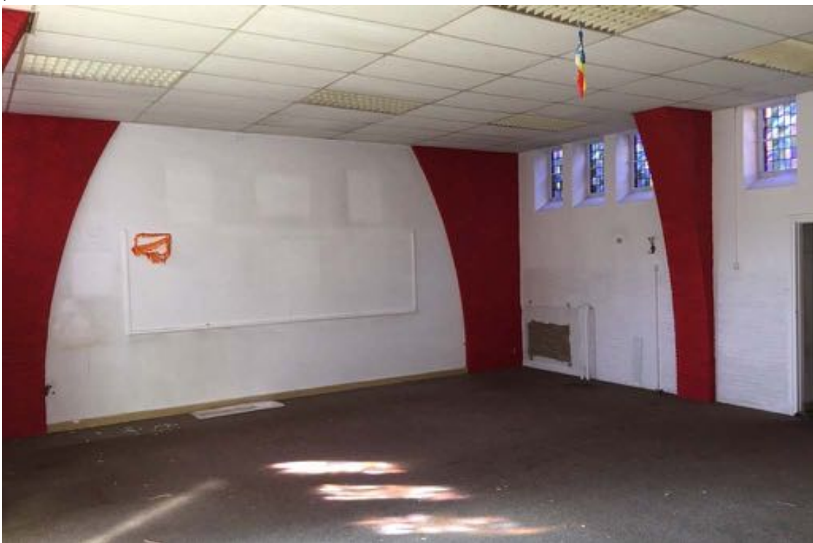
70. Het schip van de kapel. De boog tussen schip en koor is met plaatmateriaal dichtgezet. Boven het systeemplafond is nog het oorspronkelijke gepleisterde gewelf aanwezig.
