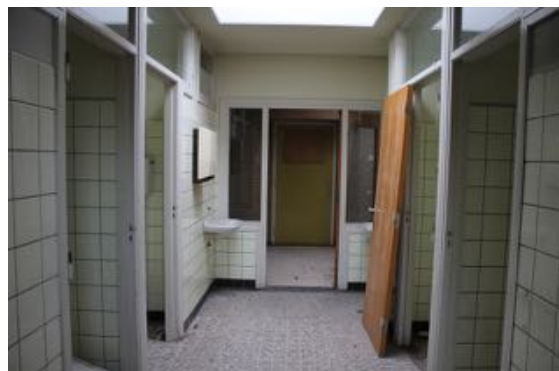
57. De toiletgroep in de aanbouw uit 1973. Dit deel van het schoolgebouw heeft geen monumentale waarde.
