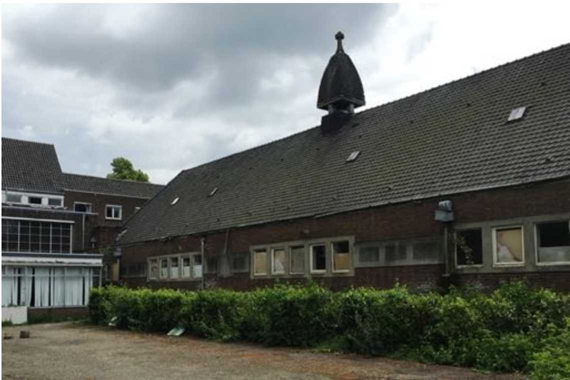
38. De achtergevel (noordzijde) van de school. De foto is genomen in 2015, voordat de ramen werden dichtgezet
