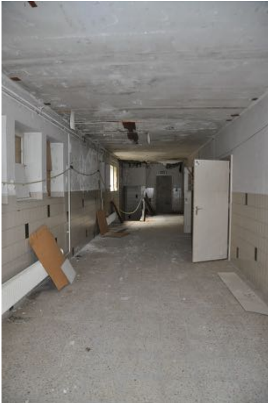
52. De brede gang van de school; Voor 1973 was de gang smaller omdat hier toiletten aanwezig waren.
