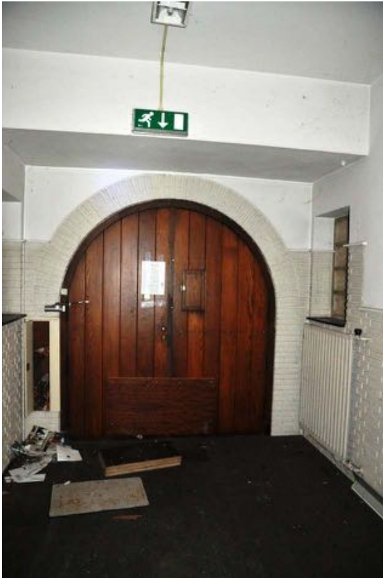
68. Het entreeportaal van het klooster. De geglazuurde bakstenen lambrisering is hier geschilderd met latex.
