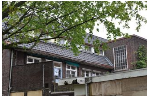
47. De achtergevel van het klooster met het stalen raam van het trappenhuis. Achter het klooster is een uit 1984 daterende inferieure éénlaagse aanbouw aanwezig.
