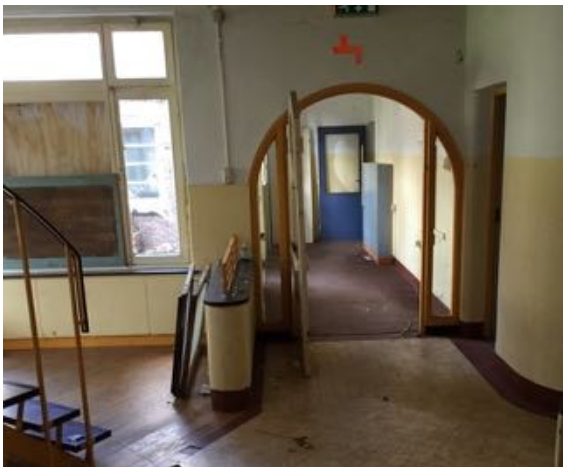
66. De afscheidingen tussen de hal en gangen zijn voorzien van een (nog oorspronkelijk) en deuren met halfronde bovenzijde. Boven het restant van het “zitje” met parketvloer t.p.v. de doorgang naar het klooster..
