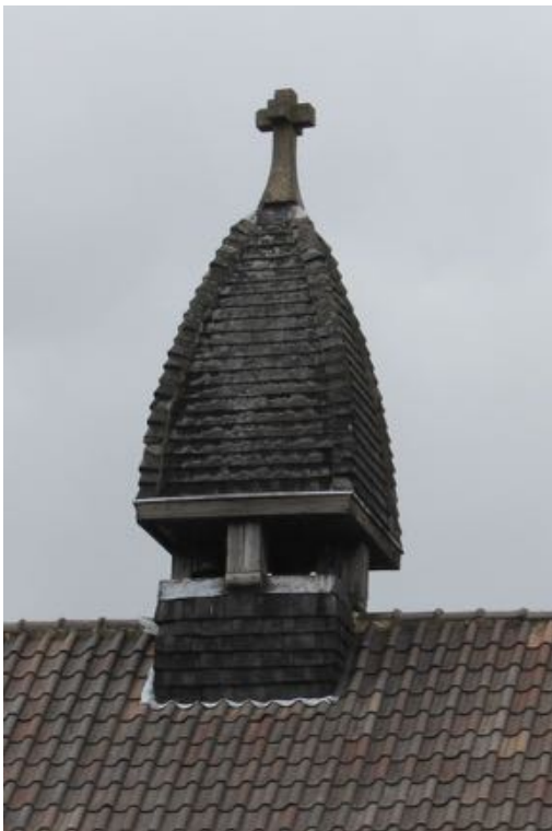
39. Detailopname van de lantaarn op het dak, met keramische leien en kunststenen nokkruis
