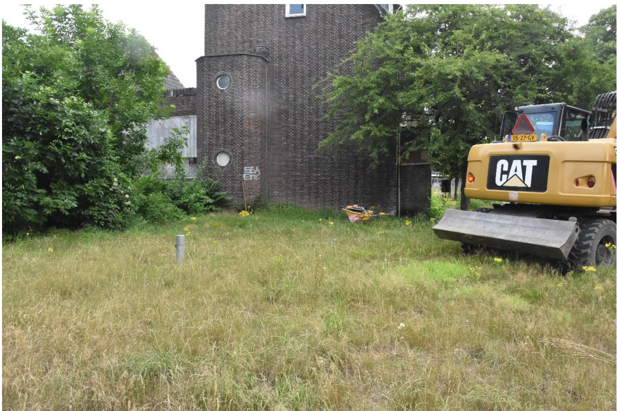
Fig. 4.1. Sittard-Geldersestraat 24. Impressie van het plangebied ter hoogte van werkput 3.
