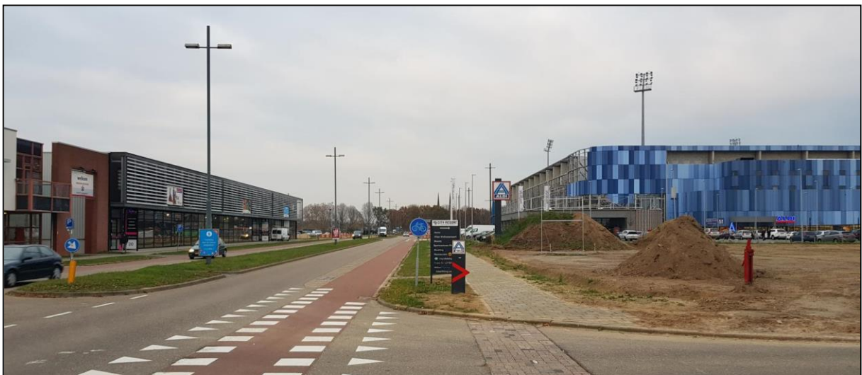
Zicht op de Lissabonlaan, met aan de rechterzijde het deel van het besluitgebied waar de supermarkt voorzien is.
