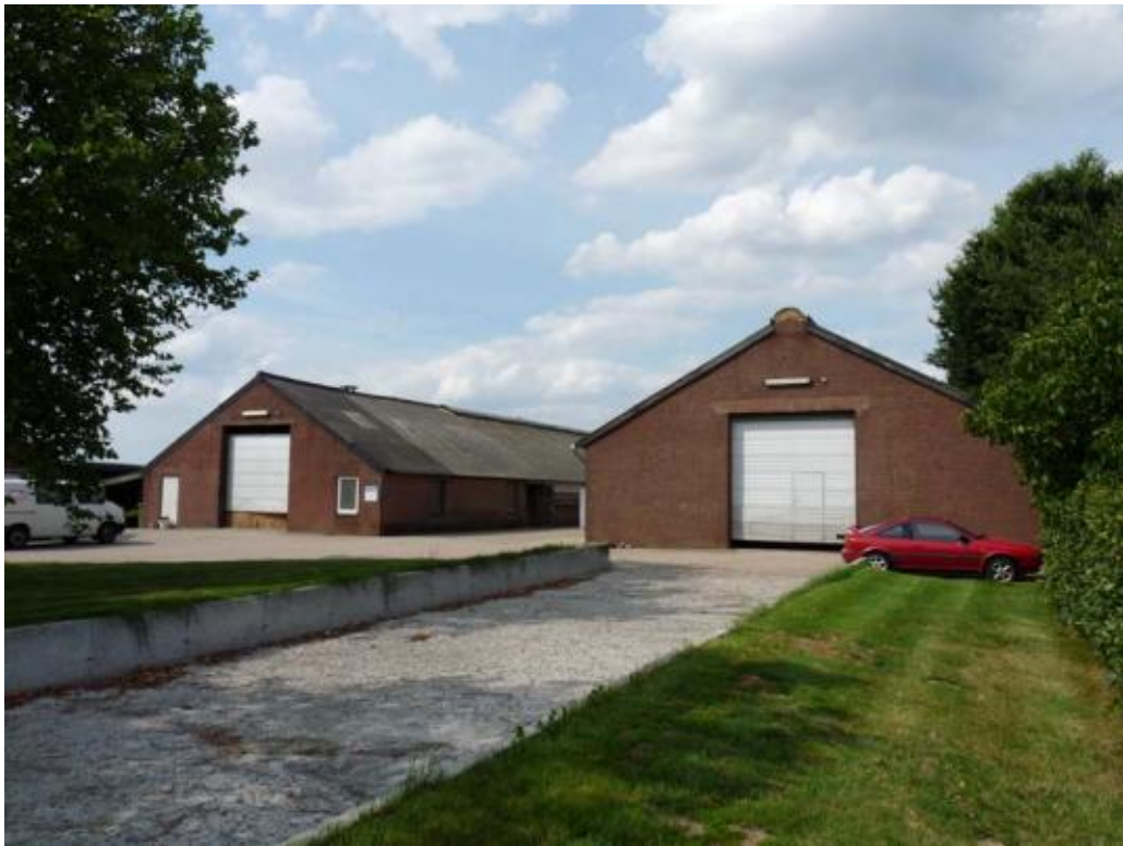
Foto 1. Vooraanzicht te slopen koeienstallen
