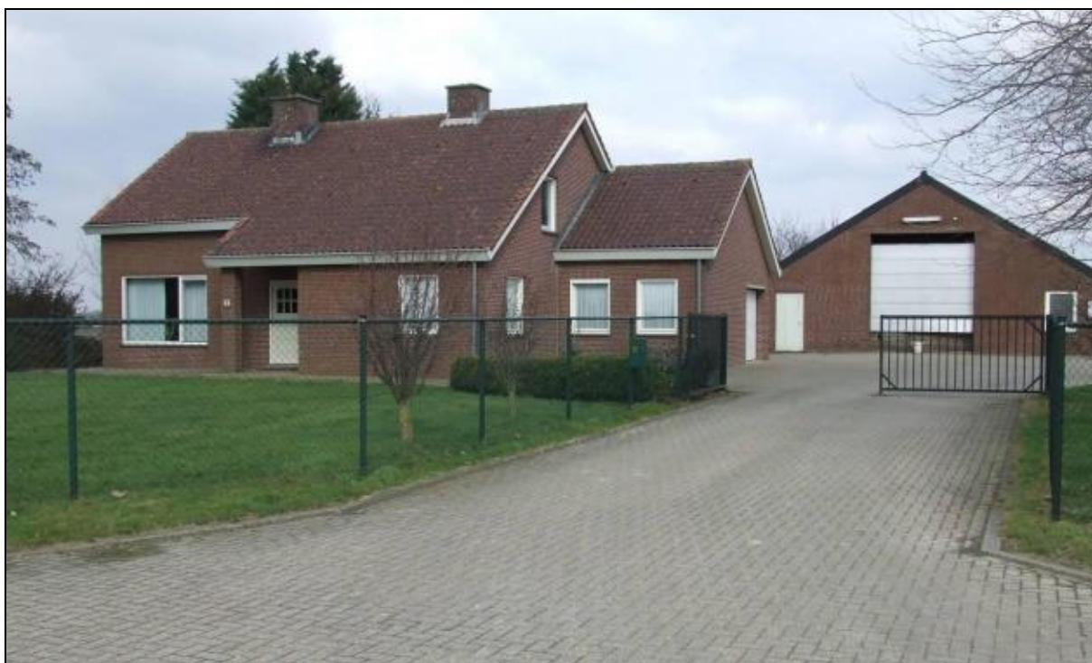
Figuur 18: De bedrijfswoning met tuin en toegang op het zuidelijke deel van het bedrijfsterrein met op de achtergrond rechts van de woning een rundveestal.
