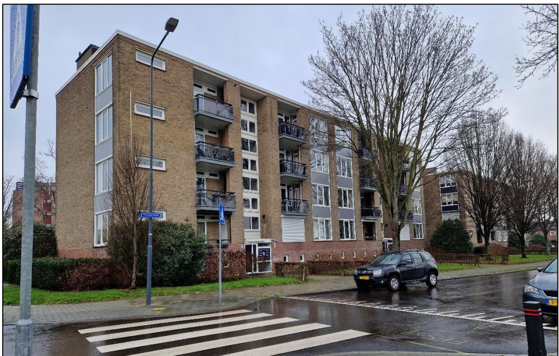
De vierlaagse appartementencomplexen aan de Vrangendael, ten westen van de projectlocatie
