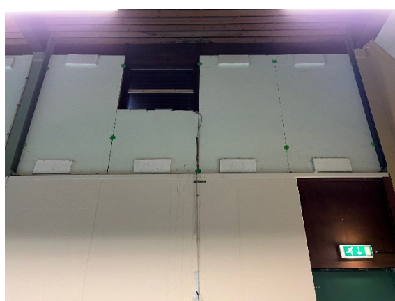
Figuur 17 Één van de vier te openen ramen
