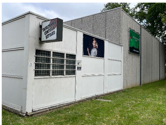
Figuur 14 Zuidgevel van de sportzaal
